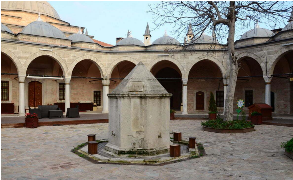
Şekil 2.28: Rüstem Paşa Medresesi görünümü (Kültür Envanteri).
