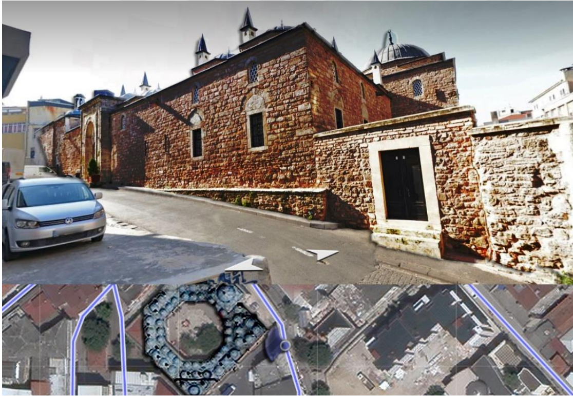
Şekil 4.51: Rüstem Paşa Medresesi panoramik görünüm (Yandex Panorama).
