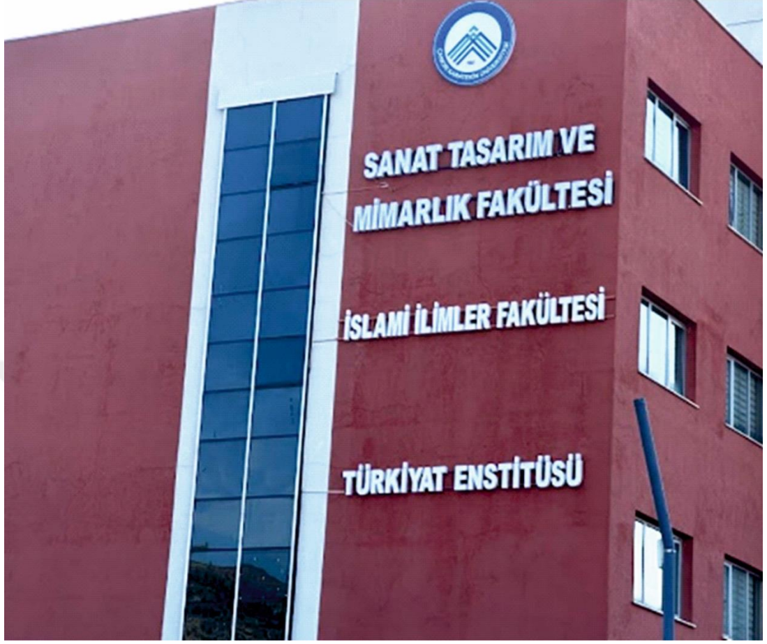
Görsel 5. 10. Bina Girişlerinde Kullanılan Farklı Boyutlardaki Tabela Örneği Örneği (Yazarın kişisel arşivinden, 2025).
