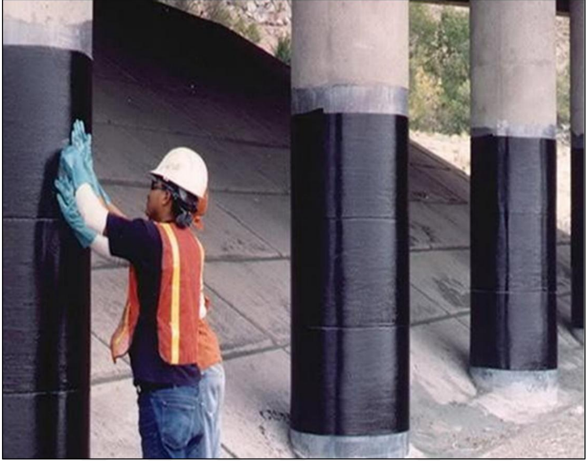
Resim 1.1. Beton kolonların frp ile sargılanması
