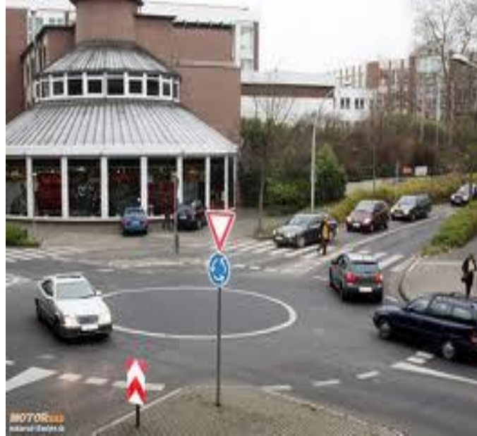
Şekil 2.4: Şekil 2.4. Yatay İşaretlemeli Dönel Kavşak Örneği
