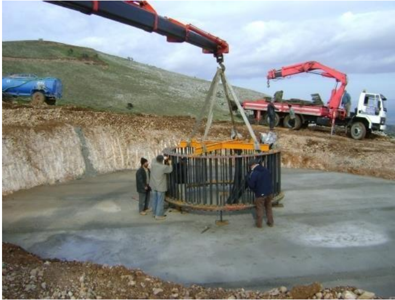
Şekil 3.1.4. Keltepe RES İnşaat Süreci
