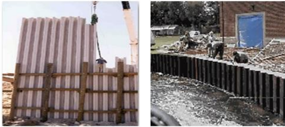
Şekil 2.12 Palplanş perdelerin yerleştirilmesi
