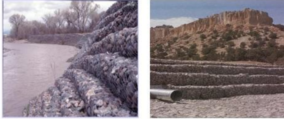
Şekil 2.13 Gabion duvar uygulaması
