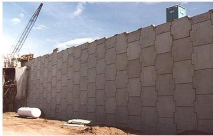
Şekil 2.6 Betonarme istinat duvarı örnek
