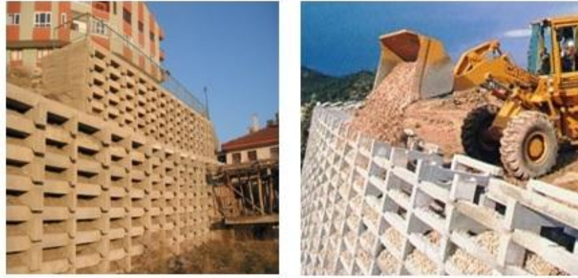
Şekil 2.10 Sandık duvarların uygulanması
