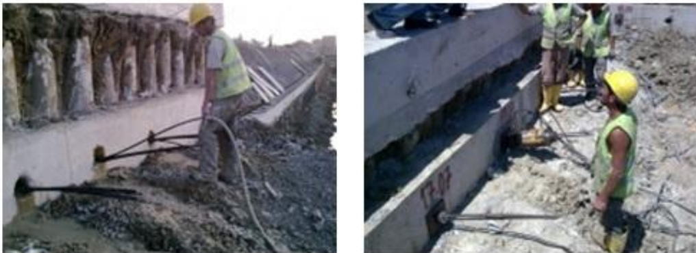
Şekil 3.6 Ankraj yapım aşamaları
