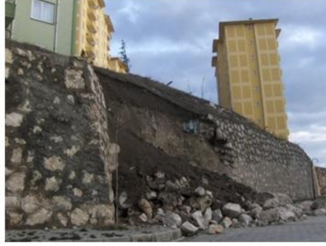
Şekil 2.5 Ağırlık tipi istinat duvarı örnek
