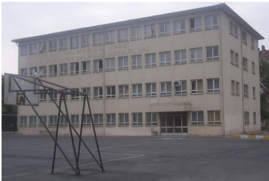
Bild 5.2: Ansicht der Schule
