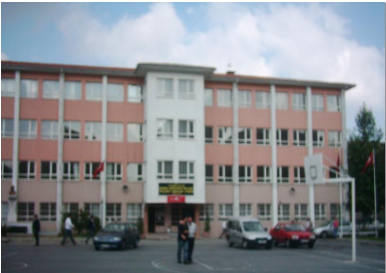
Bild 5.19: Ansicht der Schule
