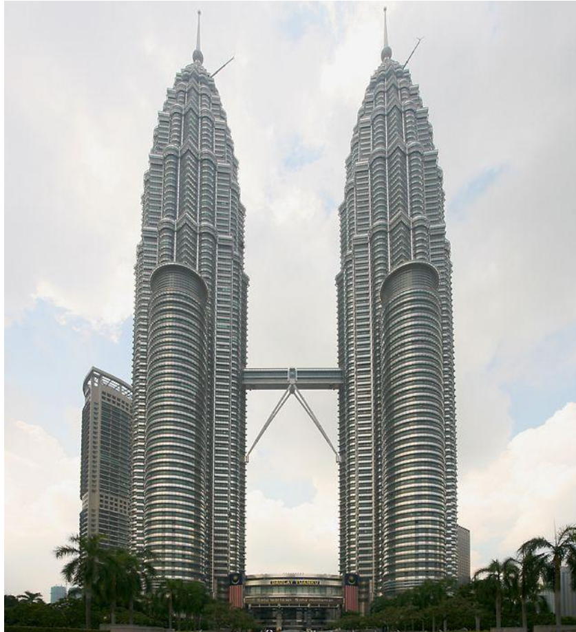
Şekil 4.9. Petronas Kuleleri, Kuala Lumpur, 1997 (URL-18).
