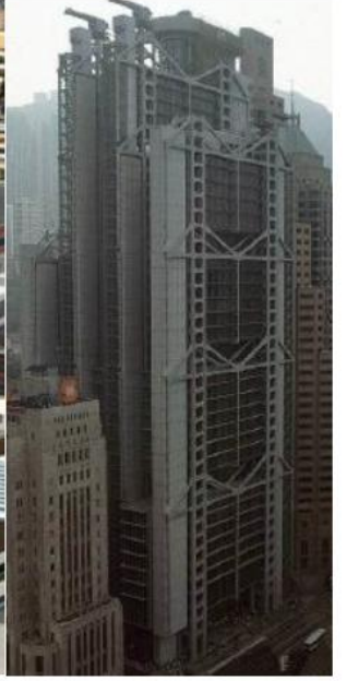
c)Hong Kong Binası
