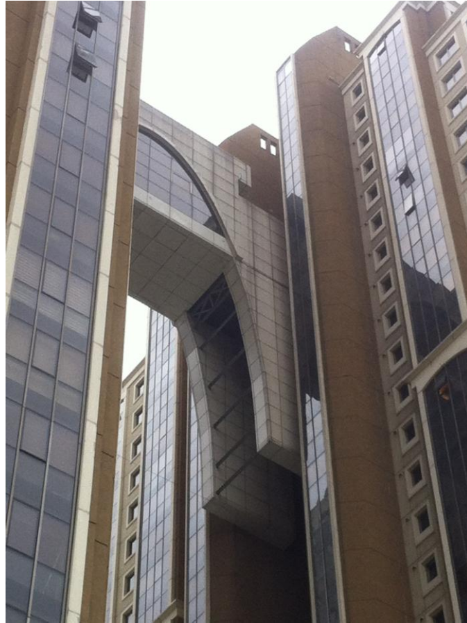
Şekil 5.60. Uphill Kuleleri, Gökköprü (Söyek, 2015).
