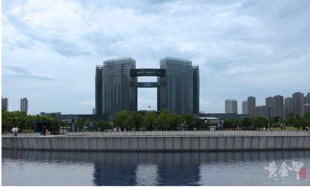
Şekil 5.49. Hangzhou Kuleleri, Gündüz Görünümü (URL-23).
