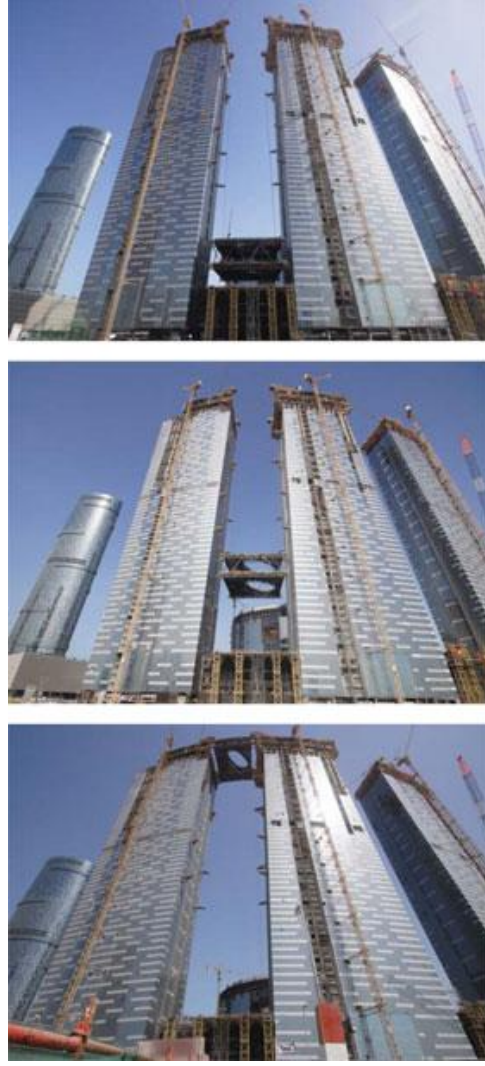
Şekil 5.16. Gate Kuleleri, Gökköprü Yapım.Aşaması.
