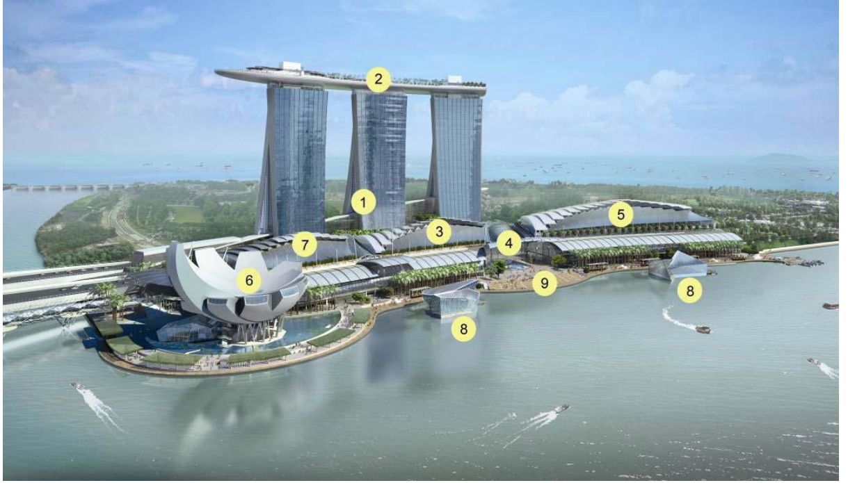
Şekil 5.7. Marina Bay Sands Kuleleri, Singapur: 1- Otel – 2.560 odalı lüks, 3 otel kulesi, 265 m 2 , 2- Gökköprü – 3 kuleyi gökyüzünde birleştiren yapı (200 metre yüksekliğinde) halka açık seyir terası, bahçeler, restoran ve yüzme havuzundan oluşuyor. 9,941 m 2 , Eiffel Kulesi'nden daha uzundur, 65 metrelik konsola sahiptir, 340 metre uzunluğundadır, 40 metre genişliğindedir, 1.396 m 2 yüzme havuzu vardır ve bu yükseklikteki en büyük havuzdur, park alanı 3.900 kişi kapasitelidir, 250 ağaç, 650 bitkiden oluşmaktadır, 3- Gazino, 4- Mağazalar – 74.322 m 2 , 5- Sergi ve Kongre–121.000 m 2 , 6- Müze – 15.000 m 2 , 7- Tiyatro –21.980 m 2 , 8- Kristal Pavyon –5.914 m 2 , 9 - Etkinlik Merkezi – 5.000 m 2 .
