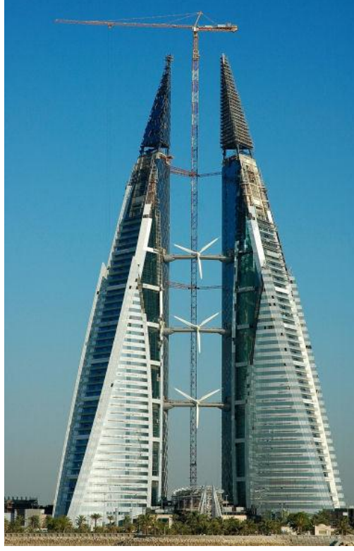
Şekil 5.54. Bahreyn Dünya Ticaret Merkezi, Yapım Aşaması.
