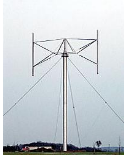
Şekil 2.9 Darrieus tipi rüzgar türbinleri
