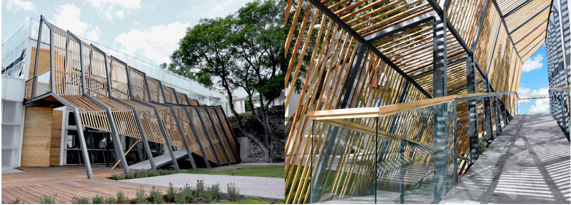
Şekil 2.20 Kullanılmayan bir binanın güzel sanatlar ve tasarım öğrencileri için yeniden dönüştürülmesi, Shine Architecture/TA Arquitectura, Monterrey Institute of Technology's Léon Campus [33]
