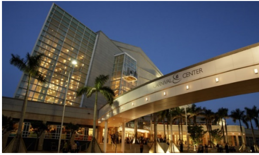
Şekil 3.8 Yapıları birleştiren köprü
