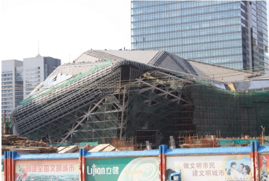
Şekil 3.107 Panellerin eklenmesi
