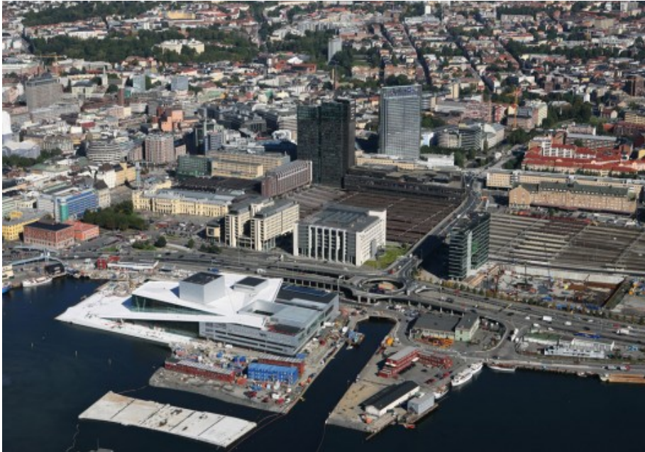
Şekil 3.49 Oslo Operası genel görünüş
