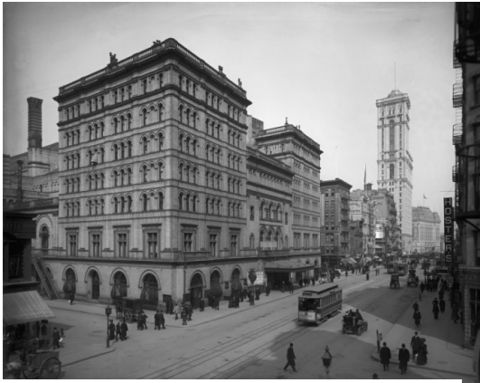
Şekil 2.139 Eski Metropolitan Operası dış görünüş
