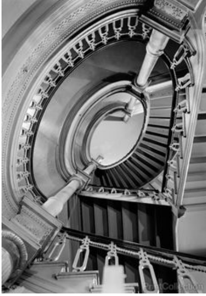
Şekil 2.141 Eski Metropolitan Operası merdivenler
