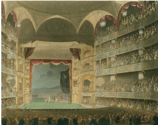
Şekil 2.54 Drury Lane parterden görünüş
