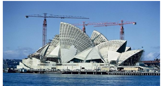
Şekil 2.152 Sydney Operası yapım aşaması
