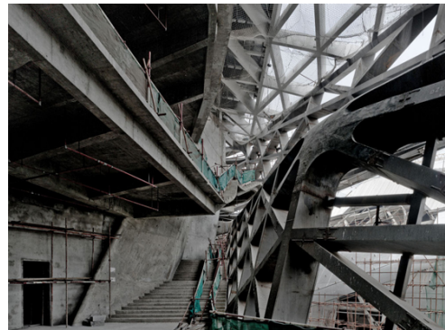
Şekil 3.108 Zarf sistemini tutan kiriş eklemler
