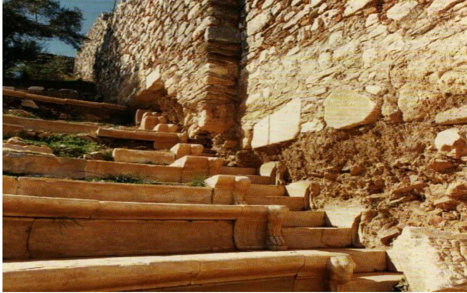
Resim 4.9. Cavea ortasından geçen sur duvarı (Meriç, 2003: 23)
