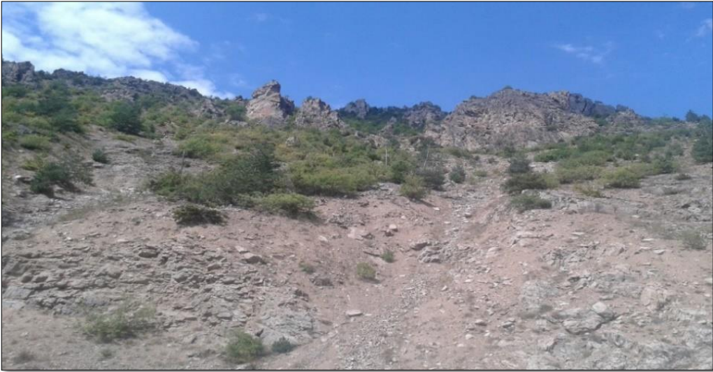
Şekil 3.8. Yol yapımı sırasında oluşan arazi tahribatı oluşan zararın görüntüsü
