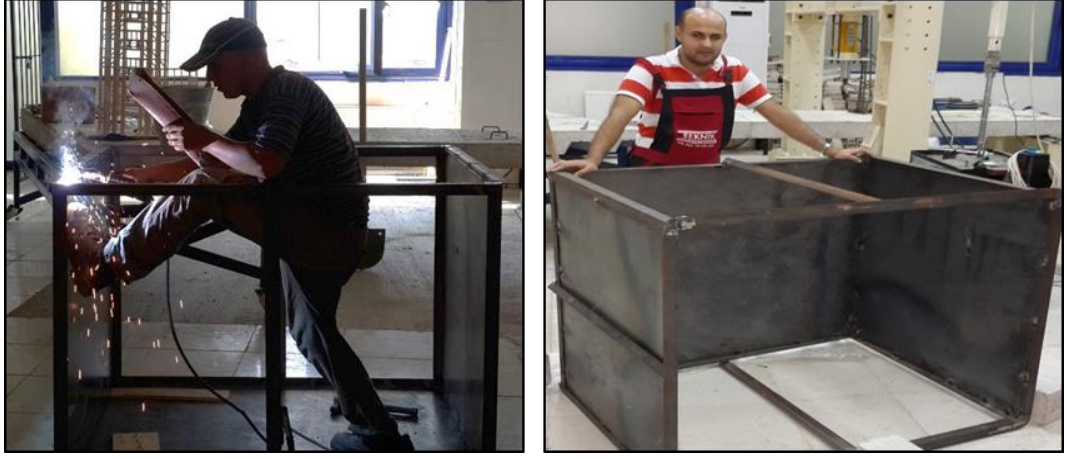
Şekil 3.12. Deney kasası yapım aşaması (a)
