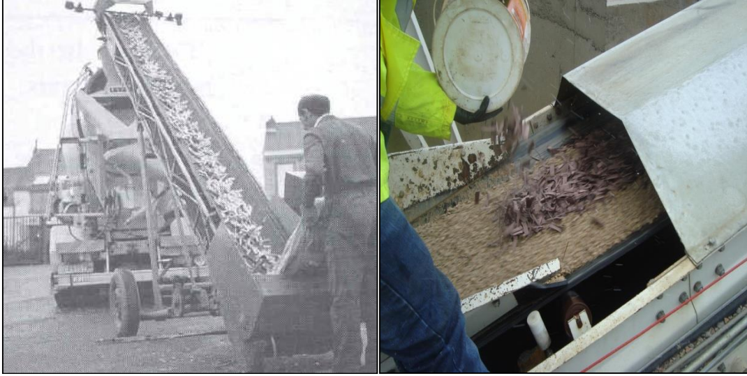
Fotoğraf 2.2. Beton santralinde liflerin karıştırılması yöntemi
