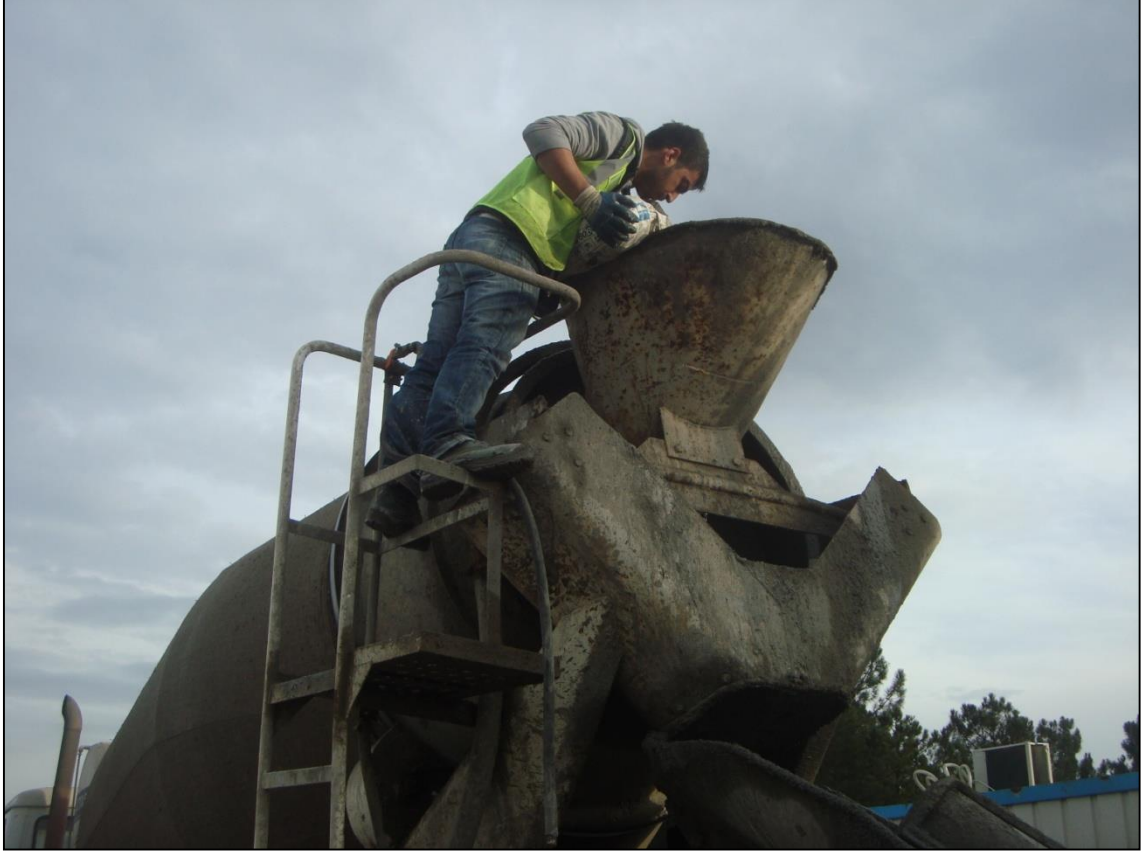
Fotoğraf 2.3. Transmikserde bulunan hazır betona çelik tellerin ilave edilmesi
