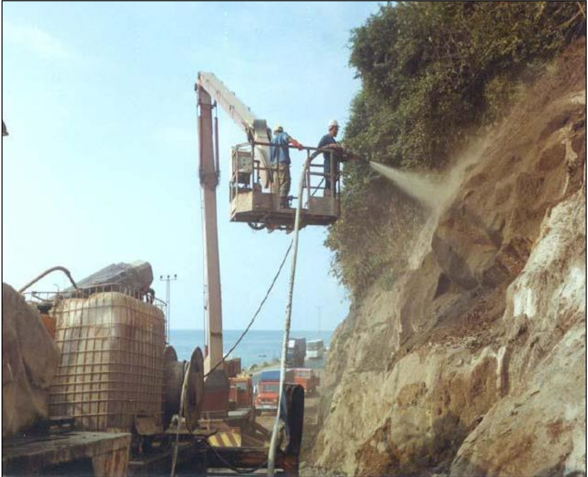
Fotoğraf 2.4. Çelik lifli betonun şev stabilitesinin sağlanması (Bekaert, 2011)
