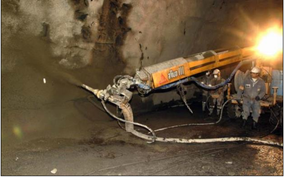
Fotoğraf 2.5. Çelik lifli yaş betonun püskürtme beton uygulaması
