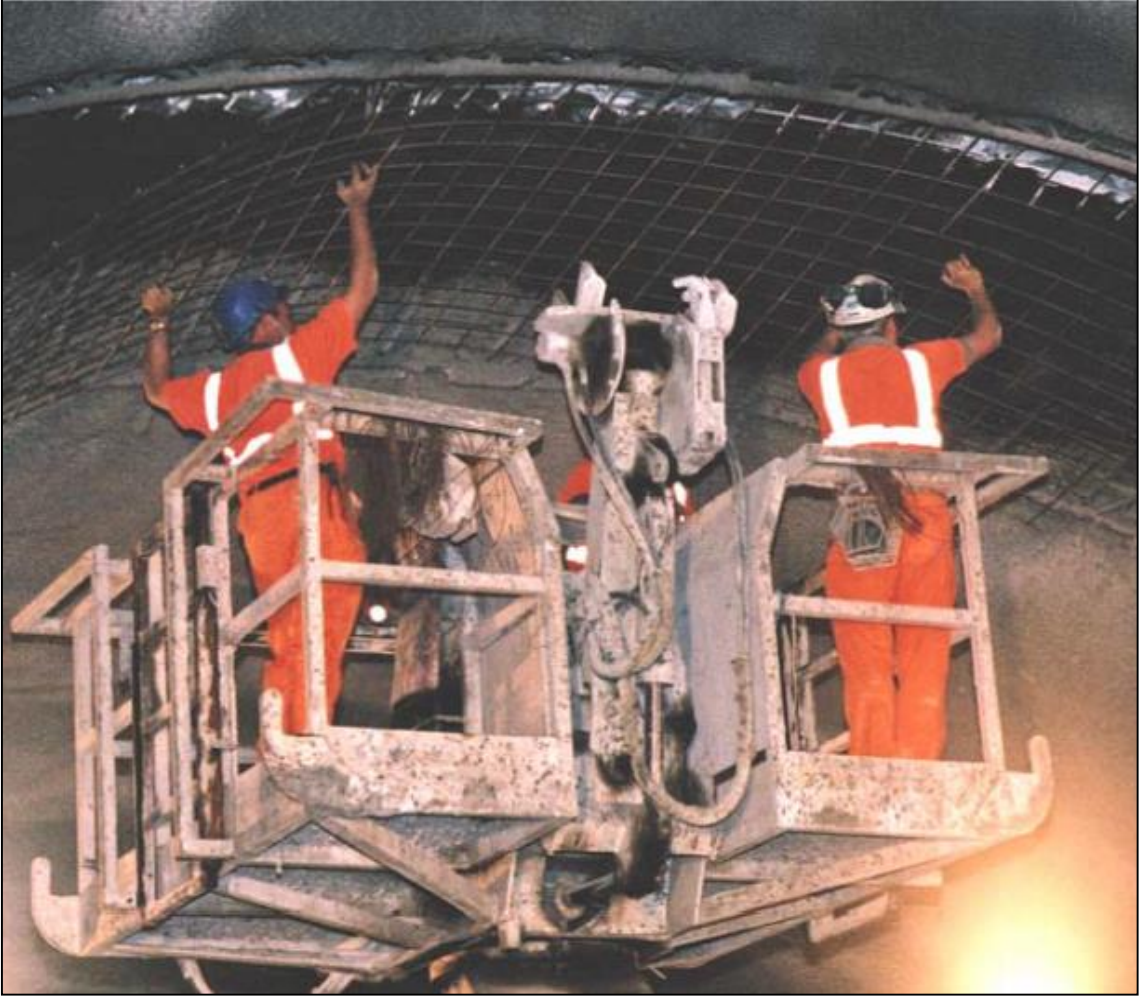
Fotoğraf 3.3. Tünelde çelik hasır montajı
