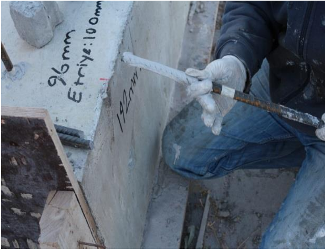
Şekil 3.16: Ankraj ekimleri yapılan deney elemanlarına ait görüntüler.
