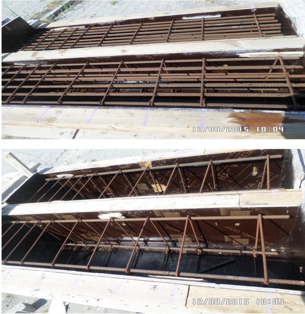
Şekil 3.9: Hazırlanmış kalıplara ait görüntüler.
