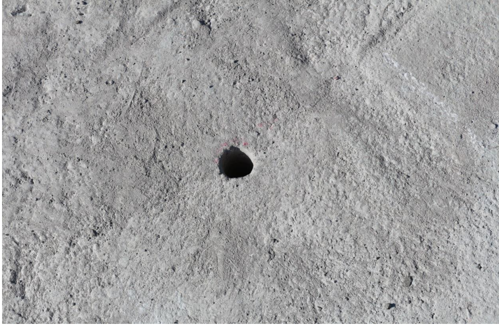
Şekil 3.13: Kolon elemanlarının ankraj deliklerinin açılmış görüntüsü.
