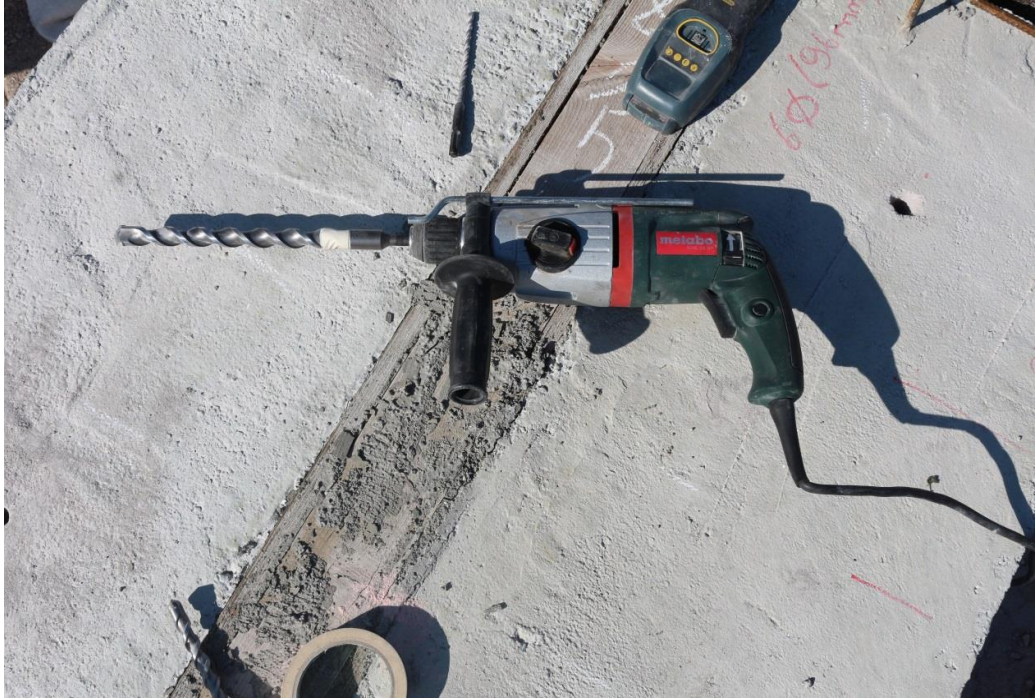
Şekil 3.12: Kolon elemanlarına ankraj delikleri açmak için kullanılan delici.
