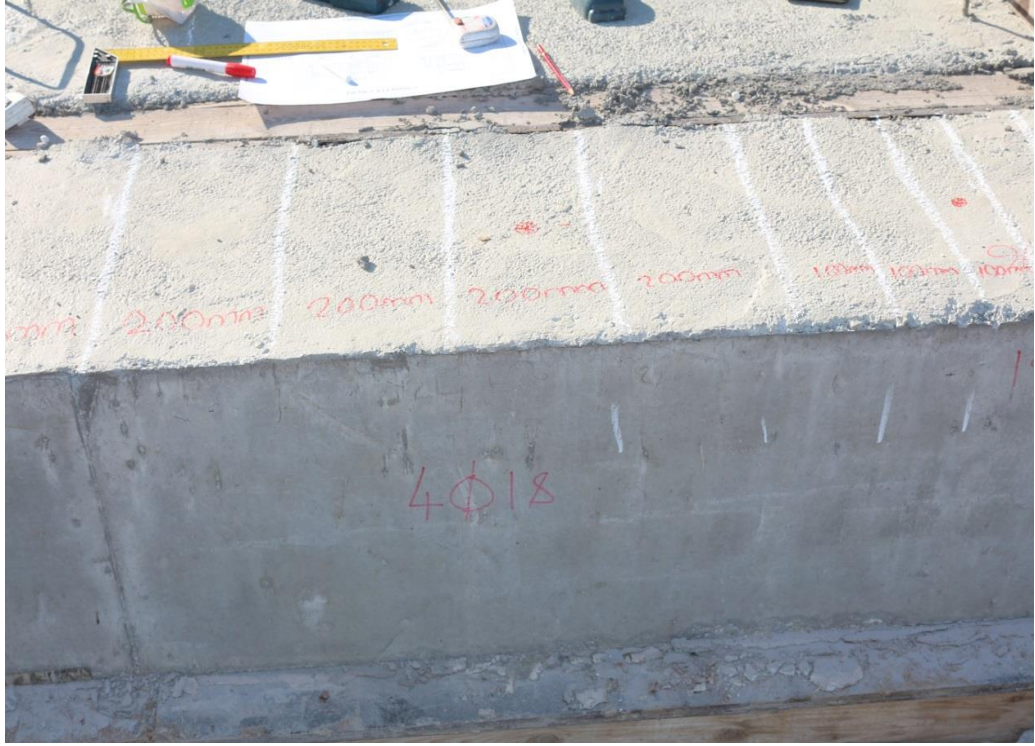
Şekil 3.11: Delik yerleri işaretlenmiş kolon elemanı.
