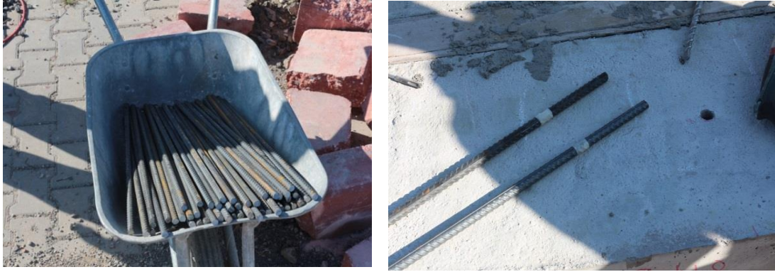
Şekil 3.14: Ankraj donatıları.
