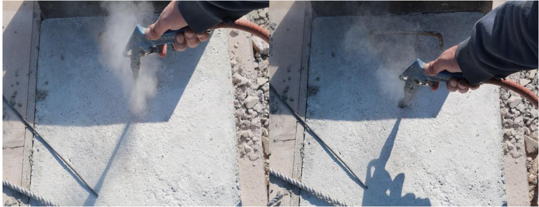
Şekil 3.15: Ankraj deliklerinin temizlenmesine ait görüntüler.
