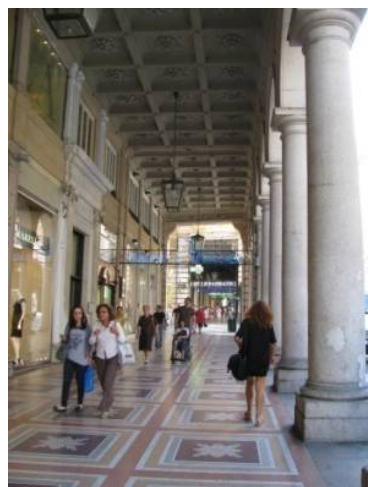
Figure 2.24 : XX Settembre arcades in Genova, Italy (URL-14).
