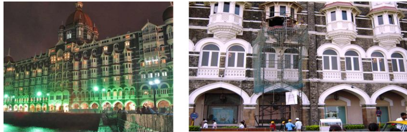
Şekil 3.8 Tarihi yapıda bir restorasyon uygulaması [228].
