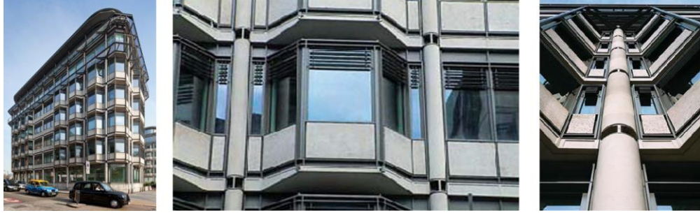
Şekil 3.9 Ofis Binası (Londra) cephe kaplaması, prekast kolonlar [229].
