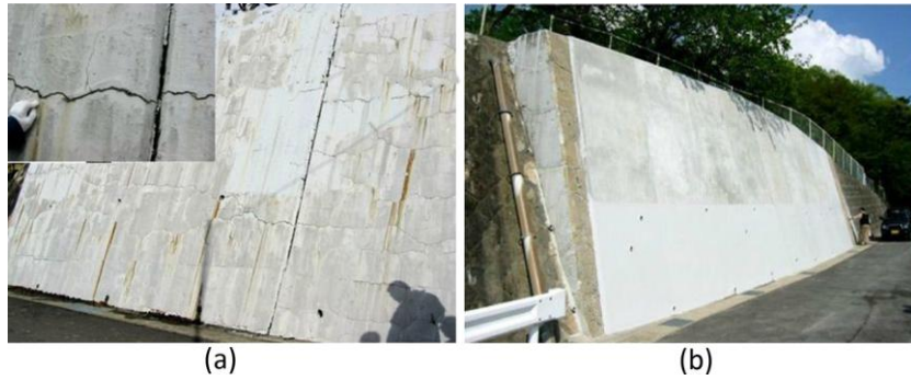
Şekil 3. 63 İstinat duvarı onarımı (a) onarımdan önce, (b) onarımdan sonra [273].
