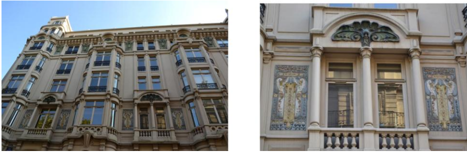
Şekil 2.8 Art Nouveau üslup özellikli prekast beton cephe (Paris) [27].
