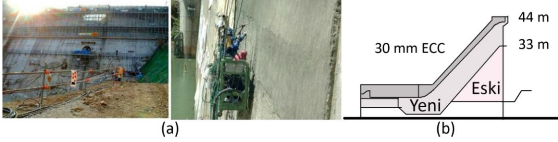
Şekil 3. 64 Püskürtme onarım uygulaması (a) püskürtme uygulaması, (b) anlatımlı gösterim [273].
