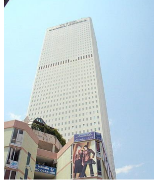
Şekil 2.31 Mertim binası (Mersin) [66].
