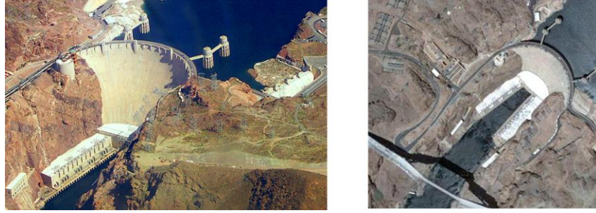
Şekil 2.15 Hoover barajı (Las Vegas) [39].
