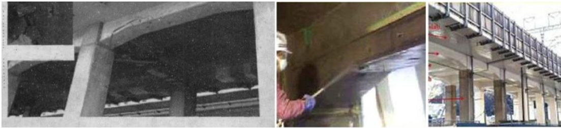
Şekil 3.66 Viyadük kiriş onarımı [271], [273].
