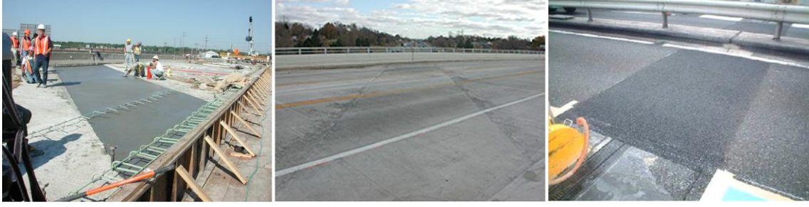
Şekil 3. 62 Grove Street Köprüsü (Michigan), ECC ile derzin ortadan kaldırılması işlemi [271-272].
