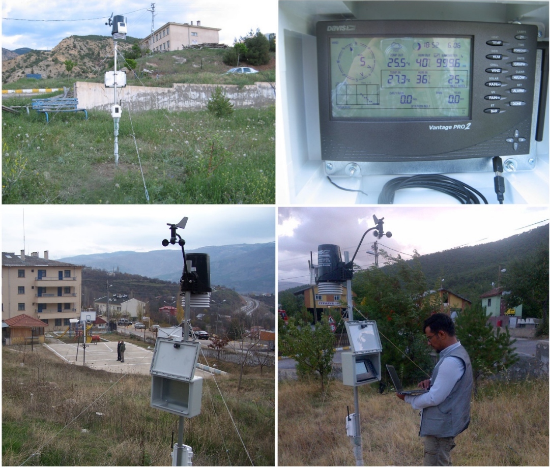
Şekil 3.53 Çalışma sahasına tesis edilen meteoroloji istasyonu.
