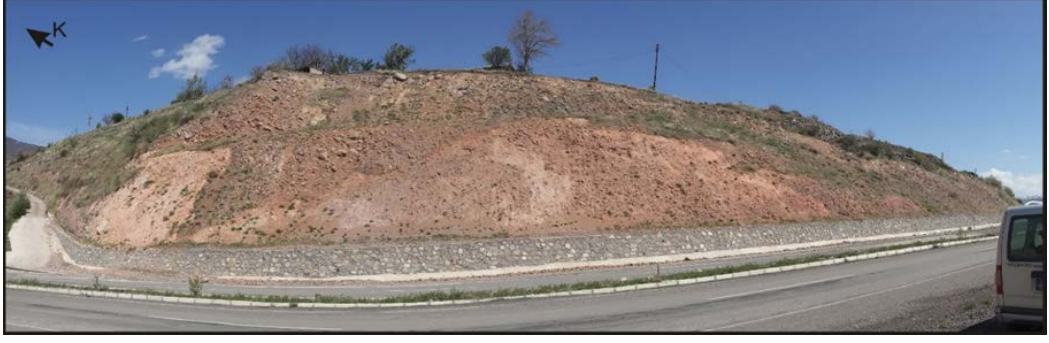
Şekil 3.9 Koyulhisar- Mesudiye karayolunda yol yarmasında yüzeyleyen Koyulhisar Formasyonuna ait görünüm.
