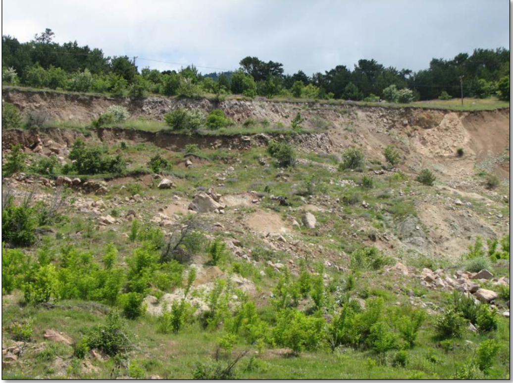
Şekil 3.38 Heyelan içerisinde meydana gelen basamaklar.
