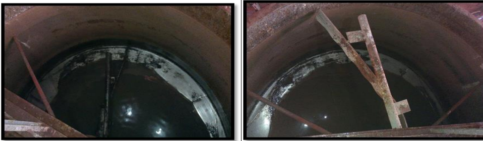
Resim 4.10. Karıştırıcı ve sıyırıcı sistem
