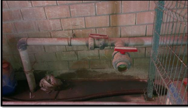
Resim 4.14. Kanalizasyon bağlantı noktası
