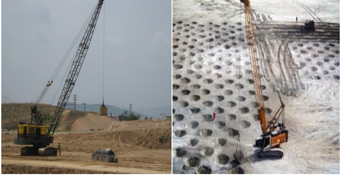
Şekil 2.5. Dinamik kompaksiyon uygulaması
