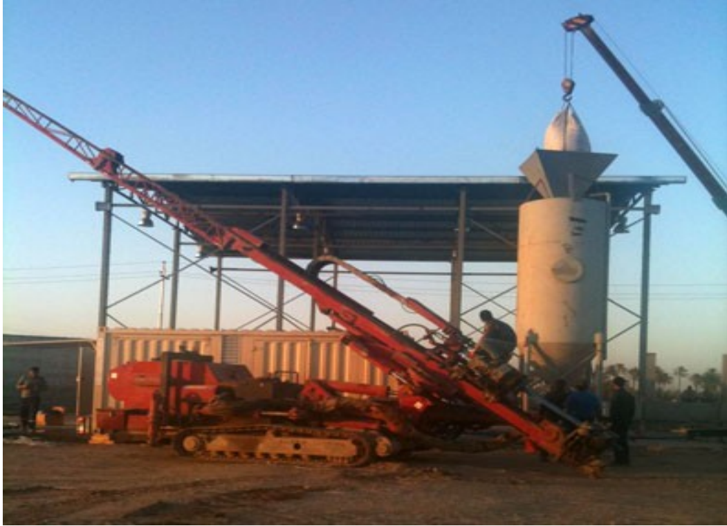
Şekil 2.6. Jet Grout uygulama ekipmanları
