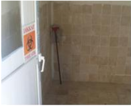
Şekil 10 : Serinhisar ilçesi tıbbi atık depo kapısı
