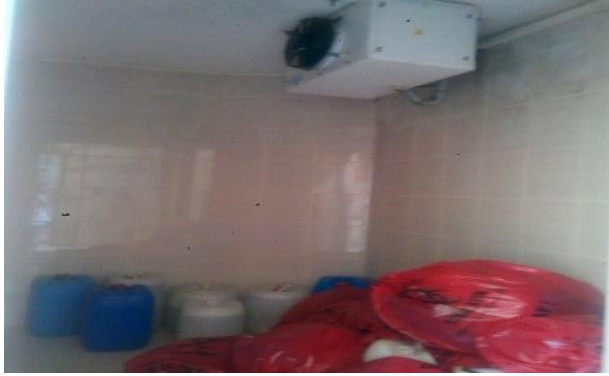
Şekil 13: Çardak Devlet Hastanesi Tıbbi Atık Deposu İç Bölümü
