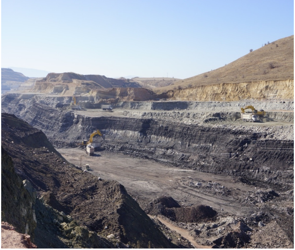
Şekil 6.6 S-49 panosundaki çalışmadan görünüm
