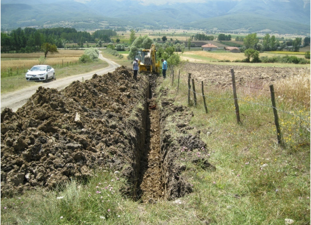
Şekil 1.11 Kazıcı yardımıyla hendek açımı.
