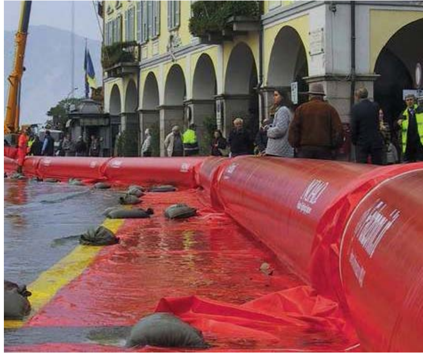
Şekil 6.8. 1997 yılında geliştirilen sistem, kauçuk ve polipropilenden üretilmiştir
