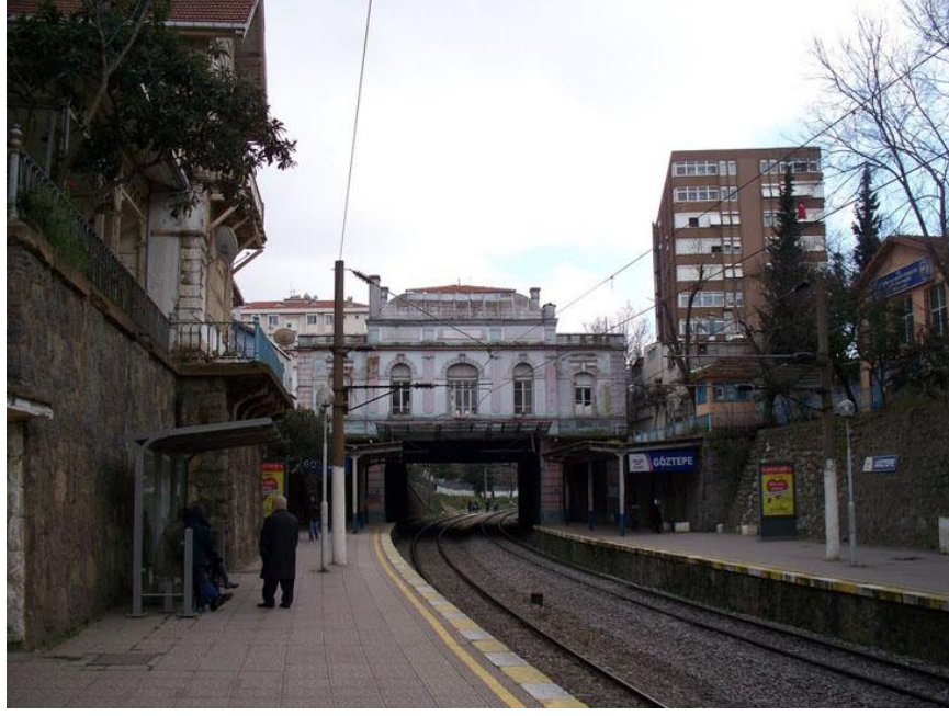
Şekil 3.14 Göztepe Tren İstasyonu
