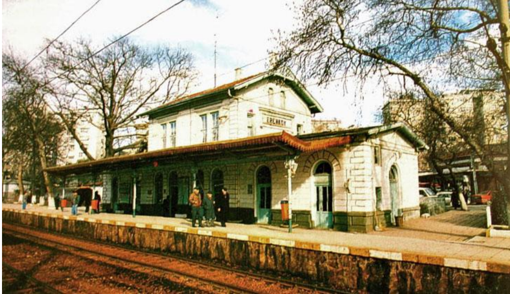
Şekil 3.13 Erenköy Tren İstasyonu
