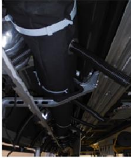
Şekil 6.3 : Tekstil hava kanalı bağlantı şekli.
