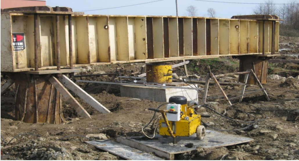
Şekil 3.26. Kazık yükleme deneyinden bir görünüm.
