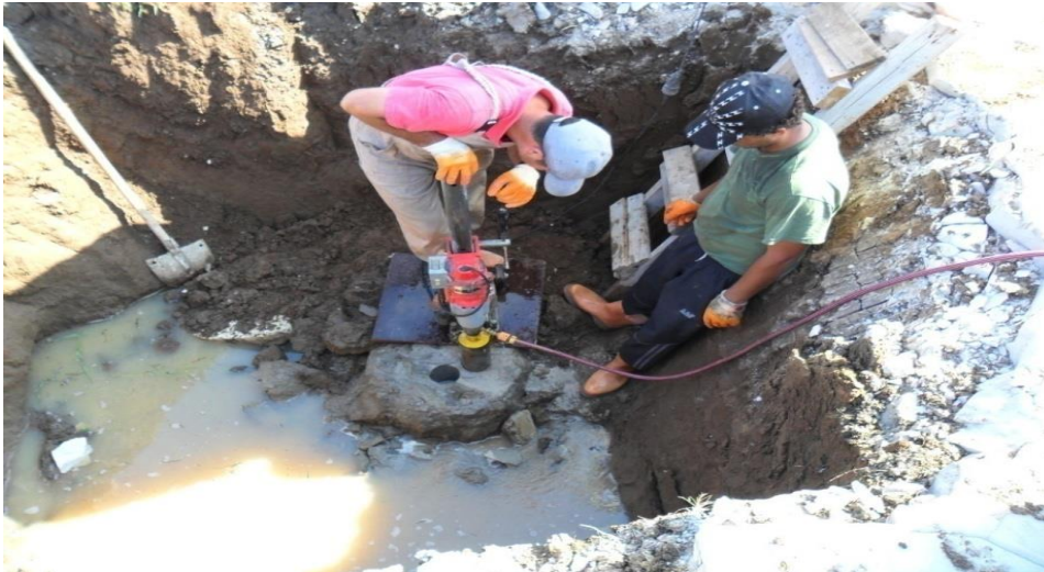
Şekil 3.25. Karot numunesi alımı.
