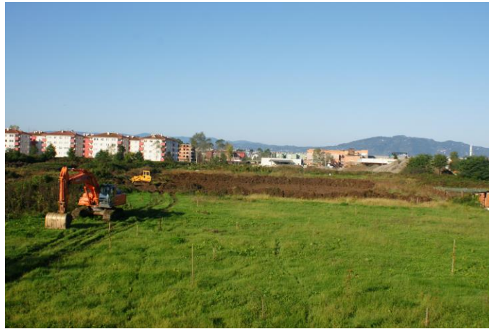
Şekil 4.2. Fen-Edebiyat Fakülte binasının inşa edileceği alanın tabii zemini.
