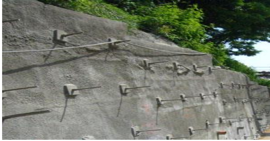
Şekil 2.26. Tamamlanmış bir zemin çivileme uygulamasından bir görünüm.
