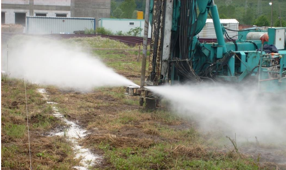
Şekil 3.1. Enjeksiyon aşaması (Nozzle' lardan grout çıkışı).
