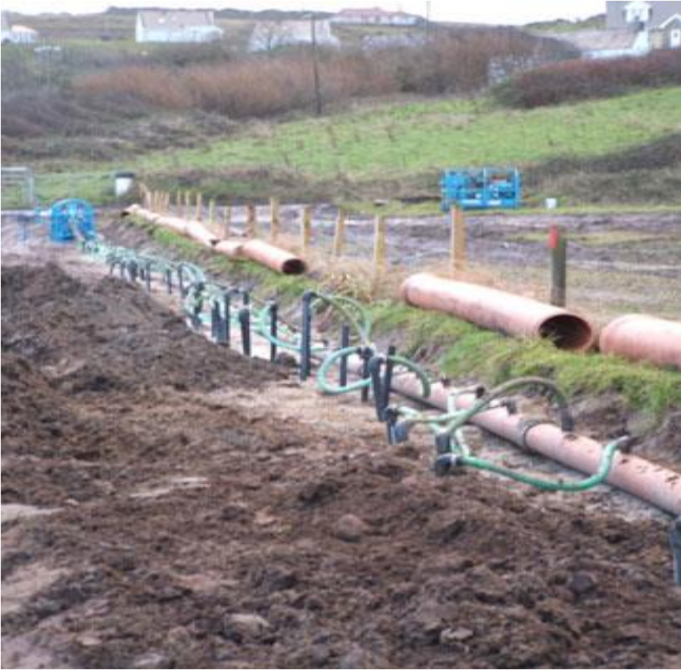
řekil 2.29. Su ekme ve kontrol yntemi uygulamasından bir grnt.
