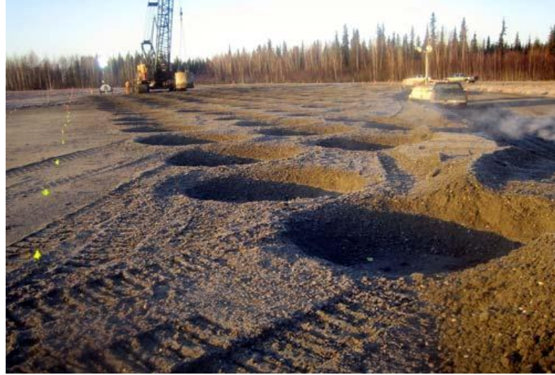
Şekil 2.20. Dinamik konsolidasyon uygulamasından bir görünüm.
