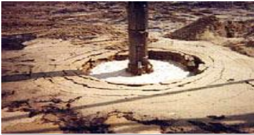
Şekil 2.12. Vibratörün çevresinde oluşan çözüntü konisi.
