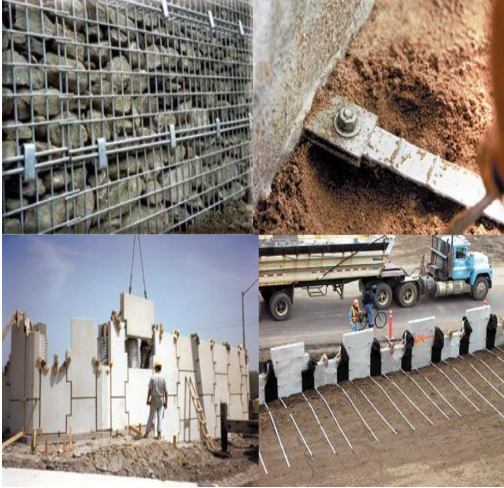
Şekil 2.27. Toprakarme uygulamasına ait detay görüntüleri.
