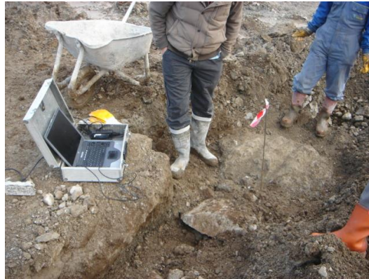
Şekil 4.12. Uygulama alanında yapılan bütünlük deneyinden bir görünüm.
