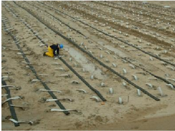
Şekil 2.9. Fitillerin zemine tatbik edilmiş hali.
