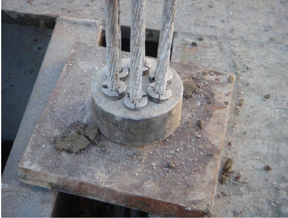
Şekil 4.15. Jet grout kolonunun içindeki çelik halatlar.
