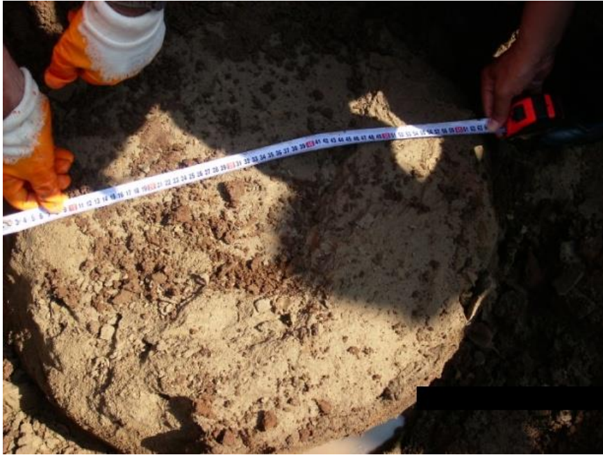
Şekil 3.30. Jet grout kolonunda imalat sonrası çap kontrolü.
