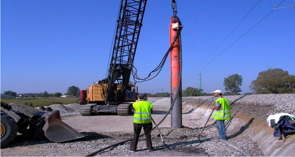
Şekil 2.15. Taş kolon imalatından görünüm.
