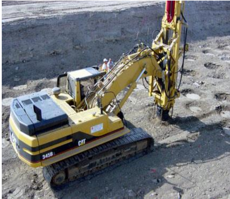
Şekil 2.4. Hızlı darbeli sıkıştırma işlemi.
