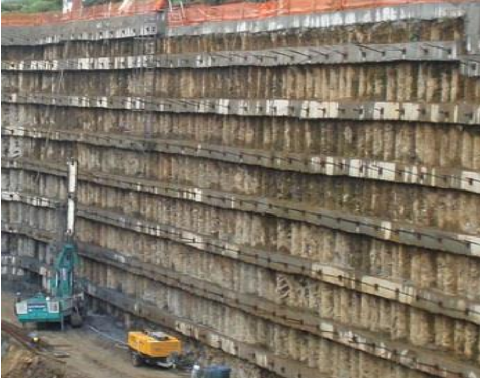
Şekil 2.24. Mini kazık uygulamasından bir görünüm.
