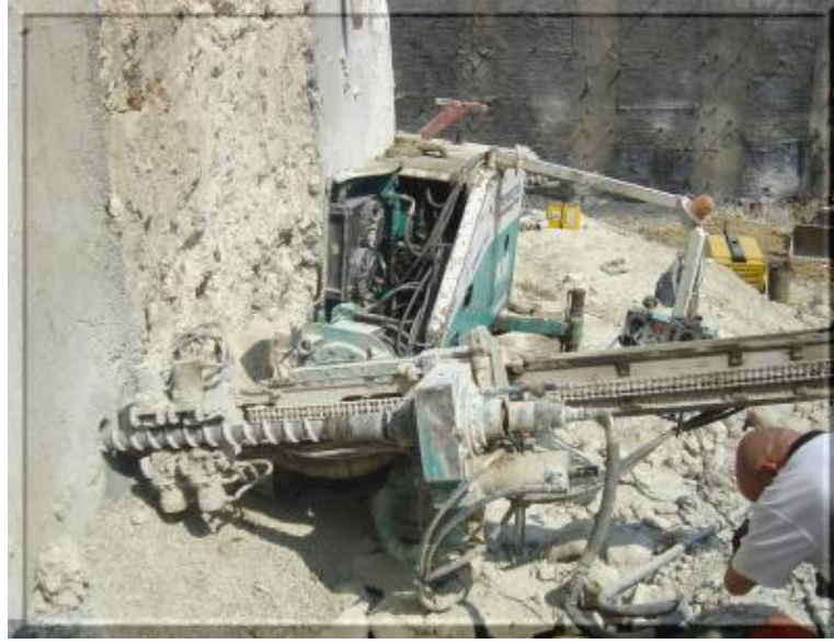
Şekil 2.25. Zemin çivileme uygulamasından bir görünüm.
