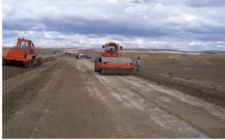
Şekil 2.1. Silindirle sıkıştırma işlemi.
