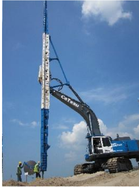
Şekil 2.8. Stitcher (dikici) dren makinesi.
