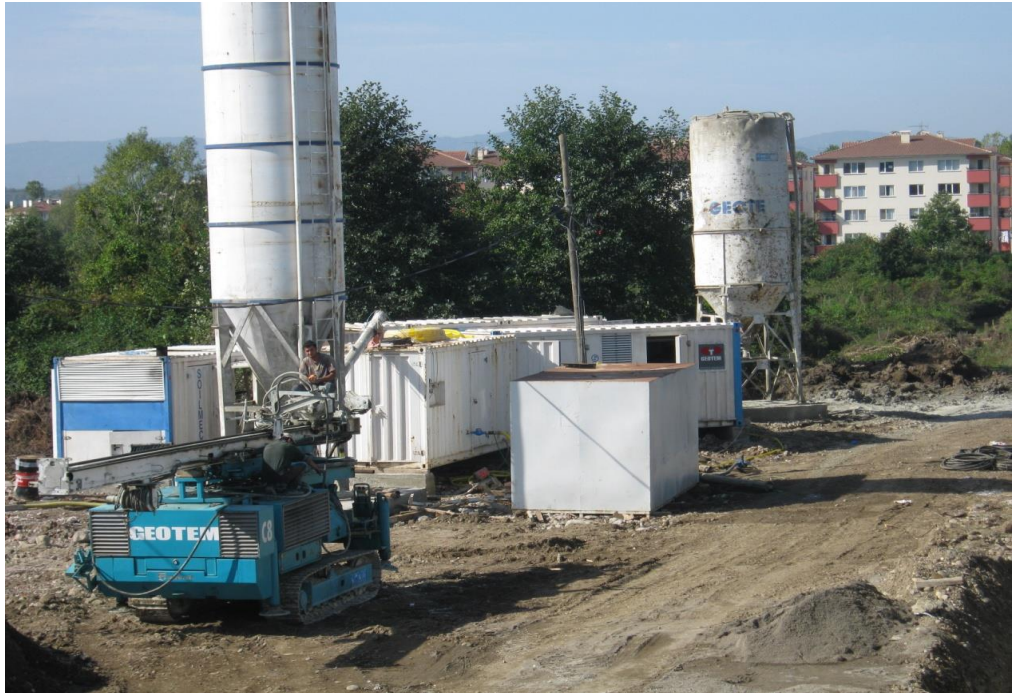
Şekil 3.3. Jet grout ekipmanlarından genel bir görünüm.
