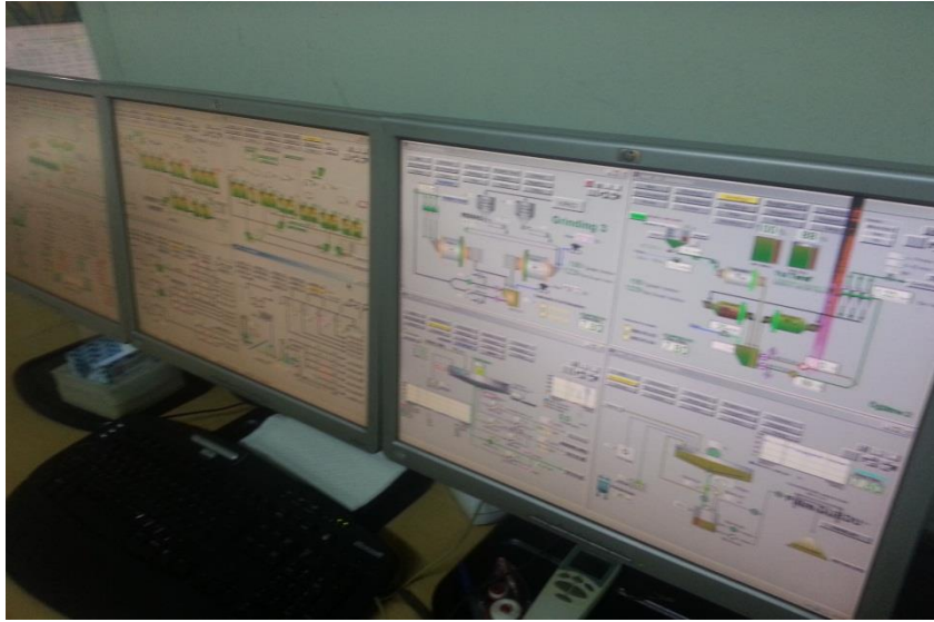
Şekil 4.4. Otomasyon Sistemi SCADA Bilgisayarları
