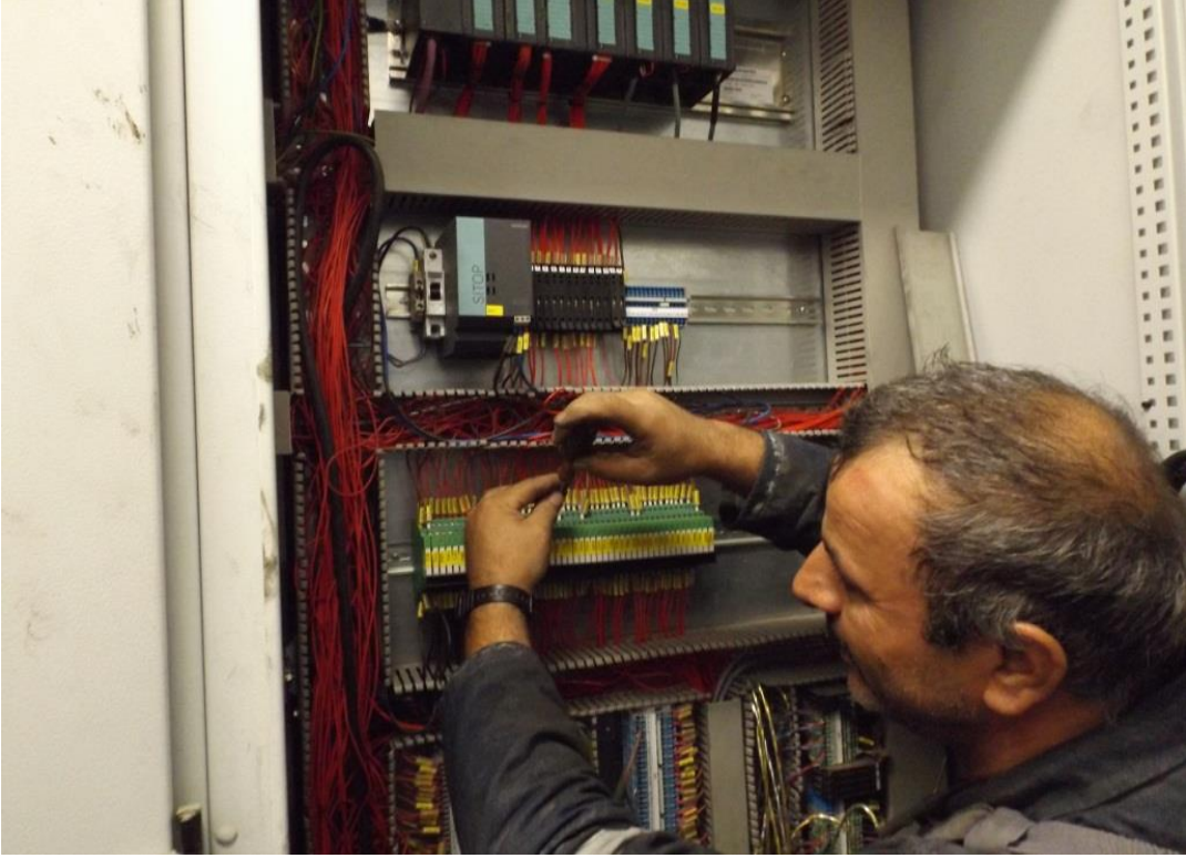
Şekil 5.16. PLC Panosu Montajı
