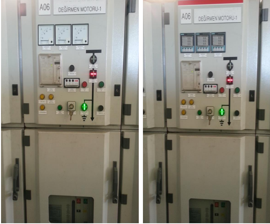
Şekil 4.3. Otomasyon Öncesi ve Sonrası Enerji Ölçü Aletleri
