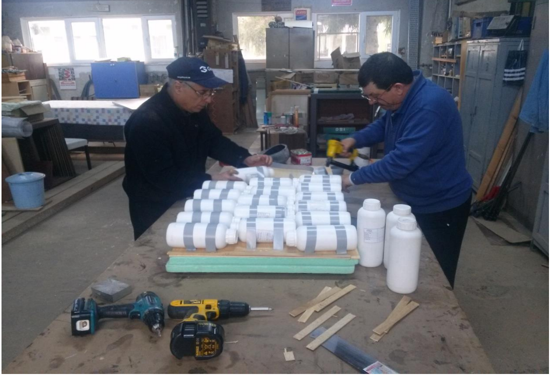
Şekil 5.2 : Yüzer platformun alt kısmı imal edilirken.
