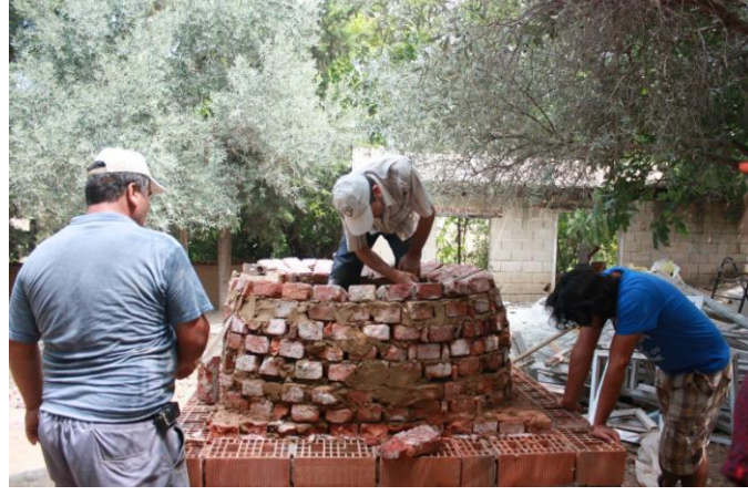
Şekil 4.9 : Fırının yapımı (Url-6).
