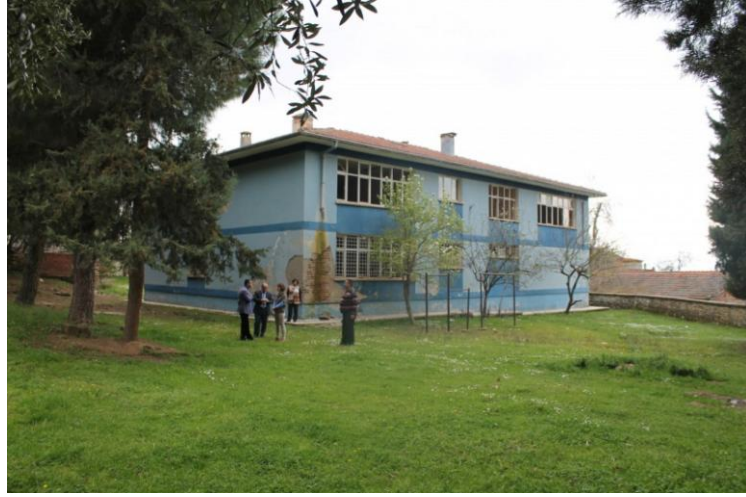
Şekil 4.2 : Ovakent'teki atıl okul (HİM Arşivi).
