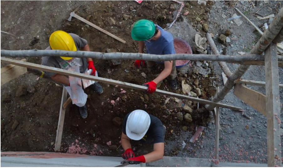
Şekil 4.1 : Kargı Projesi uygulama atölyesi (Url-1).
