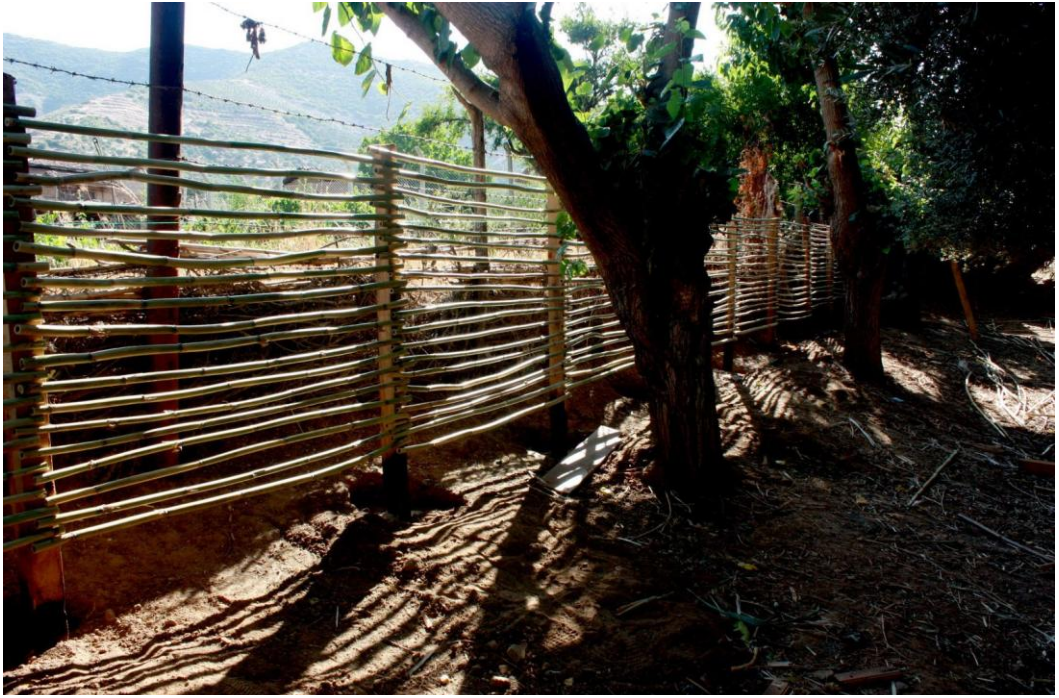
Şekil 4.8 : Çevreden toplanan sazlarla üretilmiş çit (Url-6).
