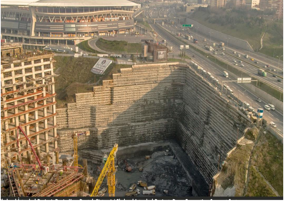
Şekil 2.24 : Skyland-İstanbul Derin Kazı İksa Projesi, öngermeli ankraj miktarı ~195,000 m (KASKTAŞ,2013)
