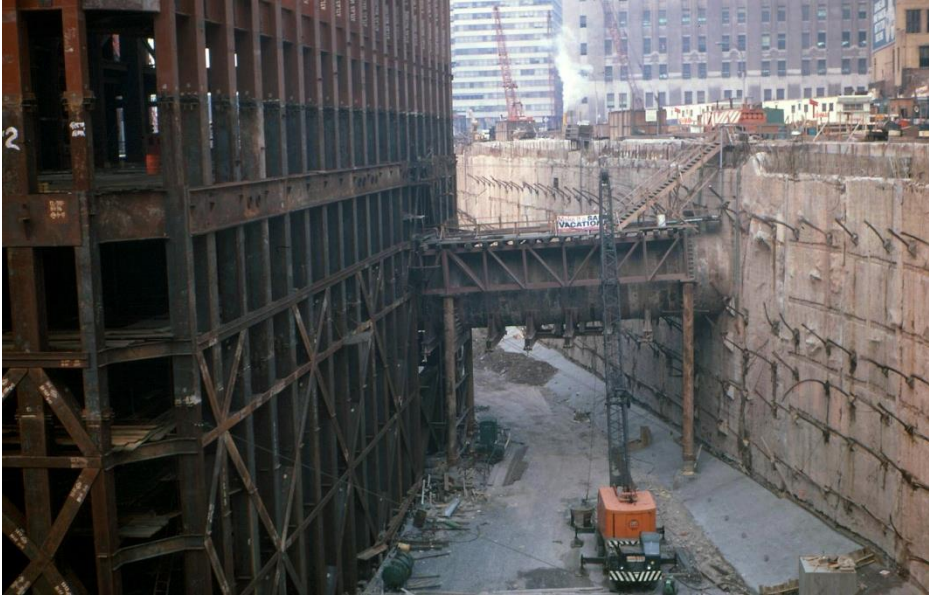
Şekil 2.21 : Dünya Ticaret Merkezi güney cephesi için uygulanan ankrajlı diyafram duvar dayanma yapısı-1968 ( http://www.skyscrapercity.com )
