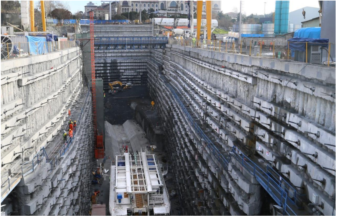
Şekil 2.25 : İstanbul Boğazı Tüp Geçiş Projesi-TBM Makinesi Asya Giriş Kutusu, öngermeli ankraj miktarı ~83,000 m (KASKTAŞ,2012)
