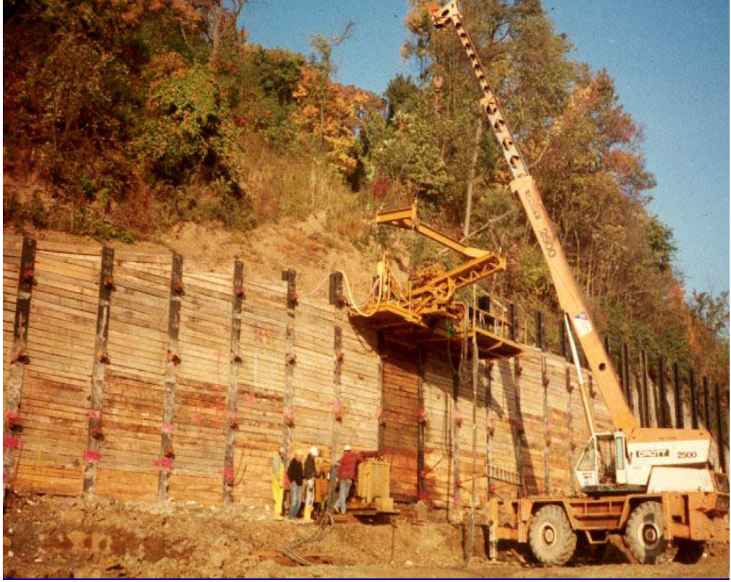
Şekil 2.22 : U.S 22 / S.R 7 Değişimi Projesi, kalıcı zemin ve kaya ankrajlı dayanma yapısı - Ohio-Steubenville, ( http://www.dot.state.oh.us )
