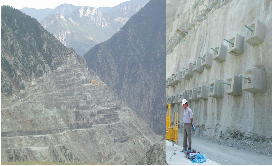
Şekil 2.23 : Deriner Barajı ve Hidroelektrik Santrali Projesi-Kalıcı ankraj imalatı, ~14,000m (KASKTAŞ,2003)
