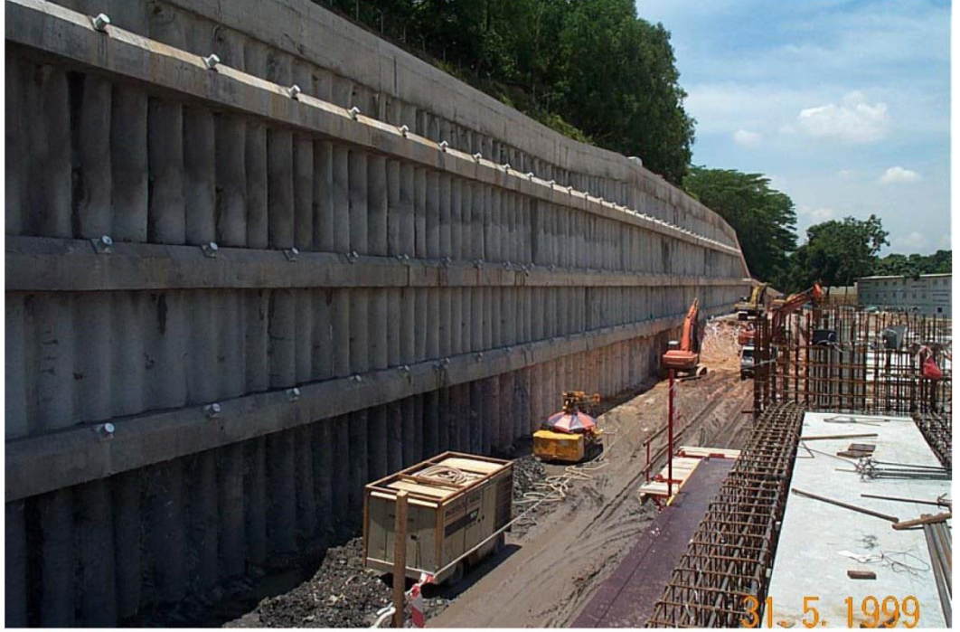
Şekil 5.10 : Singapur'da gerçekleştirilen kazıklı iksa duvarında kullanılan 150 ton servis yüküne sahip ankraj uygulaması (Barley ve diğerleri, 2003)
