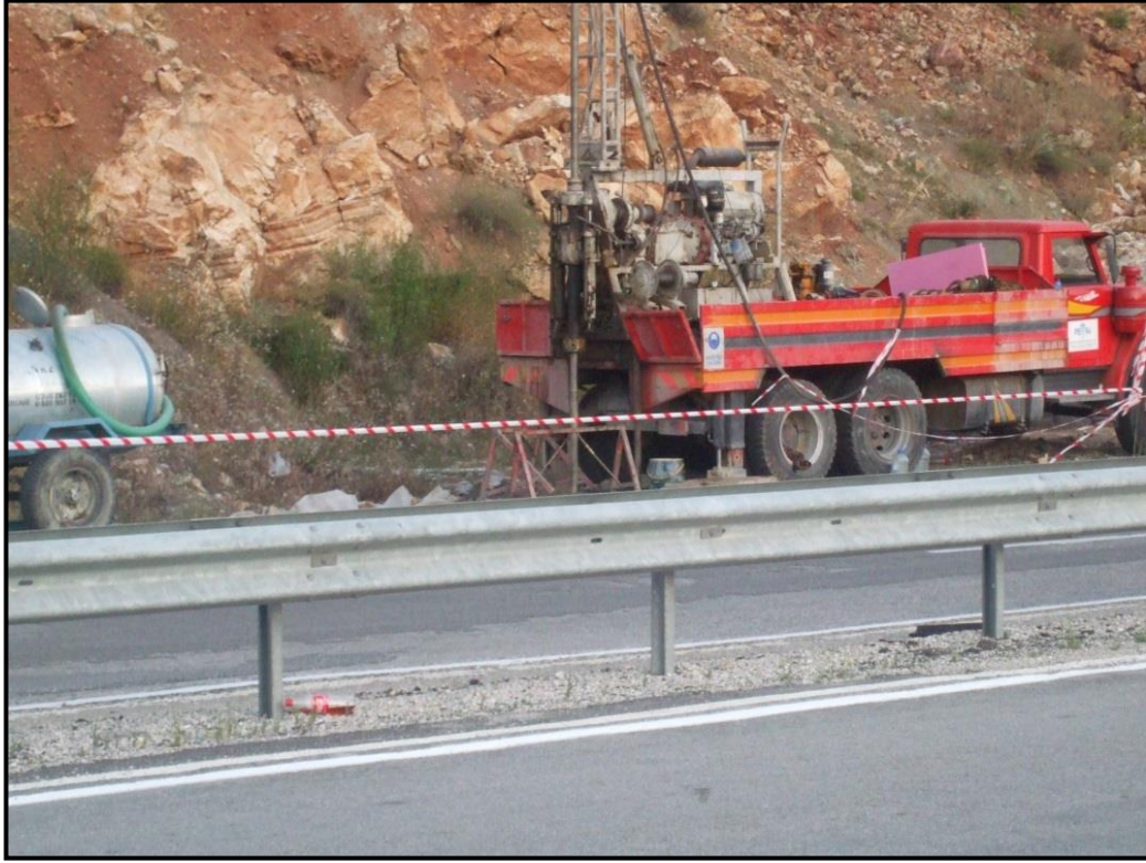
Şekil 5.7. Sahada yapılan sondajlar (SK-7)
