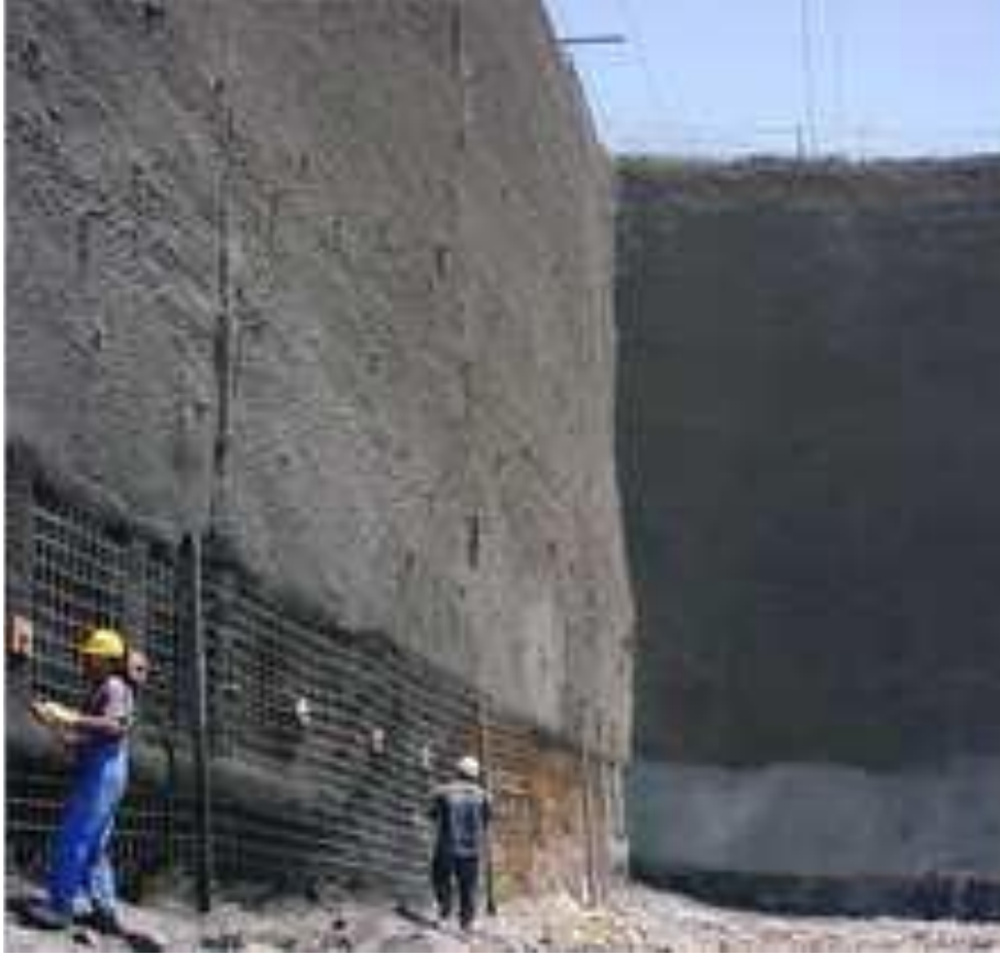
Şekil 4.26. Zemin çivisi uygulaması
