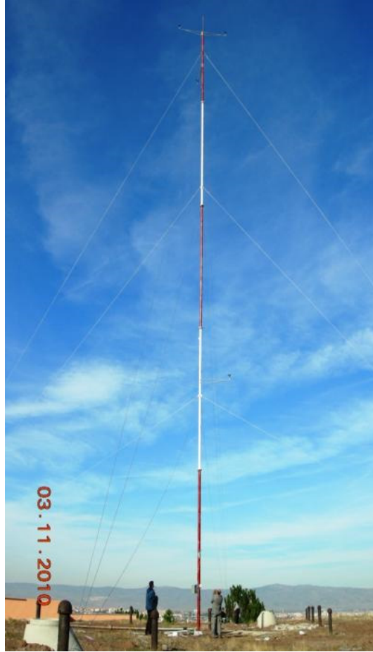
Şekil 3.5. Ölçüm istasyonunun monte edilmiş durumdaki görünümü
