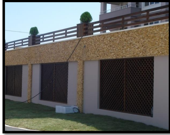
Şekil1.21. Traverten, patlatma işlemi yapılmış haliyle duvar kaplaması
