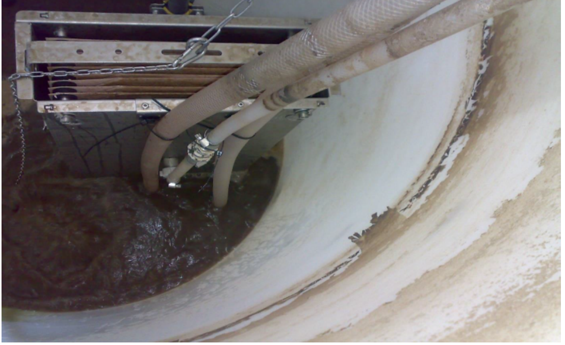
Şekil 3.3 : Membran kasetinin tank içinde görünümü.
