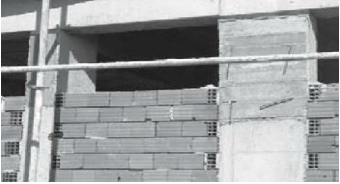
Şekil 2.3. Kolonda oluşturulan soğuk derz
