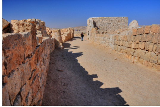
Şekil 3.8 : Kısmen yıkılmış yapıların gölgeleme durumu.
