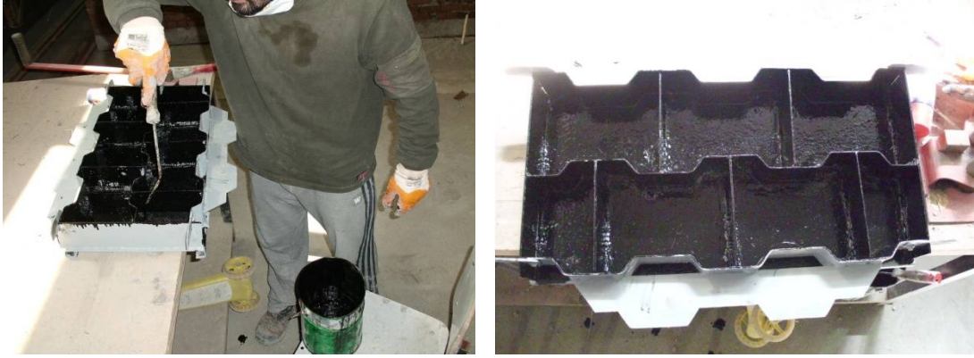
Şekil 3.9. Parke taşı kalıplarının yağlanması
