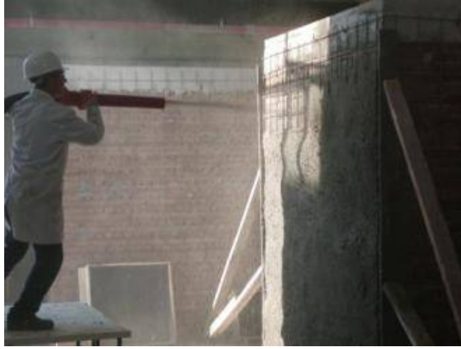
Şekil 3.4. Tuğla duvar numunelerine kuru karışım püskürtme beton uygulanması (TÜBİTAK 111M335, 2013)
