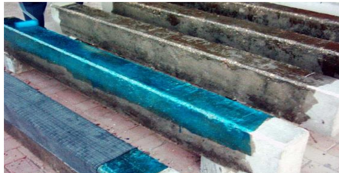
Şekil 2.3. Kiriş yüzeylerinin hazırlanması ve epoksi ile FRP liflerin yapıştırılması (Özcan ve Yöntem,2005).
