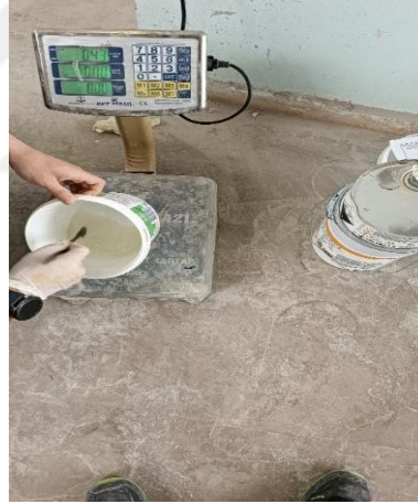
Şekil 3.32. Epoksi esaslı astar hazırlama işlemi
