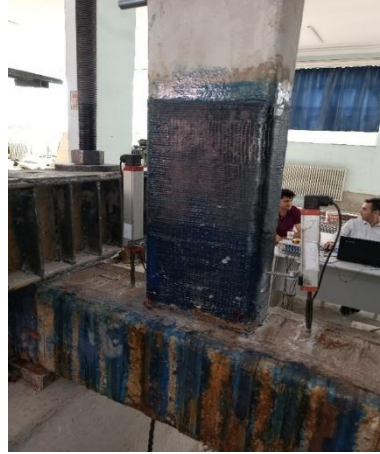
Şekil 4.63. Numunede +2. çevriminde meydana gelen 0.9 mm kalınlığa sahip çatlak görüntüsü
