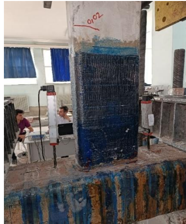
Şekil 4.65. +4. Çevrimde birleşim bölgesindeki çatlağın 2 mm kalınlığa ulaştığı görüntü
