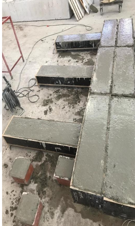
Şekil 3.9. Betonu dökülmüş deney numuneleri
