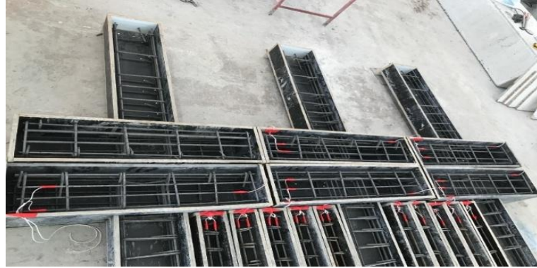
Şekil 3.8. Donatıları yerleştirilmiş deney numuneleri
