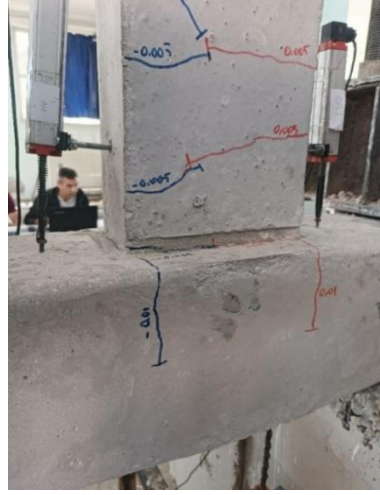
Şekil 4.5.Kolonda itme anında meydana gelen ilk çatlak
