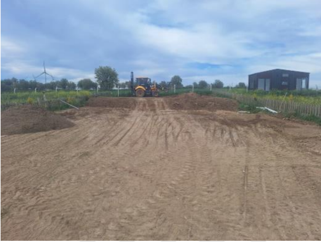
Şekil 23. Arazinin düzlenmesi
