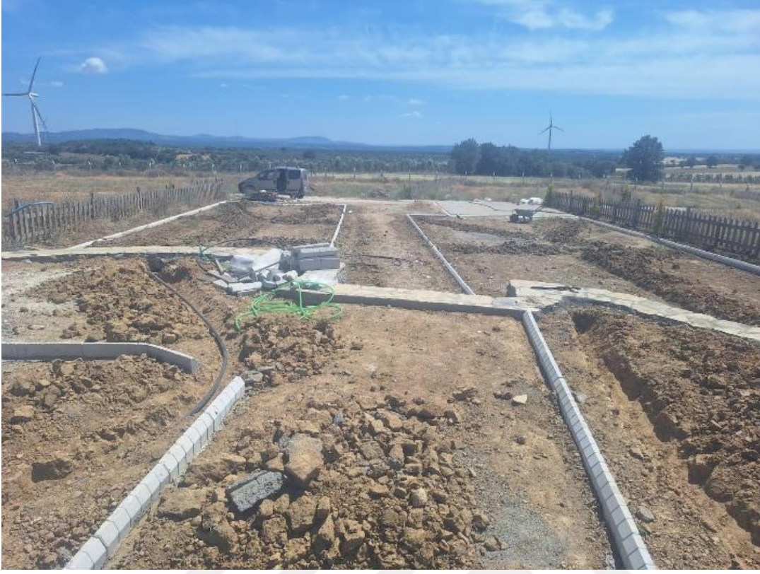
Şekil 24. Boru hatlarının kazılması ve yerleştirilmesi
