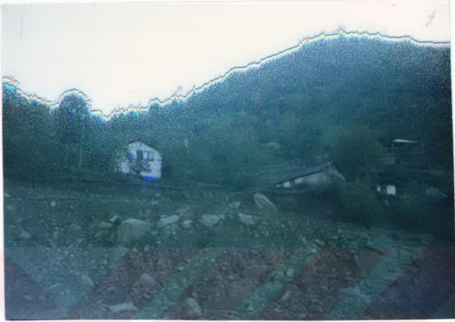
Fotoğraf 2.5.Çatak köyündeki eski,tek ve çift katlı konutlar ve eklentileri.
