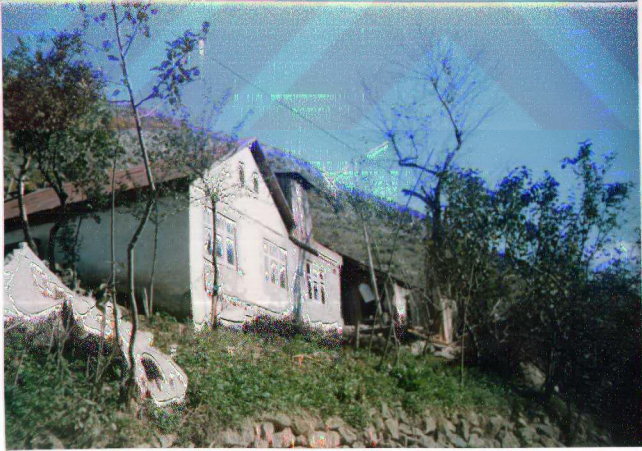
Fotoğraf 2.4.Taşaltı mahallesi'nde 25 yaşından daha eski, çita arası dolgu formunda inşa edilmiş bir konut ve ona bitişik konumda,sonradan biriktikten yapılmış tek katlı eklenti.
