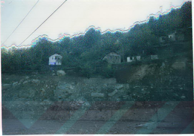
Fotoğraf 2.2. Meyvalık mahallesi'nden bir görünüş. E-390 Karayolu'nun kenarındaki istinat duvarı ile eski heyelan döküntüsü üzerine kurulu konutlar.
