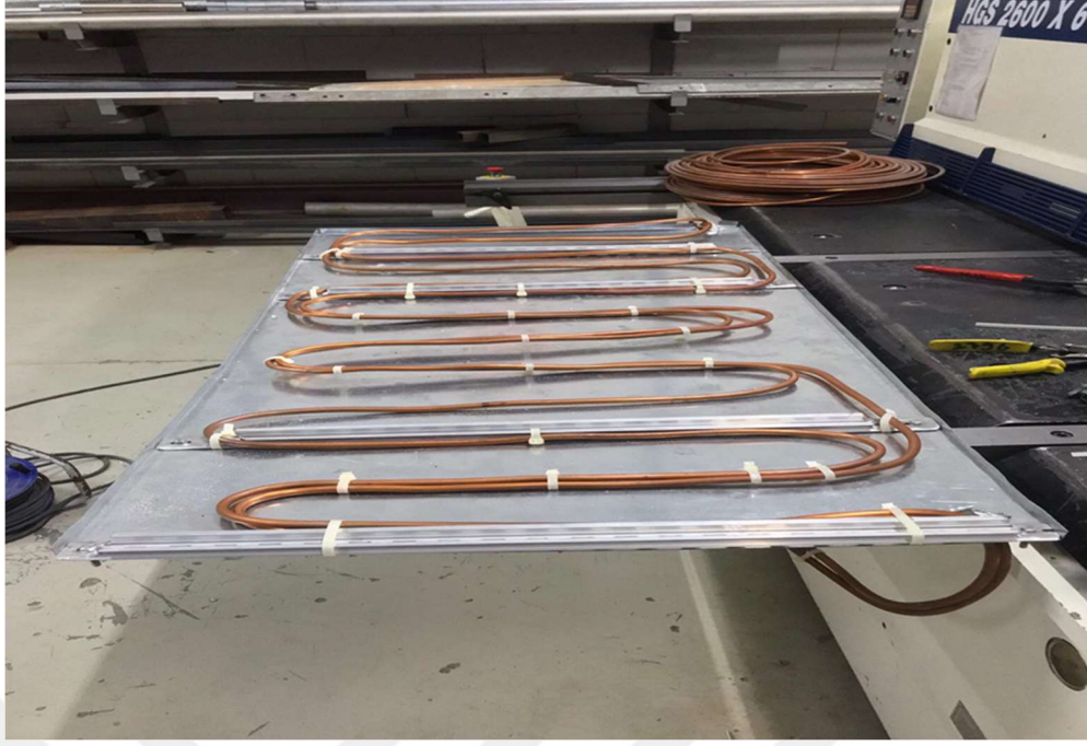
Şekil 5.3 Bakır Borunun Panel Montajı Öncesi Levha Üzerinde Hazırlanışı
