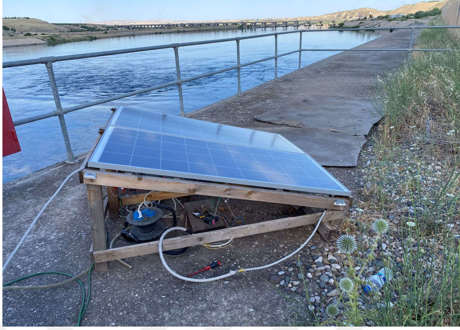
Şekil 5.10 Kurulumu Yapılan Panellerin Yandan Görünümü
