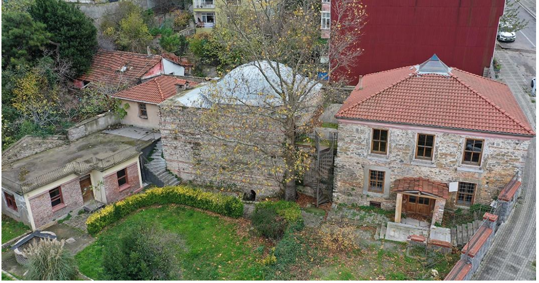
Şekil 3.9: İcadiye Dağ Hamamının restorasyondan önceki hali
