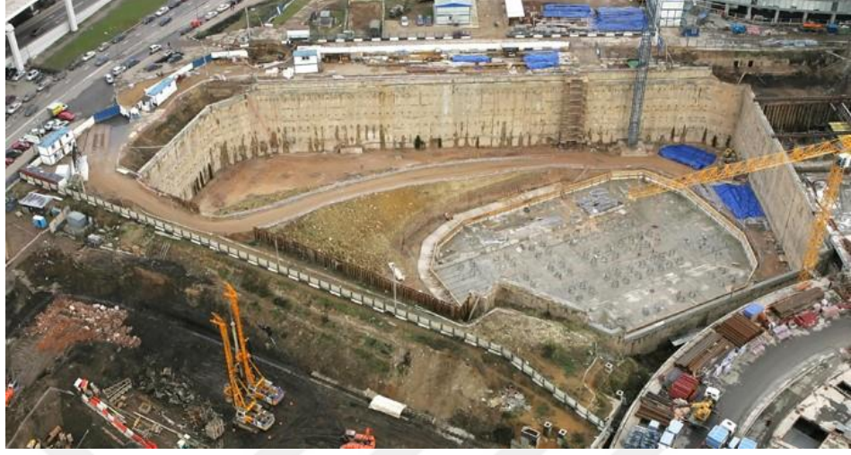
Şekil 3.23 Diyafram Duvar Örneği
