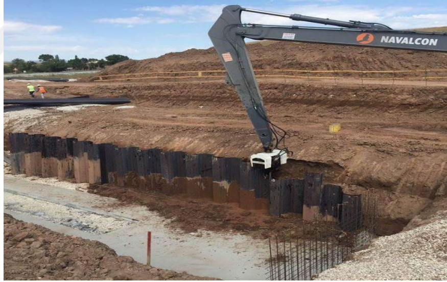
Şekil 3.27 Palplanş İmalatı Örneği
