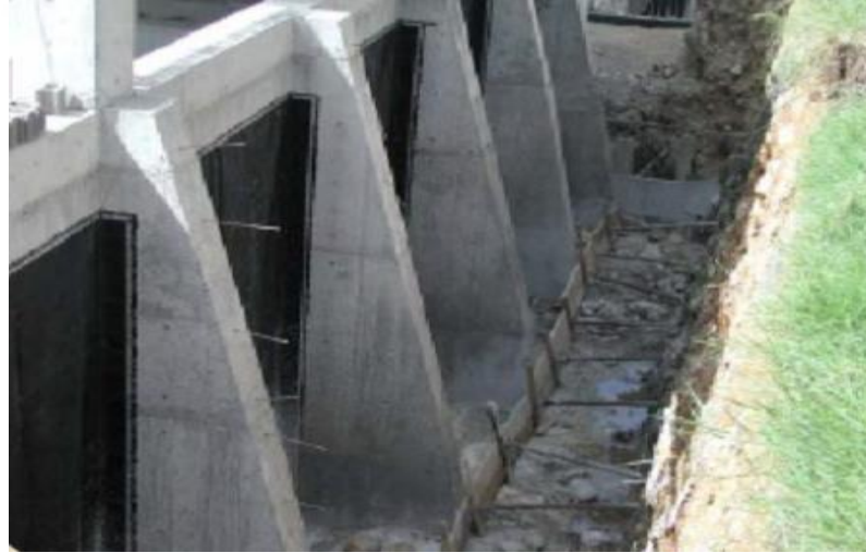
Şekil 3.22 Payandalı Duvar Örneği
