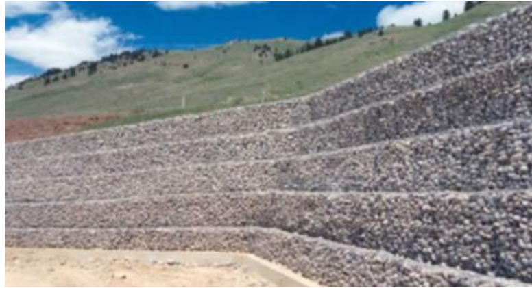
Şekil 3.24 Gabyon Duvar Örneği
