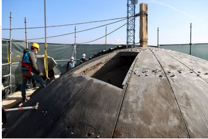
Şekil 4.24 Topkapı Sarayı Fatih Köşkü'nün 1942 yılı onarımında ahşap kubbesinin betonarmeye çevrilmeden önceki görünüşü (Öz, 1948), ve betonarme yapıldıktan sonraki görünüşü ( https://www.ntv.com.tr/galeri/sanat/tarihi-fatih-koskundeki-restorasyon , 2022)
