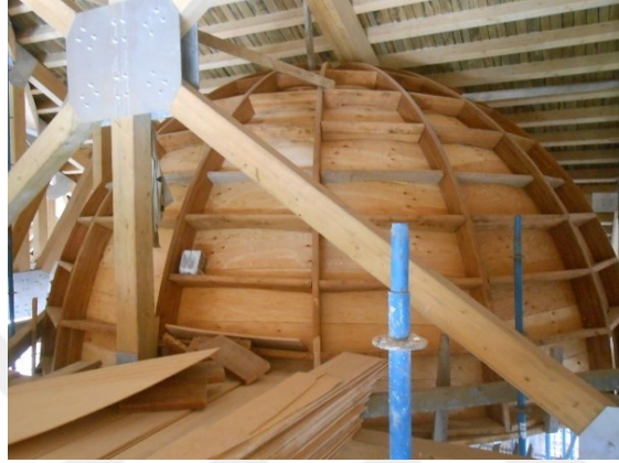
Şekil 2.80 Ferruh Kethüda Camisi'nin günümüzdeki ahşap kubbesinin endüstriyel ahşaplı konstrüksiyonu, 2021 (EKO Yapı arşivi)
