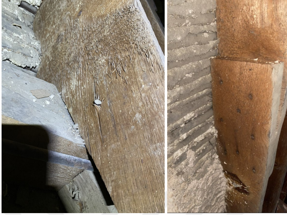
Şekil 4.15 Yahya Efendi Camisi’nin kaburgalarında ahşap- çivi birleşimlerindeki yarılma ve renk değişimi, 2021 (Kasaboğlu, E.)
