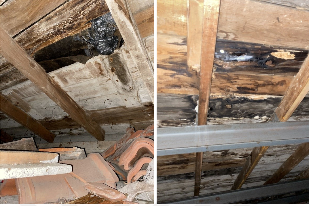
Şekil 4.20 Tütüncü Mehmet Efendi Camisi’nin ve Ahrida Sinagogu’nun ahşap kırma çatısında su alan bölümlerde ahşap bozulmaları, 2021 (Kasaboğlu, E.)
