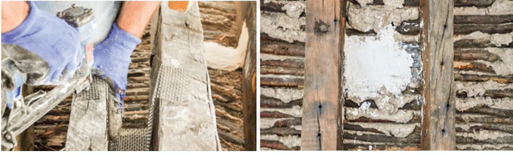
Şekil 2.246 Cezayirli Gazi Hasan Paşa Camisi'nde restorasyon sırasında paslanmaz çelik hasırın ahşap kaburgalara monte edilmesi ve paslanmaz çelik üzerine alçı uygulanması (Kocatürk vd., 2013)
