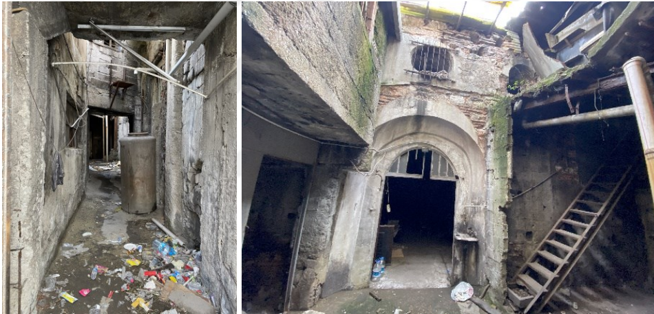
Şekil 2.19 Sokak kapısından ana mekâna doğru görünüş, ibadet mekânının kemerli kapısı, 2021 (Kasaboğlu, E.)
