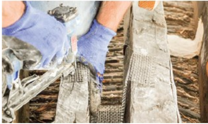
Şekil 4.37 Cezayirli Gazi Hasanpaşa Camisi'nin kubbesinin restorasyonunda paslanmaz çelik hasırın ahşap kaburgalara monte edilmesi (Kocatürk vd., 2013)
