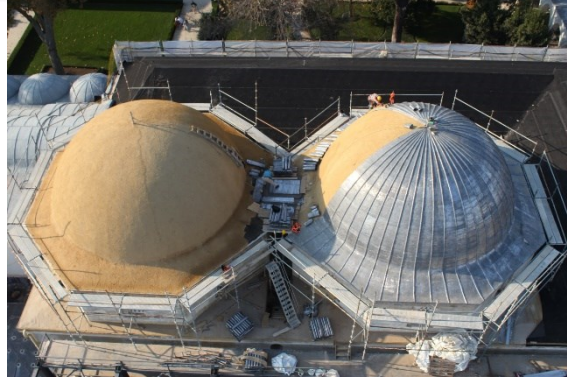
Şekil 2.45 Kubbelerin dış yüzeyinin çamur harç ile sıvanması, kurşun ile kaplanması, 2021 (Kasaboğlu, E.)
