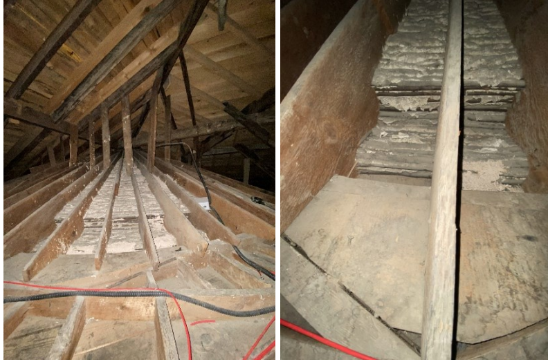
Şekil 2.61 Yahya Efendi Camisi'nin kubbesinin ahşap konstrüksiyonu 2021 (Kasaboğlu, E.)
