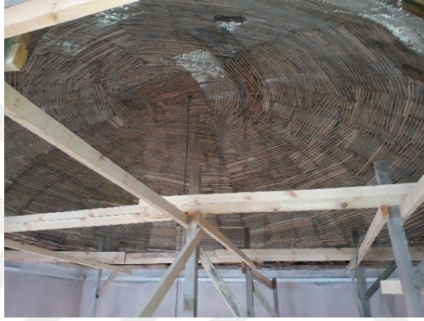
Şekil 3.5 Kaymak Mustafa Paşa Camisi'nin kubbesinin düşey kaburgalı ve bağdadi çıtalı yüzeyi (Atölye3 Mimarlık-Restorasyon)
