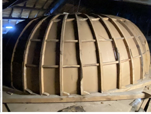
Şekil 4.26 Ahrida Sinagogu'nun özgün kubbe konstrüksiyonu, 1992 (Atatürk Kitaplığı Hüsrev Tayla Arşivi) ve günümüzde rekonstrüksiyonu yapılan ahşap kubbe, 2021 (Kasaboğlu, E.)
