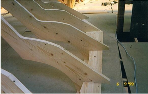
Şekil 2.371 Hadi Bey Yalısı'nın ahşap kubbesinin masif kaburgalarının taban ile birleşimi (Mustafa Dede Arşivi)
