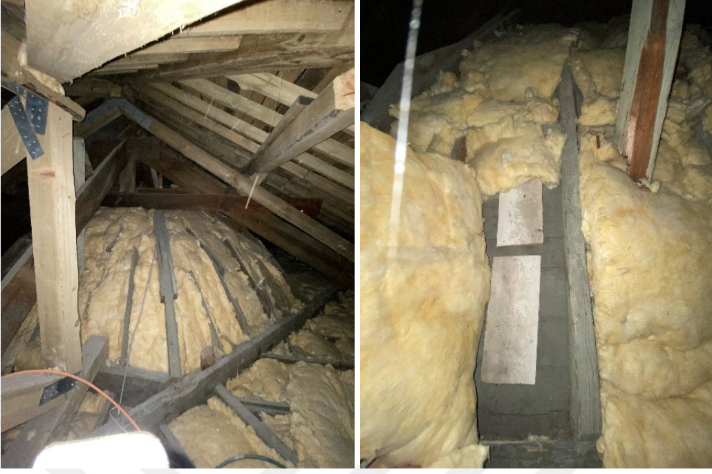
Şekil 3.21 Feneryolu Recai Yahya Camisi'nin kubbesinin düşey kaburgalı ve ahşap kaplamalı yüzeyi, 2021 (Kasaboğlu, E.)
