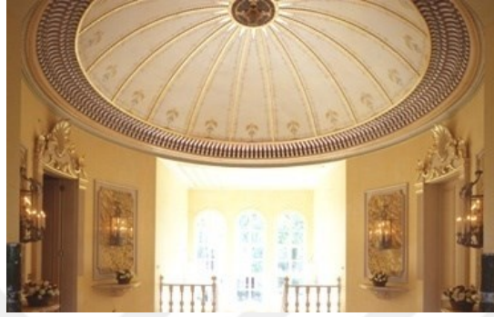
Şekil 2.375 Hadi Bey Yalısı'nın ahşap kubbesinin iç mekâna bakan yüzeyinin ahşap çıtalar ile 16 dilime ayrılması ve yüzeyin kalemîşi bezemelerinin tamamlandıktan sonraki görünüşü (Mustafa Dede Arşivi)
