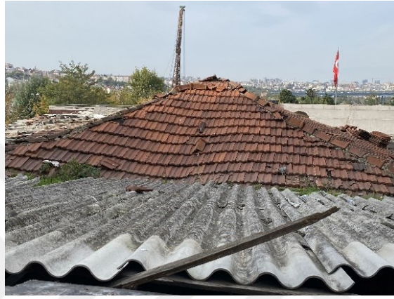
Şekil 2.23 Mayor Sinagogu'nun çevrili olduğu duvarlar ve çatısı, 2021 (Kasaboğlu, E.)
