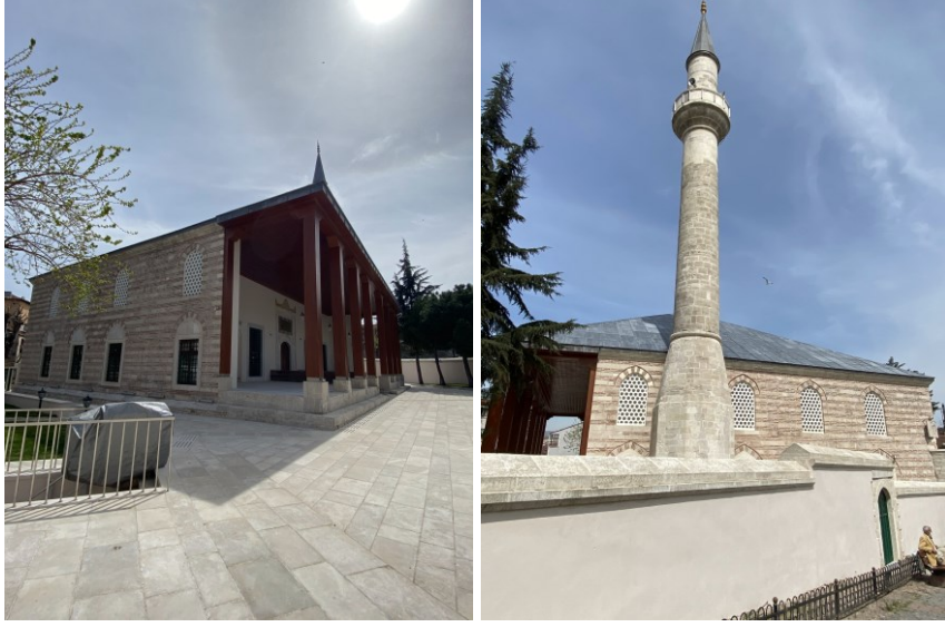
Şekil 2.78 Ferruh Kethüda Camisi'nin kuzeydoğu ve güneybatı cepheleri, 2021 (Kasaboğlu, E.)
