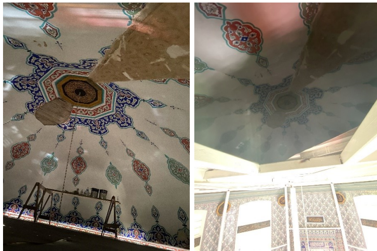
Şekil 2.388 Feridunpaşa Camisi'nin kubbesindeki bezemelerde görülen bozulmalar (Kasaboğlu, E.)
