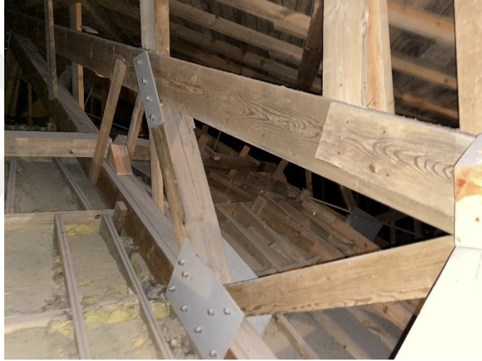
Şekil 4.39 Yenikapı Mevlevihanesi'nin semahanesinin kubbesi yeniden yapılırken kullanılan paslanmaz çelik bağlantı elemanları, 2021 (Kasaboğlu, E.)
