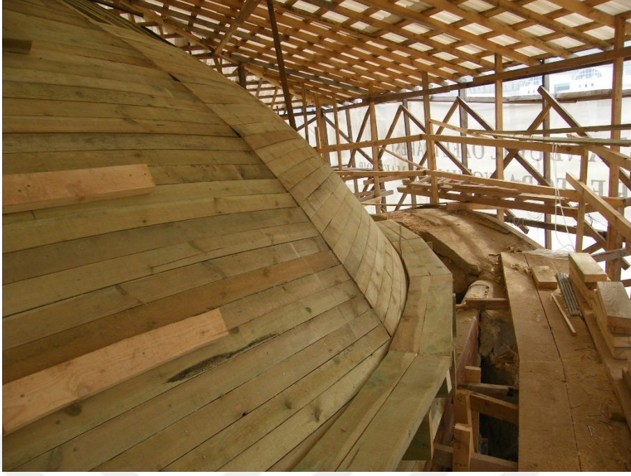
Şekil 3.51 Sadabat Camisi'nin ahşap kubbesinin dış cidarının restorasyon sonrası ahşap ile kaplanmış yüzeyi (VGM I. Bölge Arşivi)
