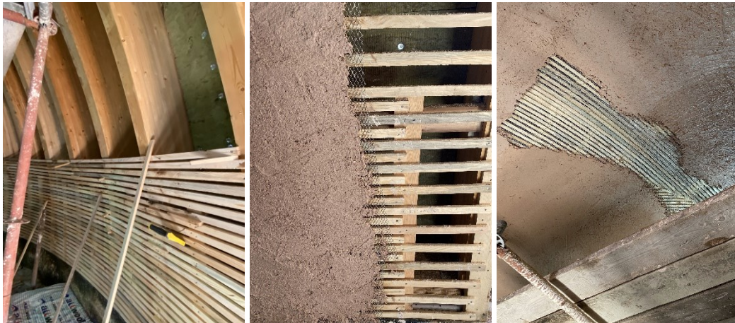
Şekil 2.43 İç mekâna bakan yüzeyin bağdadi çitalarının çakılarak sıvanması, 2021 (Kasaboğlu, E.)
