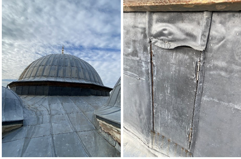
Şekil 2.164 Hünkâr Sofası'nın kurşun kaplı kubbesinin çatıdan görünümü ve kubbeye giriş kapısı, 2021 (Kasaboğlu, E.)
