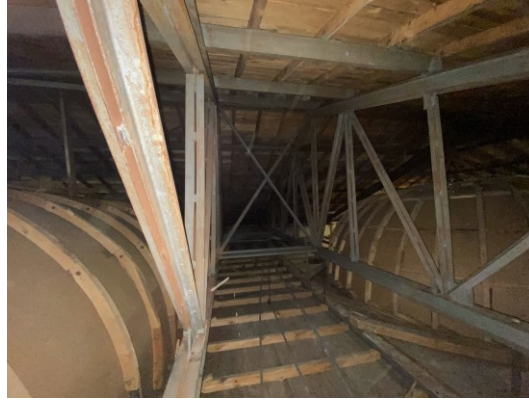
Şekil 2.17 Restorasyon öncesi özgün tonoz, kubbe ve kırma çatı taşıyıcılarının görünümü (Atatürk Kitaplığı Hüsrev Tayla Arşivi), günümüzde çatı arasının görünümü, 2021 (Kasaboğlu, E.)
