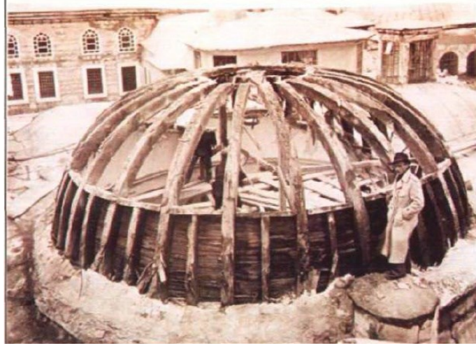
Şekil 4.25 Topkapı Sarayı Ocaklı Sofa'nın 1945 yılı onarımında ahşap kubbesinin betonarmeye çevrilmeden önceki görünüşü (Karahasan, 2005)
