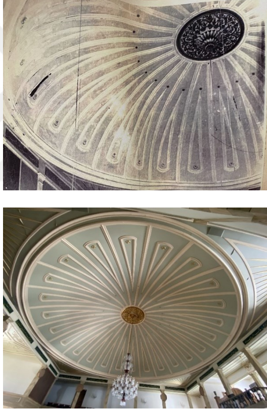
Şekil 2.107 Ahşap kubbenin iç mekâna bakan yüzeyi yangından önce (VGM I. Bölge arşivi), rekonstrüksiyon sonrası, 2021 (Kasaboğlu, E.)
