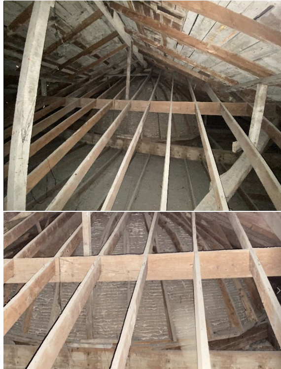
Şekil 3.7 Tütüncü Mehmet Efendi Camisi'nin kubbesinin düşey kaburgalı ve bağdadi çıtalı yüzeyi, 2021 (Kasaboğlu, E.)
