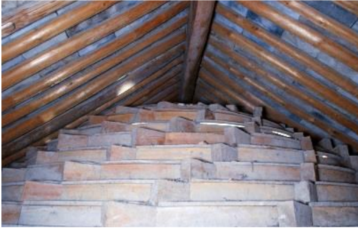
Şekil 1.2 Çin'in Ninghai bölgesinde 1920'lerde inşa edilen spiral kubbenin çatı altından görünüşü (Ye ve Fivet, 2018)
