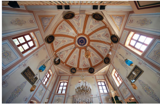
Şekil 2.349 Büyükada Hamidiye Camisi'nin ahşap kubbesinin iç mekândan görünüşü ( https://www.hamidiyecamiidernegi.org , 2023)
