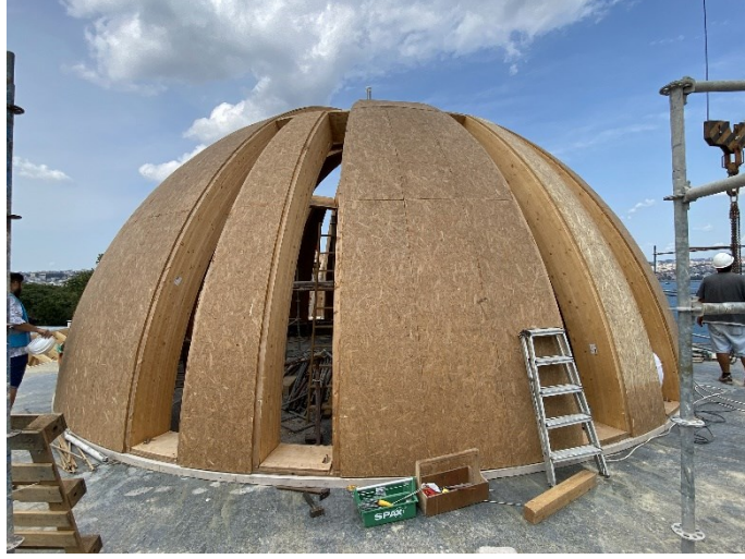
Şekil 4.45 Topkapı Sarayı Fatih Köşkü'nün ahşap kubbesinin rekonstrüksiyonunda kullanılan endüstriyel ahşap kaburgalar ve kaplamalar, 2021 (Kasaboğlu, E.)
