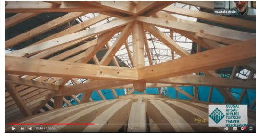
Şekil 2.374 Hadi Bey Yalısı'nın çatısının kubbenin üzerinde yer alan makas sistemi (Turgut Cansever Arşivi, Emine Öğün Mehmet Öğün Mimarlık) ( https://www.youtube.com/watch?v=jW6-LeYvioQ , 2024)
