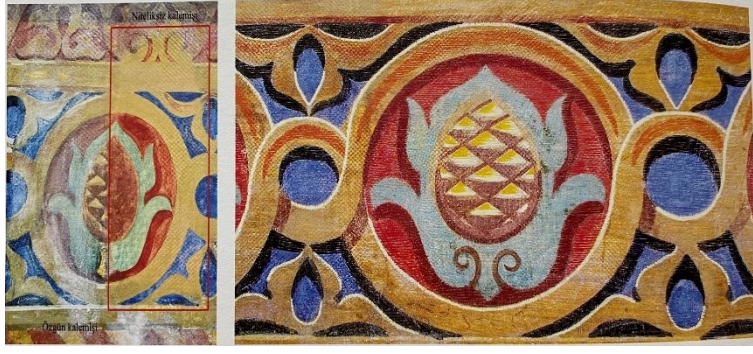
Şekil 2.325 Yıldız Hamidiye Camisi'nin 2013-2017 yılı restorasyonunda kubbe kasnağı pencere üstünde yapılan kalemişi raspası (Yücel vd., 2020)
