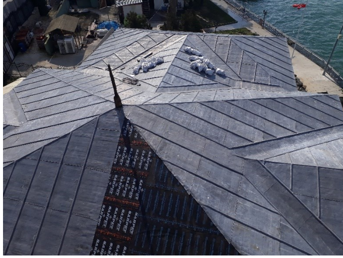
Şekil 4.36 Kaymak Mustafa Paşa Camisi'nin kurşun çatı kaplamasının altındaki iki kat membran su yalıtımı (EKO Yapı arşivi)
