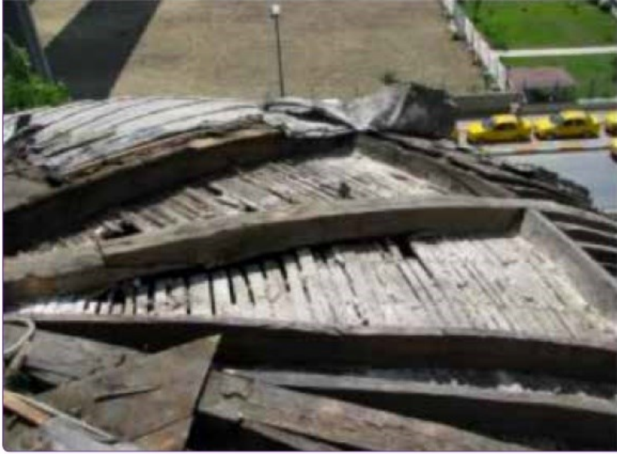
Şekil 3.41 Kumbarhane Camisi'nin ahşap kubbesinin düşey kaburgalı ve bağdadi çıtalı yüzeyi (Alioğlu, 2015)
