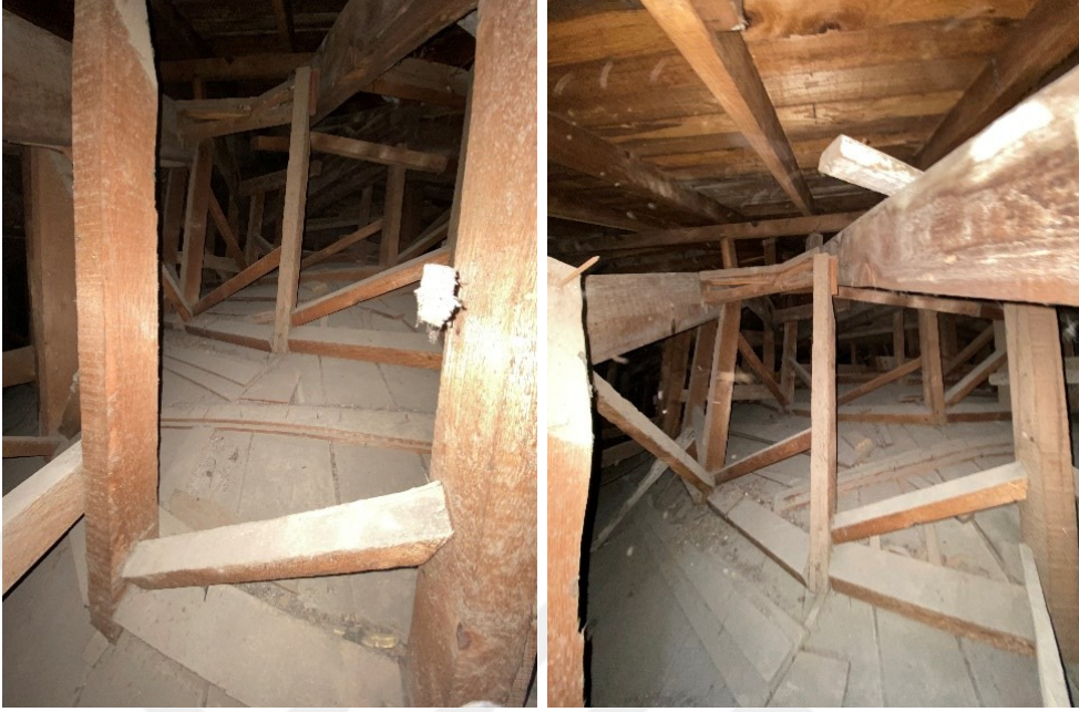
ekil 3.35 Fevziye Kk Efendi Camisi'nin kubbesinin askı sistem ile ahap atıya sabitlenmesi ve i mekna bakan yzeyindeki ahap kaplamalar, 2021 (Kasabolu, E.)
