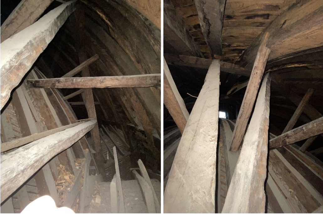
Şekil 3.58 Topkapı Sarayı Hırka-i Saadet Odası'nın çift cidarlı, düşey kaburgalı ve bağdadi çıtalı kubbesi, 2021 (Kasaboğlu, E.)
