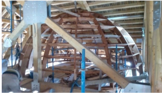
Şekil 2.80 Ferruh Kethüda Camisi'nin günümüzdeki ahşap kubbesinin endüstriyel ahşaplı konstrüksiyonu, 2021 (EKO Yapı arşivi)
