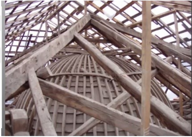
Şekil 2.89 Ahşap kubbenin konstrüksiyonu, (Akın, S. 2005)
