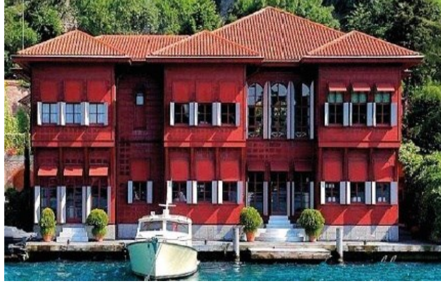
Şekil 2.366 Hadi Bey Yalısı'nın deniz cephesi ( https://control4.com.tr/ , 2024)
