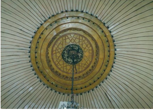
Şekil 2.16 Restorasyon öncesi iç mekâna bakan kubbe yüzeyi ahşap kaplamaları (Atatürk Kitaplığı Hüsrev Tayla arşivi), restorasyon sonrası kubbe yüzeyi ahşap kaplamaları, 2021 (Kasaboğlu, E.)
