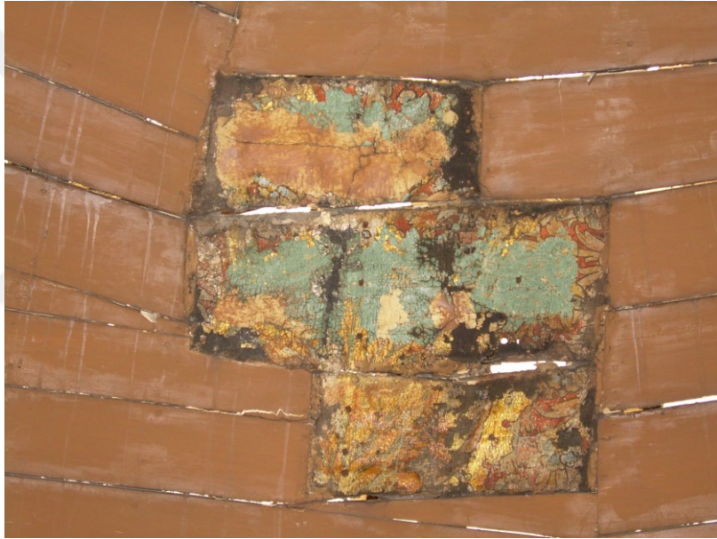
Şekil 2.132 Kubbe yüzeyinin günümüze ulaşan özgün tual parçaları (Hatice Karakaya Mimarlık Bürosu arşivi)
