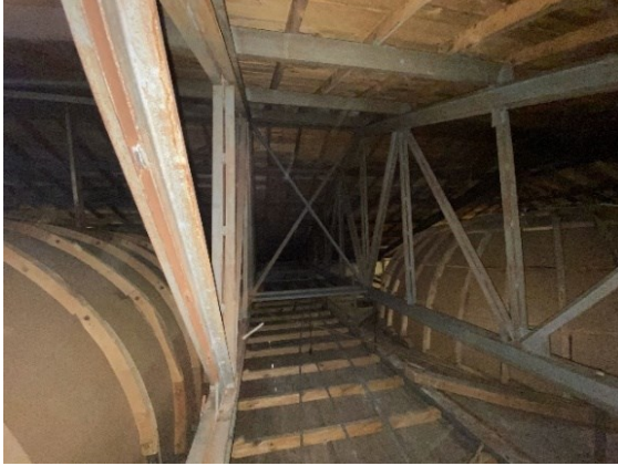
Şekil 2.8 Ahrida Sinagogu'n da günümüzde bulunan çelik çatı konstrüksiyonu ve 1992 restorasyonunda yapılmış betonarme hatıl, 2021 (Kasaboğlu, E.)
