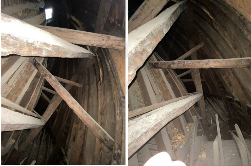
Şekil 2.52 Hırka-i Saadet Odasının ahşap kubbesinin konstrüksiyonu, iç ve dış cidar arasında yer alan pencere boşluğunu oluşturan tonozlar, 2021 (Kasaboğlu, E.)
