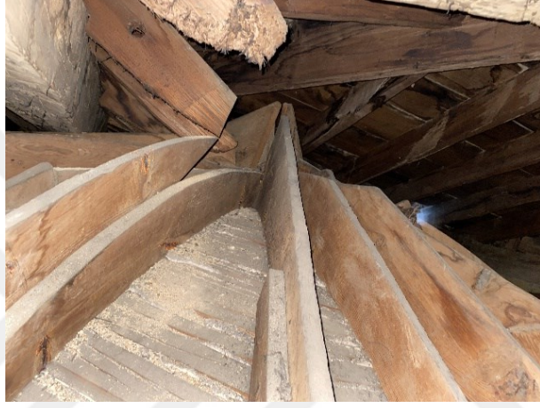
Şekil 3.3 Abbasaga Camisi'nin düşey kaburgalı ve bağdadi çıtalı yüzeyi, 2021 (Kasaboğlu, E.)
