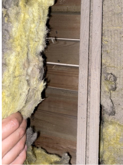
Şekil 2.105 Ahşap kubbenin iç mekâna bakan yüzeyinin yatay ahşap kaplaması, 2021 (Kasaboğlu, E.)
