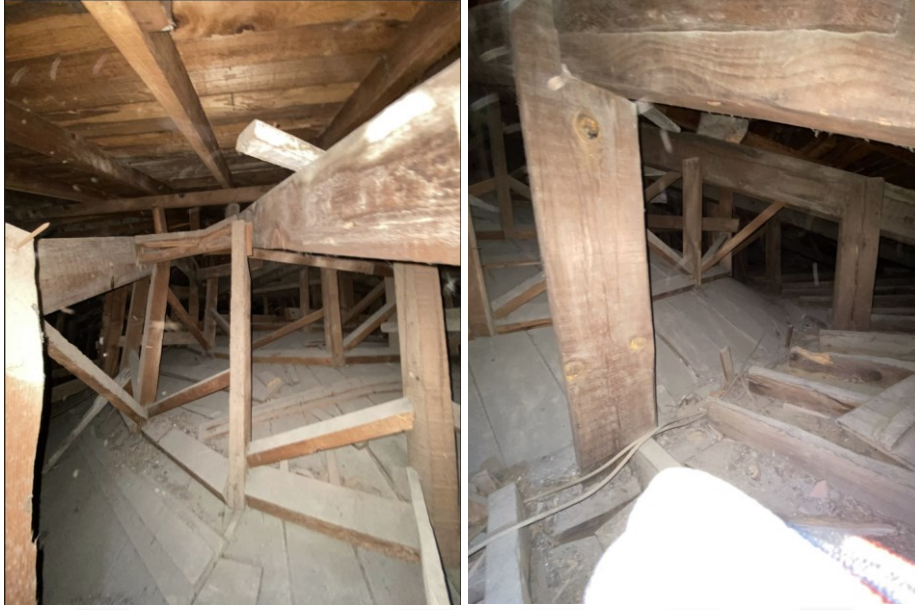
Şekil 2.283 Fevziye Küçük Efendi Camisi'nin ahşap kubbesinin konstrüksiyonu, 2023 (Kasaboğlu, E.)
