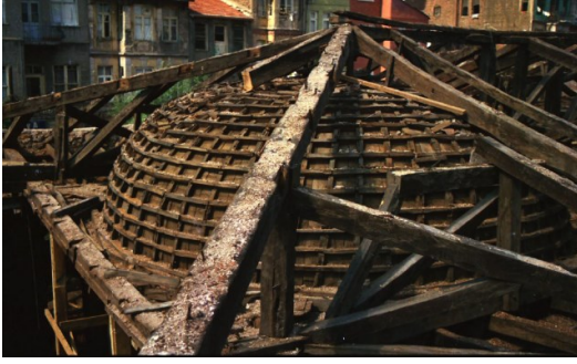
Şekil 4.26 Ahrida Sinagogu'nun özgün kubbe konstrüksiyonu, 1992 (Atatürk Kitaplığı Hüsrev Tayla Arşivi) ve günümüzde rekonstrüksiyonu yapılan ahşap kubbe, 2021 (Kasaboğlu, E.)
