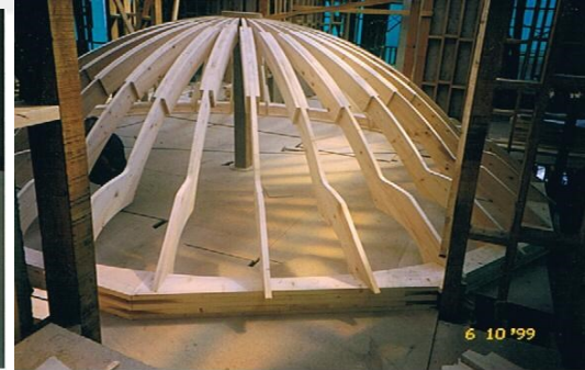
Şekil 2.371 Hadi Bey Yalısı'nın ahşap kubbesinin masif kaburgalarının taban ile birleşimi (Mustafa Dede Arşivi)
