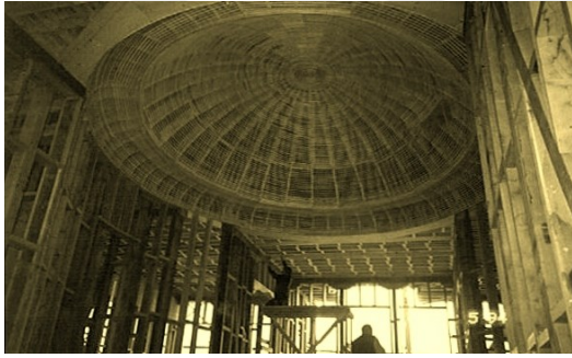
Şekil 2.373 Hadi Bey Yalısı'nın ahşap kubbesinin bağdadi çıta ile kaplanması ve sıvanması (Mustafa Dede Arşivi)
