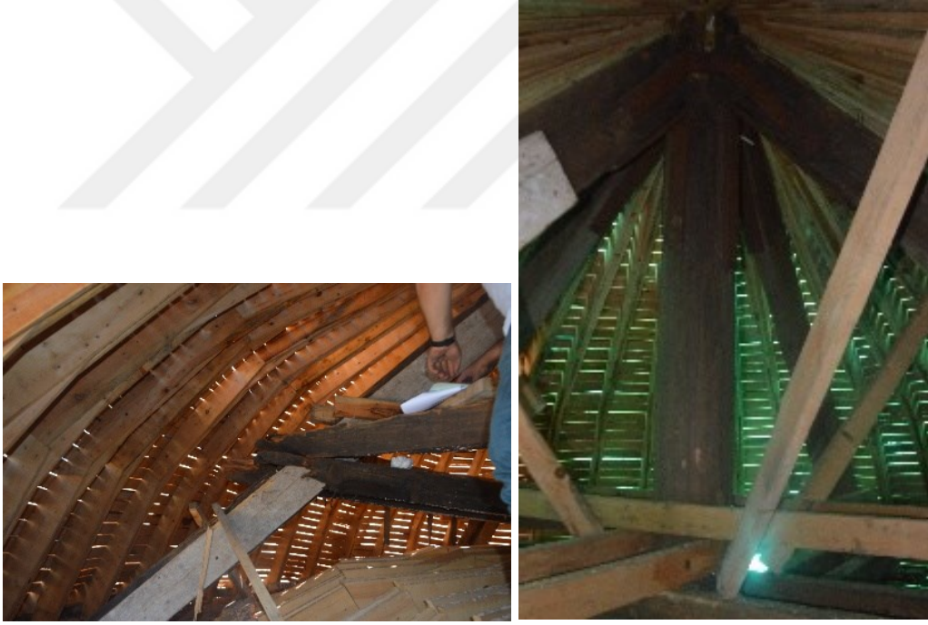
Şekil 1.6 Şeyh Zafir Türbesi ahşap kubbe konstrüksiyonu (VGM I. Bölge arşivi)
