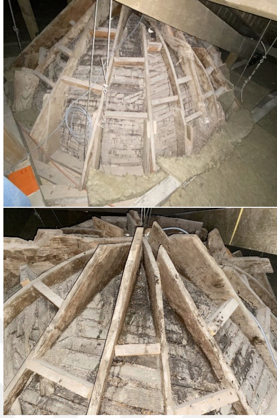
Şekil 3.6 Seyyid Nizam Cami- Tevhidhanesi'nin kubbesinin düşey kaburgalı ve bağdadi çıtalı yüzeyi, 2021 (Kasaboğlu, E.)
