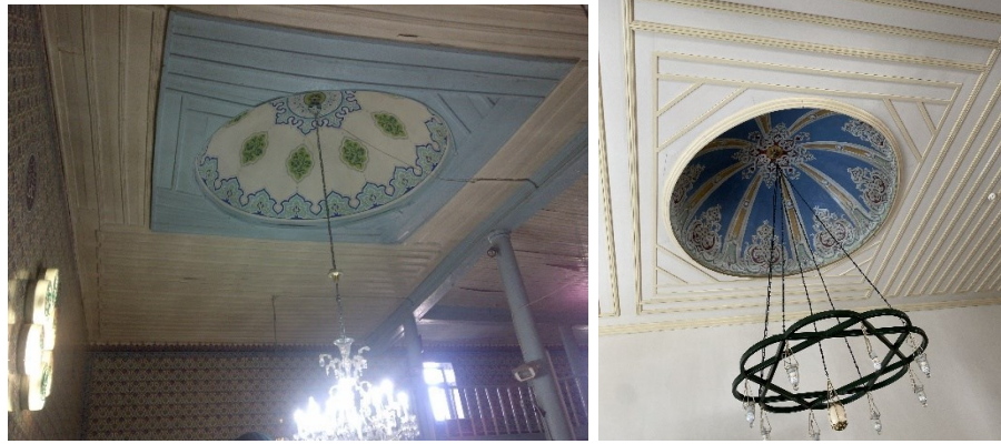
Şekil 2.306 Seyyid Nizam Cami- Tevhidhanesi'nin ahşap kubbesinin iç mekâna bakan yüzeyinin restorasyon öncesi (Yılmaz Yapı Arşivi) ve sonrası görünüşü, 2021 (Kasaboğlu, E.)
