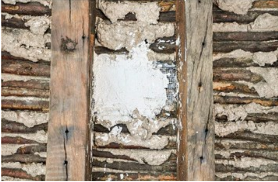
Şekil 3.44 Cezayirli Gazi Hasan Paşa Camisi'nin ahşap kubbesinin düşey kaburgalı ve dal kaplamalı yüzeyi, 2021 (Kocatürk vd., 2013)
