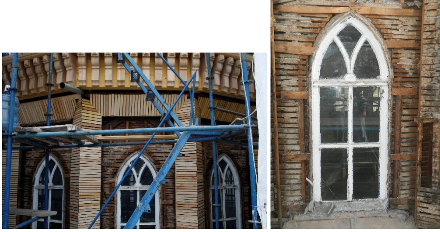
Şekil 2.319 Yıldız Hamidiye Camisi'nin ahşap taşıyıcılı, bağdadi sıvalı kasnağı ve penceresi (VGM I. Bölge Arşivi)
