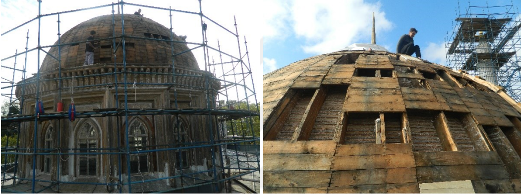
Şekil 2.320 Yıldız Hamidiye Camisi'nin kubbesinin ahşap konstrüksiyonu ve ahşap kaplamaları (VGM I. Bölge Arşivi)
