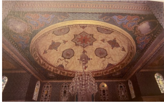
Şekil 2.121 Sepetçiler Kasrı'nın ahşap kubbesinin iç mekâna bakan yüzeyinin 1999 onarımı öncesi (Sarioğlu, 2021) ve sonrası görünüşü (VGM I. Bölge arşivi)
