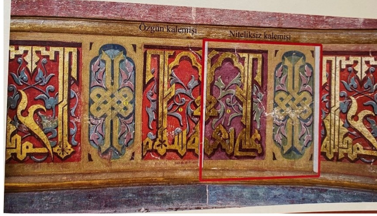
Şekil 2.328 Yıldız Hamidiye Camisi'nin 2013-2017 yılı restorasyonunda kubbe kasnağı alt kotunda yapılan raspa çalışmaları (Yücel vd., 2020)
