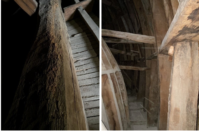
Şekil 2.170 Hünkâr Sofası'nın kubbesinin ahşap kaburgasında böceklenmeye bağlı tozlaşma ve dış kubbe kaburgalarındaki renk değişimi, 2021 (Kasaboğlu, E.)
