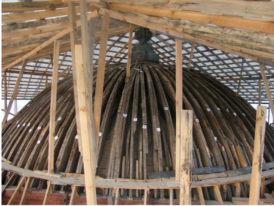
Şekil 3.48 Sadabat Camisi'nin ahşap kubbesinin ana, tali omurga ve enine kesiti daha ince olan kaburgalardan oluşan dış cidarının restorasyon öncesi görünümü (VGM I. Bölge Arşivi)
