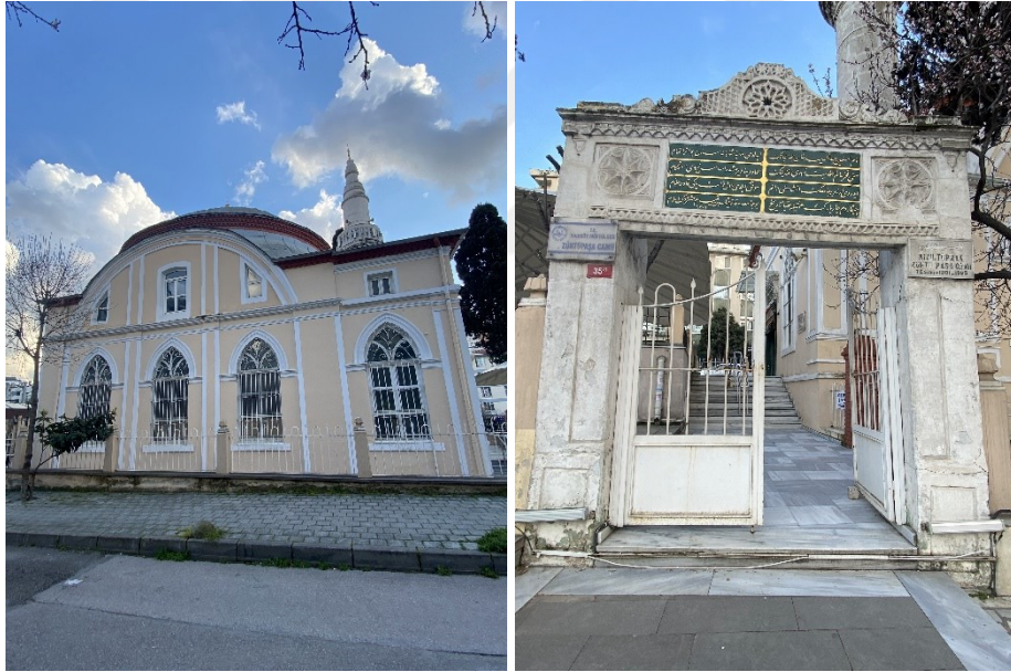
Şekil 2.311 Zühtü Paşa Camisi'nin doğu cephesi ve avlu giriş kapısı, 2021 (Kasaboğlu, E.)
