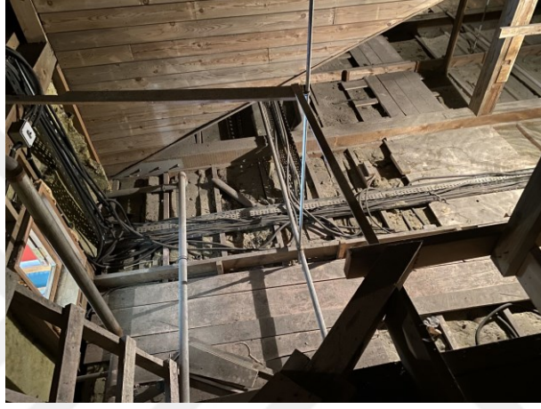
Şekil 2.108 Kaburgalar arasına döşenen taş yünü, çatı arasında bulunan elektrik kabloları, 2021 (Kasaboğlu, E.)
