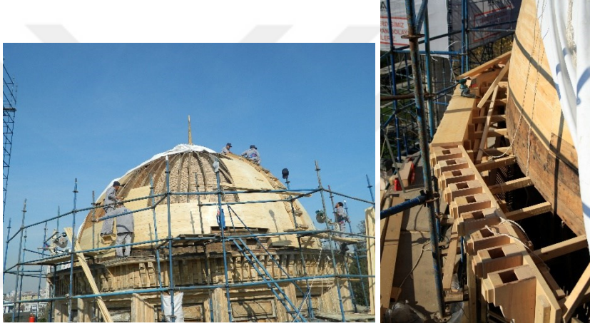
Şekil 2.329 Yıldız Hamidiye Camisi'nin kubbesinin yenilenen ahşap kaplamaları ve kasnak üzerindeki ahşap kornişler (VGM I. Bölge Arşivi)
