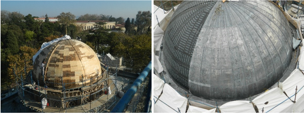
Şekil 2.321 Yıldız Hamidiye Camisi'nin kubbesinin ahşap konstrüksiyonu (VGM I. Bölge Arşivi)
