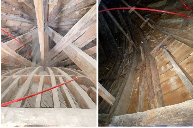
Şekil 2.166 Hünkâr Sofası'nın iç ve dış kubbesinin ahşap dikme ile birleşimi ve dış kubbenin ahşap konstrüksiyonu, 2021 (Kasaboğlu, E.)
