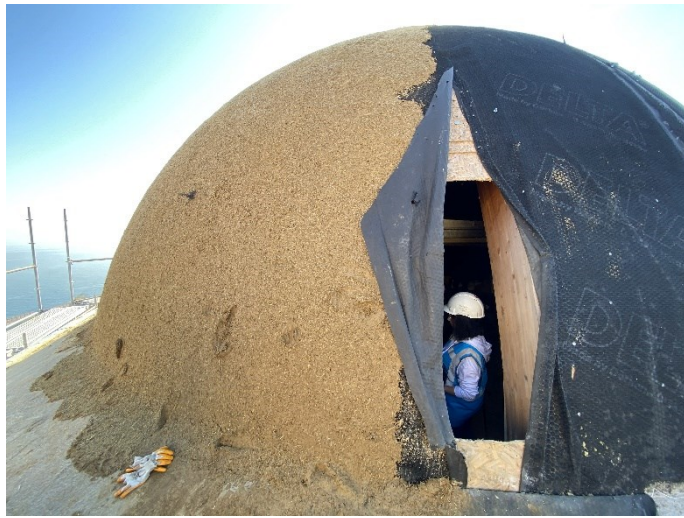
Şekil 4.35 Topkapı Sarayı Fatih Köşkü'nün kubbesinin rekonstrüksiyonundaki ahşap kaplama üstü katmanlar: Polietilen esaslı Tyvek yalıtım malzemesi- sıva tutucu malzeme- çamur harcı- kurşun kaplama, 2021 (Kasaboğlu, E.)
