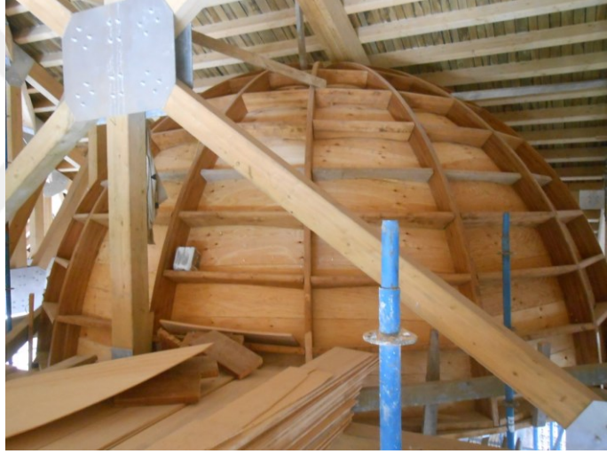
Şekil 4.46 Ferruh Kethüda Camisi'nin ahşap kubbesinin rekonstrüksiyonunda kullanılan endüstriyel ahşap kaburgalar, 2021 (Eko Yapı arşivi)
