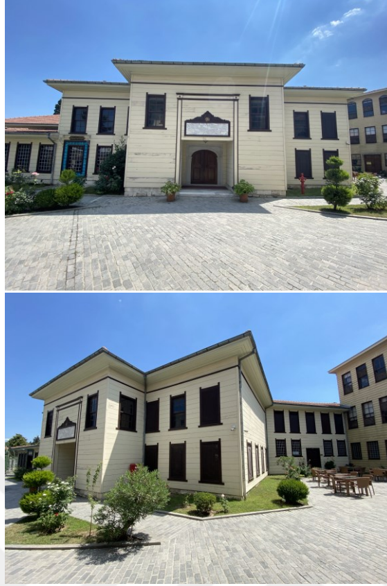
Şekil 2.100 Yenikapı Mevlevihanesi'nin semahanesinin ana giriş cephesi, semahanenin şerbethane ile bağlantısı, 2021 (Kasaboğlu, E.)
