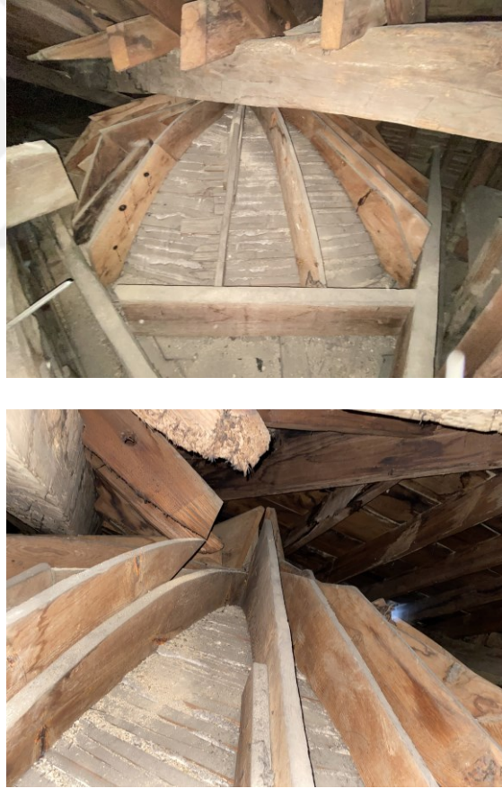
Şekil 2.140 Abbasağa Camisi'nin ahşap kubbesinin konstrüksiyonu, 2021 (Kasaboğlu, E.)
