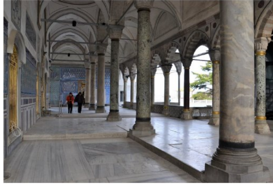
Şekil 2.50 Hırka-i Saadet Odası'nın kuzeydoğu cephesinde yer alan revak (Yaman, 2020)
