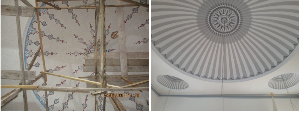
Şekil 2.234 Kaymak Mustafa Camisi'nin ahşap kubbesinin restorasyon öncesi iç mekâna bakan yüzeyinin bezemesi, 2018 ve günümüz bezemesi, 2021 (Atölye 3 Mimarlık Arşivi)
