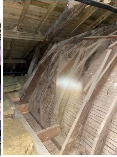
Şekil 2.341 Ertuğrul Tekke Camisi'nin ahşap kubbesinin kırma çatı altındaki görünüşü ve ahşap kubbesinin konstrüksiyonu, 2021 (Kasaboğlu, E.)
