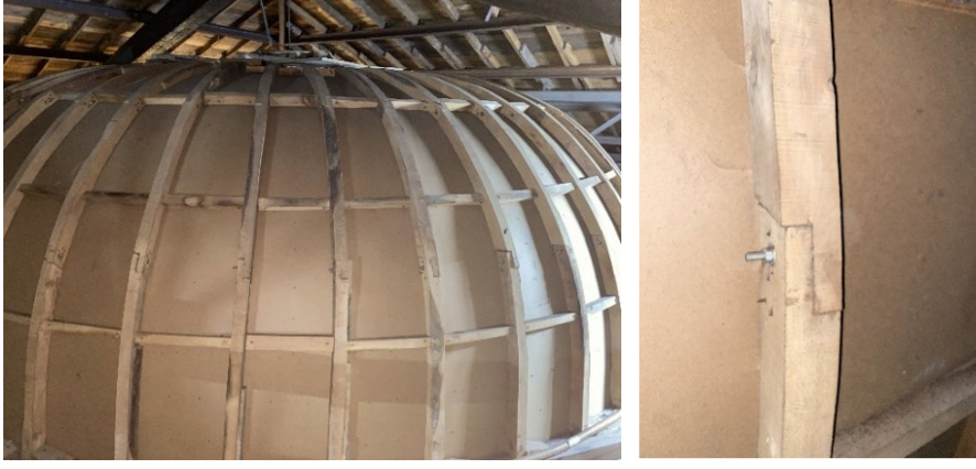
Şekil 2.12 Sinagogun ahşap kubbe konstrüksiyonunun çatı arasından görünümü ve kaburga birleşim detayı, 2021 (Kasaboğlu, E.)
