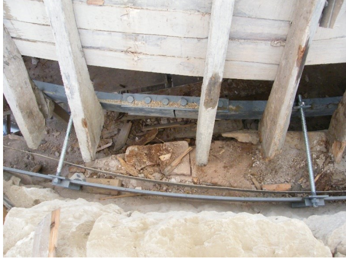
Şekil 4.38 Sadabat Camisi'nin kubbesinin restorasyonunda kubbe tabanına yerleştirilen çelik çember (VGM I. Bölge arşivi)
