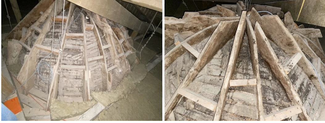
Şekil 2.305 Seyyid Nizam Cami- Tevhidhanesi'nin ahşap kubbe konstrüksiyonunun restorasyon sonrası görünüşü, 2021 (Kasaboğlu, E.)
