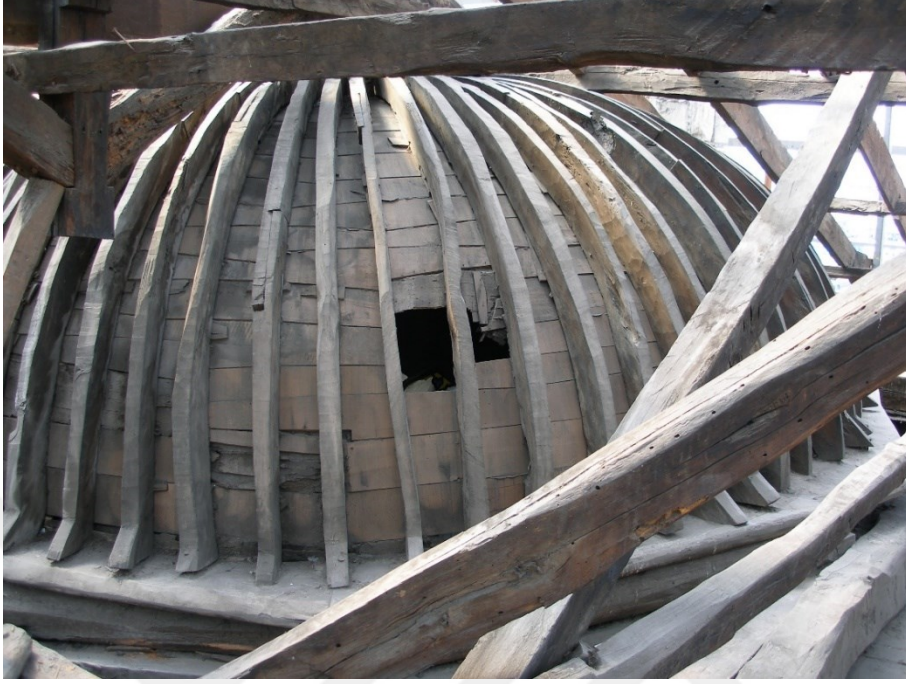
Şekil 3.17 Yeni Cami Hünkâr Kasrı'nın kubbesinin düşey kaburgalı ve ahşap kaplamalı yüzeyi, restorasyon öncesi (VGM I. Bölge Arşivi)
