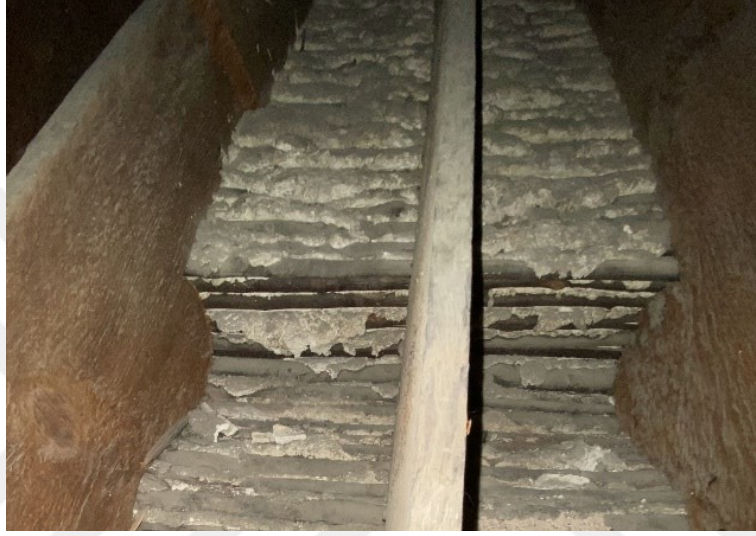
Şekil 3.13 Yahya Efendi Camisi'nin ahşap kubbesinin düşey kaburgalı ve dal kaplamalı yüzeyi, 2021 (Kasaboğlu, E.)
