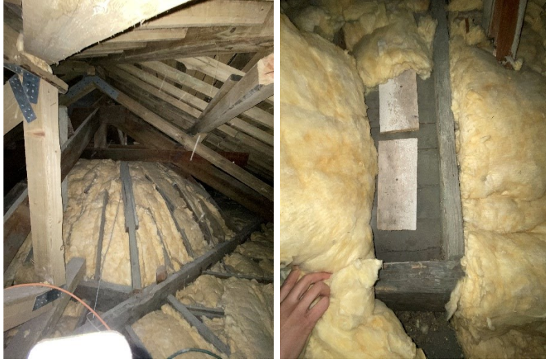
Şekil 2.393 Feneryolu Recai Yahya Camisi'nin ahşap kubbesinin konstrüksiyonu, 2021 (Kasaboğlu, E.)
