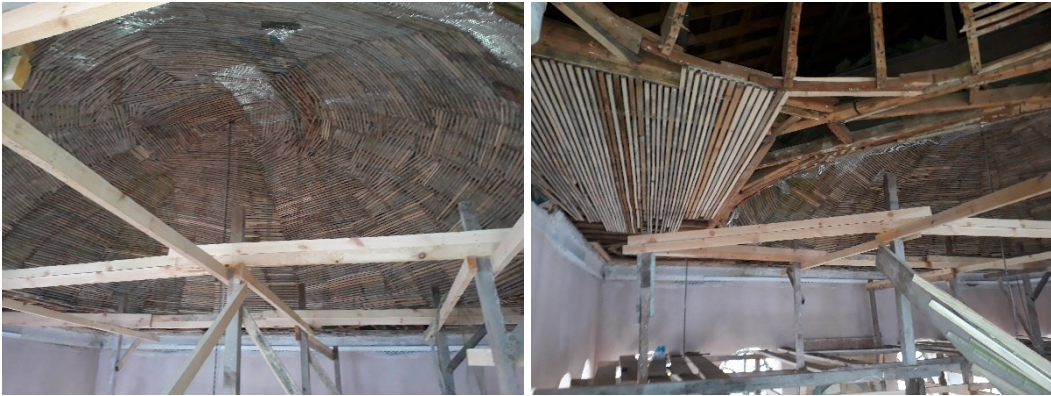
Şekil 2.233 Kaymak Mustafa Paşa Camisi'nin ahşap kubbesinin iç mekâna bakan yüzeyinin bağdadi kaplaması (Atölye 3 Mimarlık Arşivi)
