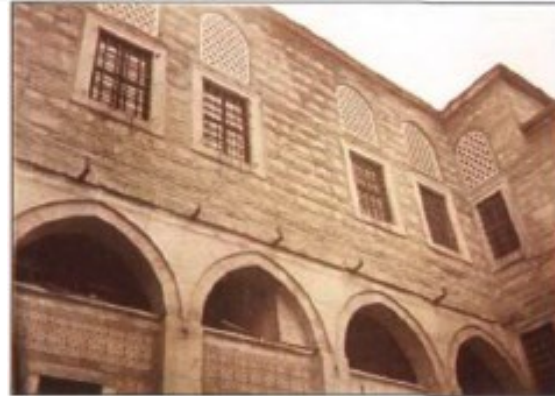
Şekil 2.156 Şehzadeler Mektebi'nin onarım öncesi ve sonrası (1948) cephesi (Karahasan, 2005)
