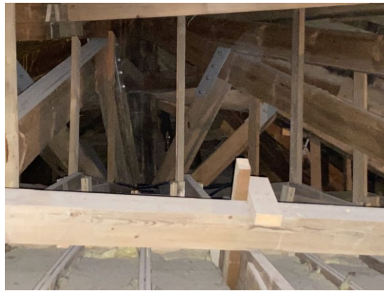
Şekil 2.103 Ahşap kubbe konstrüksiyonundaki büyük, orta, küçük boyutlu kaburgalar, büyük boyutlu kaburga ve kubbenin merkezden ahşap bir eleman ile kaburgaya asılması, 2021 (Kasaboğlu, E.)
