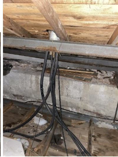
Şekil 2.8 Ahrida Sinagogu'n da günümüzde bulunan çelik çatı konstrüksiyonu ve 1992 restorasyonunda yapılmış betonarme hatıl, 2021 (Kasaboğlu, E.)
