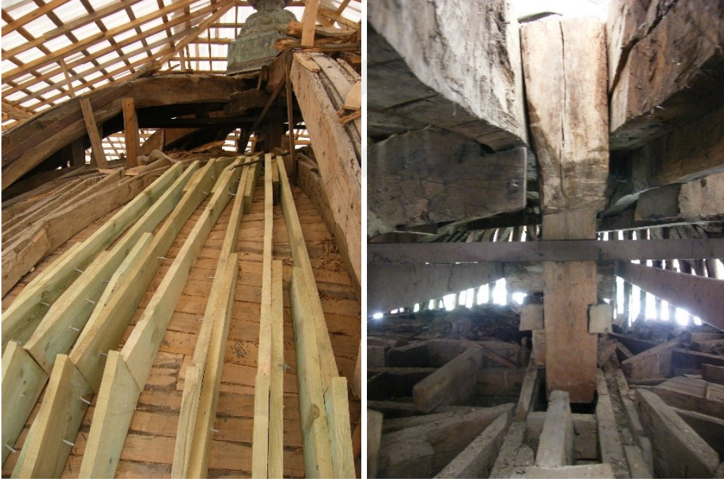
Şekil 2.202 Ahşap kubbenin iç cidarının kısmen yenilenen kaburgaları ve dış cidar ile iç cidarı bağlayan ahşap baba (VGM I. Bölge Arşivi)
