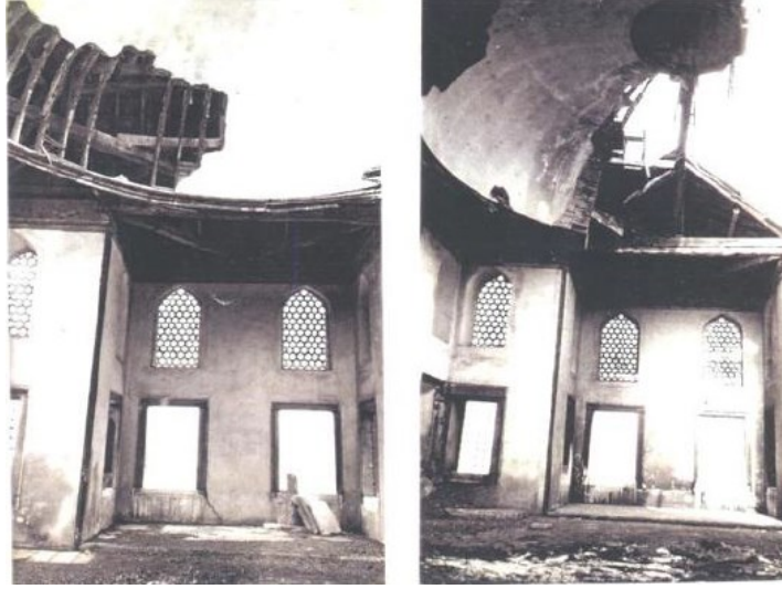
Şekil 2.120 1960 yılı onarımları sırasında divanhanenin üzerini örten ahşap kubbenin konstrüksiyonun görünüşü (Sarioğlu, 2021)
