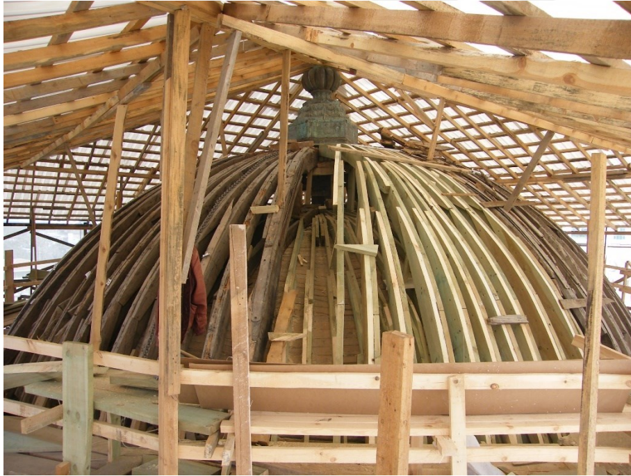
Şekil 3.50 Sadabat Camisi'nin ahşap kubbesinin dış cidarının restorasyon sırasındaki görünümü (VGM I. Bölge Arşivi)
