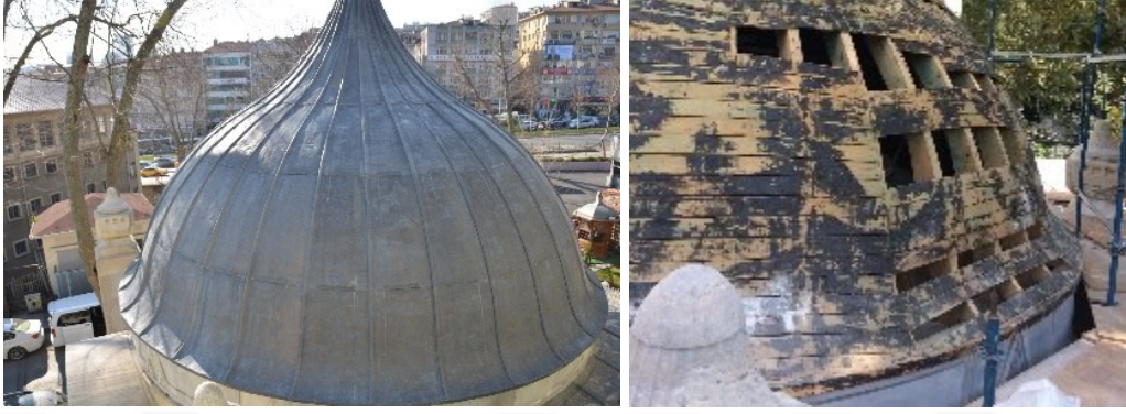
Şekil 1.5 Şeyh Zafir Türbesi kubbesinin dış cepheden görünümü ve kaburga üstü yüzey kaplaması (VGM I. Bölge arşivi)
