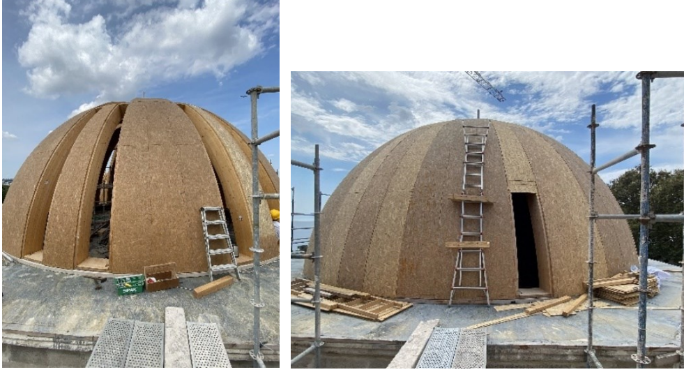
Şekil 2.41 Fatih Köşkü ahşap kubbelerinin yapım aşamaları, 2021 (Kasaboğlu, E.)
