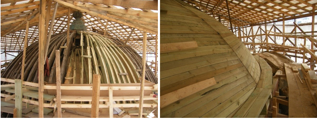
Şekil 2.198 Ahşap kubbenin dış cidarının işlevini kaybeden kaburgalarının ve dış yüzey kaplamasının yenilenmesi, 2012- 2014 restorasyonu (VGM I. Bölge Arşivi)
