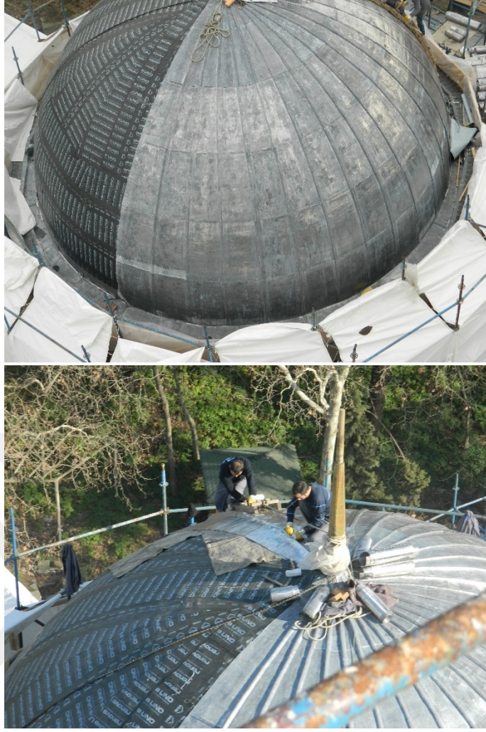
Şekil 4.34 Yıldız Hamidiye Camisi'nin kubbesinin restorasyonunda kurşun kaplama altına membran su yalıtım malzemesi uygulaması (VGM 1. Bölge arşivi)
