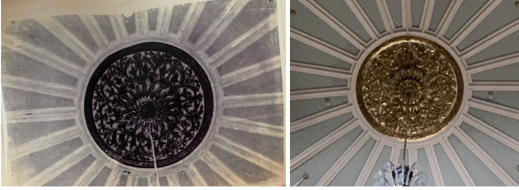
Şekil 2.106 Ahşap kubbenin barok üsluptaki oymalı ahşap göbeği yangından önceki görünüşü (VGM I. Bölge arşivi), rekonstrüksiyon sonrası, 2021 (Kasaboğlu, E.)
