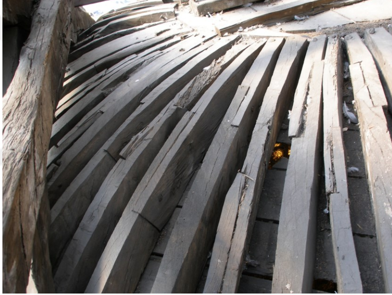
Şekil 2.128 Hünkâr kasrının baş odasında bulunan ahşap kubbesinin konstrüksiyonu, restorasyon öncesi (VGM I. Bölge arşivi)
