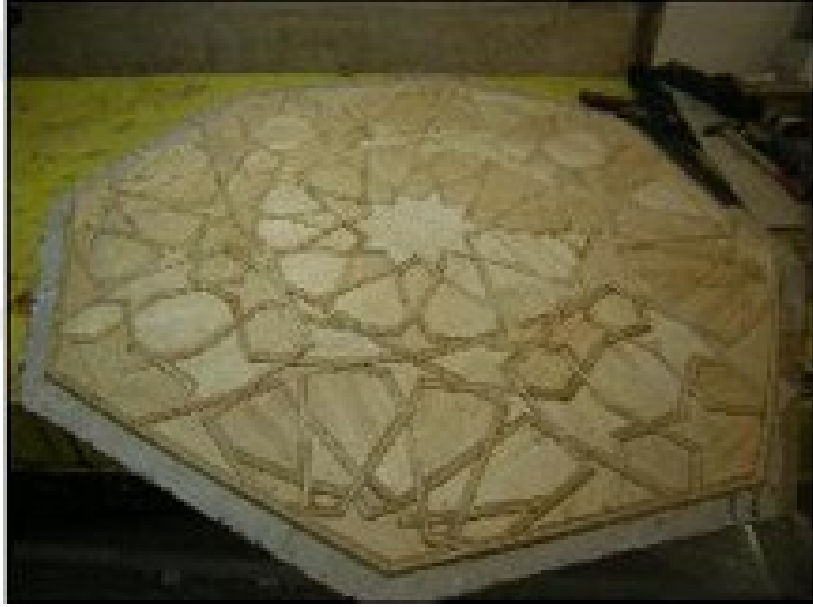
Şekil 2.133 Yenilenen mukarnasların altın varak ile kaplanması, kubbe göbeğinin ahşap kaplaması (Hatice Karakaya Mimarlık Bürosu arşivi)
