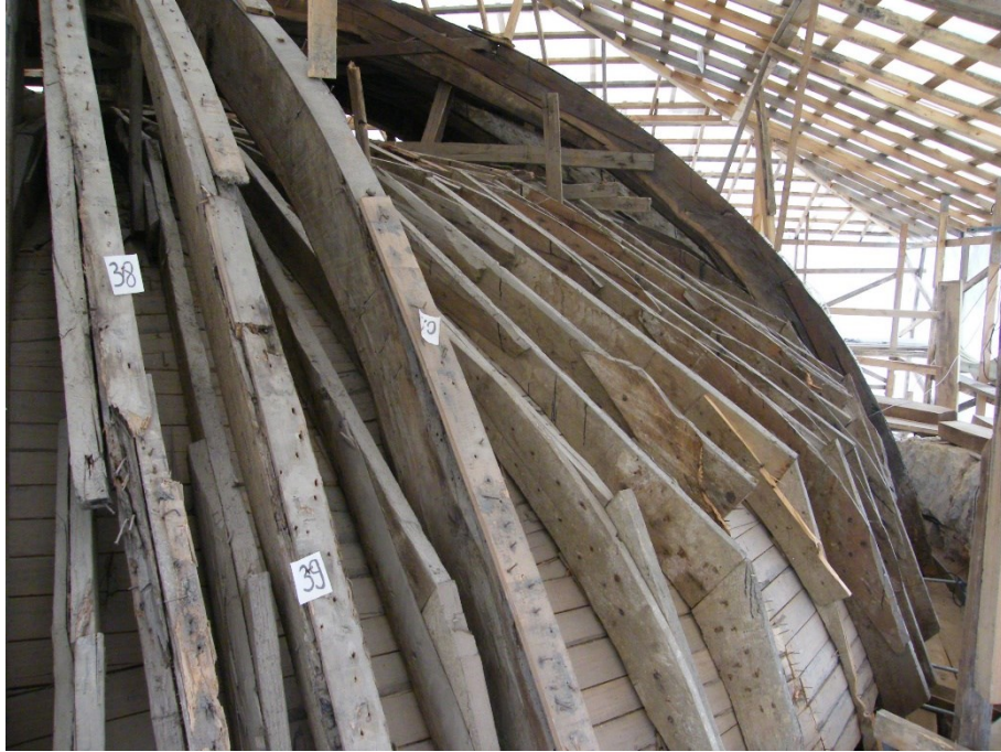
Şekil 4.12 Sadabat Camisi'nin kaburgalarında ahşap- çivi birleşimlerindeki renk değişimi, (VGM I. Bölge Arşivi)
