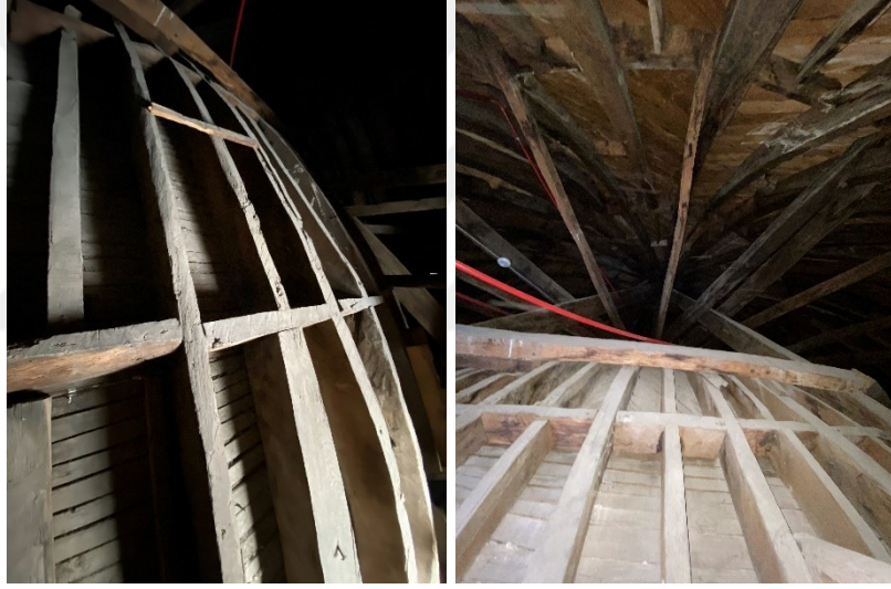
Şekil 2.165 Hünkâr Sofası'nın içteki kubbesinin konstrüksiyonu ve kubbe merkezine uzanan kaburgalar, 2021 (Kasaboğlu, E.)
