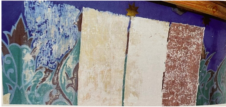
Şekil 2.324 Yıldız Hamidiye Camisi'nin 2013-2017 yılı restorasyonunda kubbe yüzeyinde yapılan raspa katmanları (Yücel vd., 2020)
