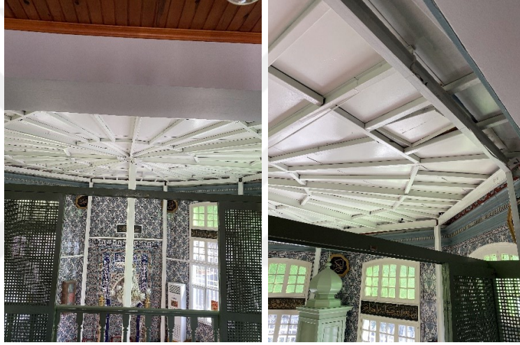
Şekil 2.387 Feridunpaşa Camisi'nin ahşap kubbesinin çelik konstrüksiyon ve metal levhalar ile kapatılması, 2021 (Kasaboğlu, E.)
