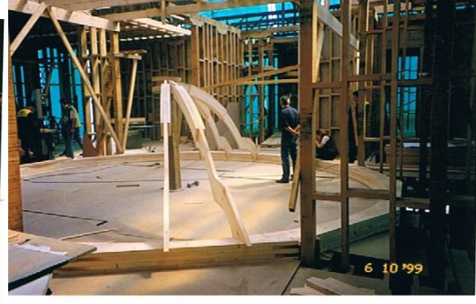
Şekil 2.369 Hadi Bey Yalısı'nın ahşap kubbesinin kaburgalarının sofa zemininde birleştirilmesi (Mustafa Dede Arşivi)
