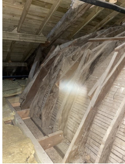
Şekil 3.4 Ertuğrul Tekke Camisi'nin düşey kaburgalı ve bağdadi çıtalı yüzeyi, 2021 (Kasaboğlu, E.)
