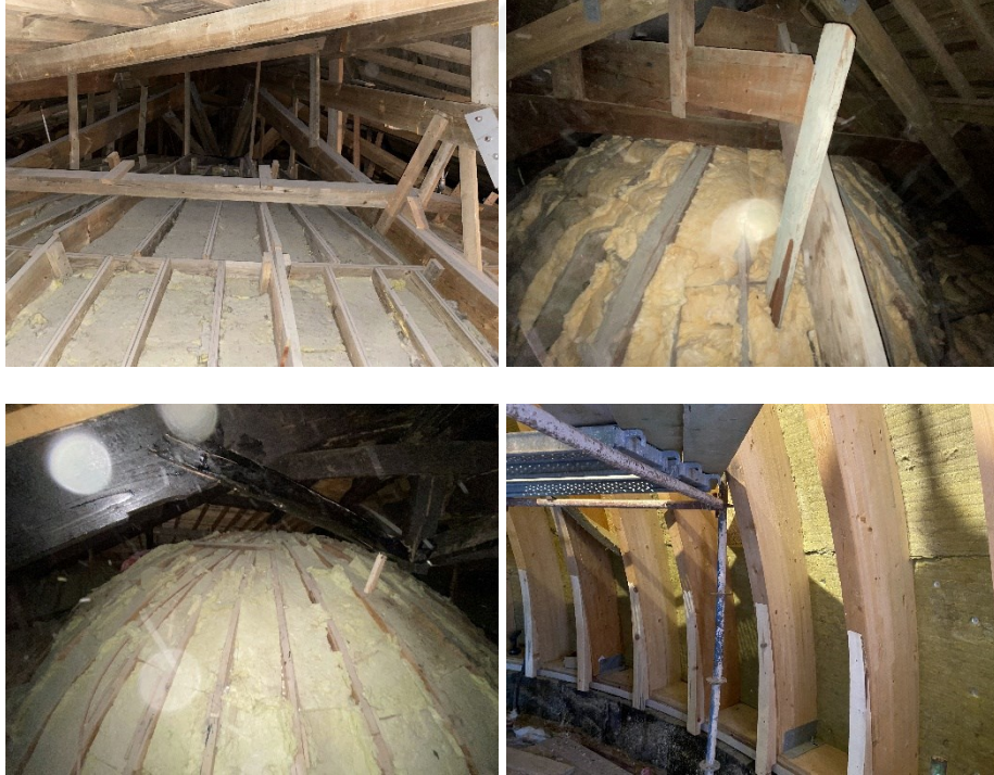
Şekil 4.32 Yenikapı Mevlevihanesi’nin Semahanesi, Feridun Paşa Camisi, Kaymak Mustafa Paşa Camisi ve Topkapı Sarayı Fatih Köşkü’nün kubbelerinin kaburgaları arasına yerleştirilen cam yünü malzeme (Kasaboğlu, E., 2021)
