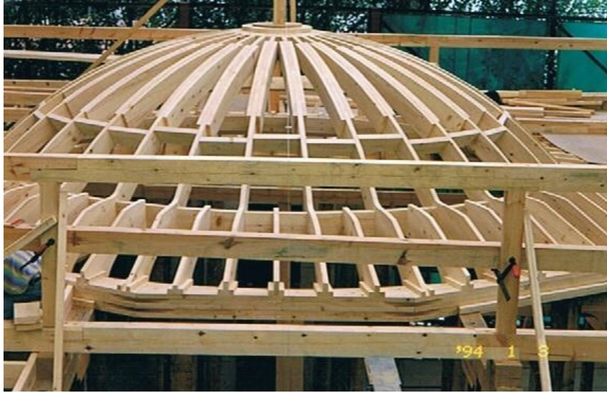
Şekil 2.372 Hadi Bey Yalısı'nın ahşap kubbesinin konstrüksiyonu (Mustafa Dede Arşivi)
