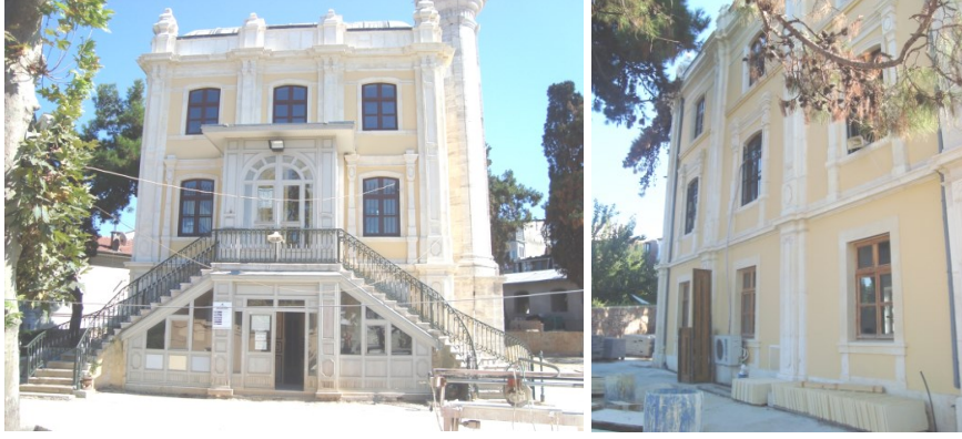
Şekil 2.347 Büyükada Hamidiye Camisi'nin kuzeybatı ve kuzeydoğu cepheleri (VGM II. Bölge Arşivi)
