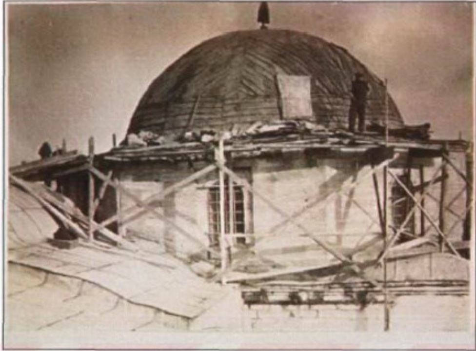
Şekil 3.38 Topkapı Sarayı Fatih Köşkü'nün 1942 yılı restorasyonunda ahşap kubbesinin sökülmesi (Karahasan, 2005)
