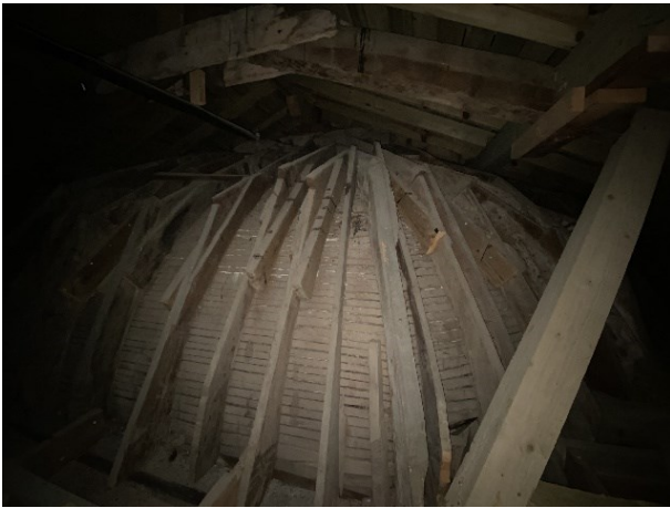
Şekil 3.4 Ertuğrul Tekke Camisi'nin düşey kaburgalı ve bağdadi çıtalı yüzeyi, 2021 (Kasaboğlu, E.)
