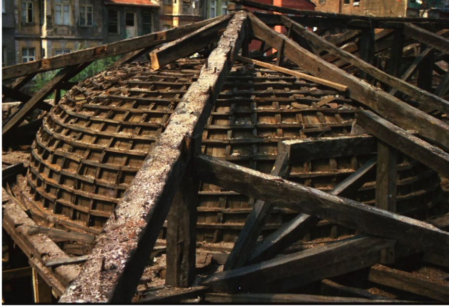
Şekil 3.30 Ahrida Sinagogu'nun 1992 restorasyonu öncesindeki düşey kaburgalı, üzeri geçme yatay ahşap elemanlı kubbesi (Atatürk Kitaplığı Hüsrev Tayla Arşivi)
