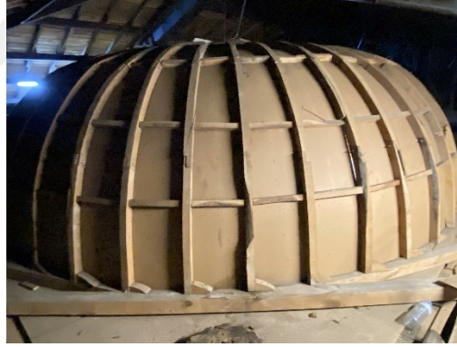
Şekil 2.15 Ahrida Sinagogu'nun özgün kubbe konstrüksiyonu (Atatürk Kitaplığı Hüsrev Tayla arşivi), onarım sonrası kubbe konstrüksiyonu, 2021 (Kasaboğlu, E.)
