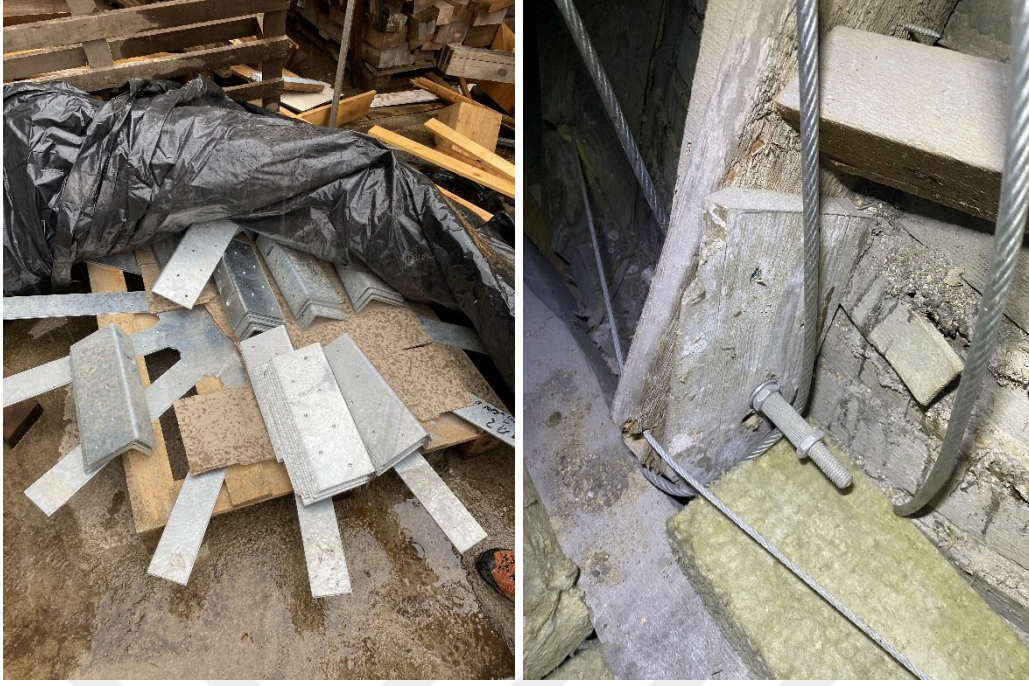
Şekil 4.40 Topkapı Sarayı Fatih Köşkü kubbesinin rekonstrüksiyonunda kullanılan paslanmaz çelik elemanlar ve Seyyid Nizam Tekkesi'nin kubbesine restorasyon sonrası ilave edilen çelik elemanlar, 2021 (Kasaboğlu, E.)
