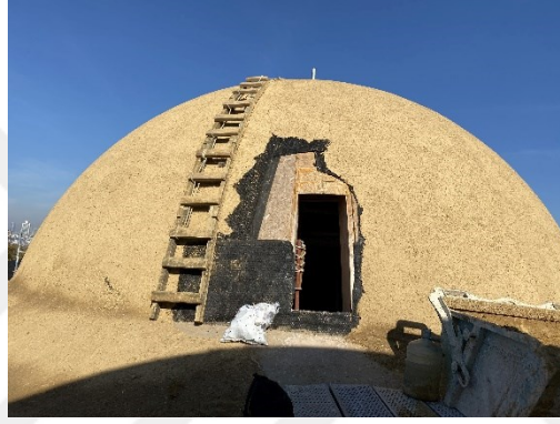
Şekil 2.44 Kubbelerin dış yüzeyine yalıtım malzemesi döşenmesi, 2021 (Kasaboğlu, E.)
