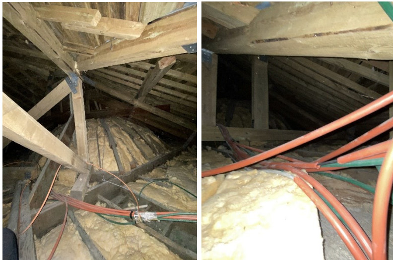
Şekil 2.395 Feneryolu Recai Yahya Camisi'nin çatı arasından geçen elektrik kabloları, 2021 (Kasaboğlu, E.)
