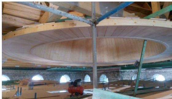
Şekil 2.81 Ferruh Kethüda Camisi'nin günümüzdeki ahşap kubbesinin ahşap konstrüksiyonu ve kubbe tabanının döşeme kirişleri altına yerleştirilmesi, 2021 (EKO Yapı arşivi)
