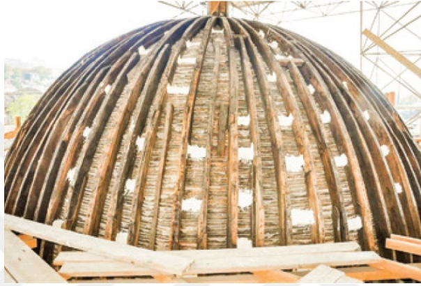
Şekil 2.243 Cezayirli Gazi Hasan Paşa Camisi'nin ahşap kubbesinin konstrüksiyonu (Kocatürk vd., 2013)
