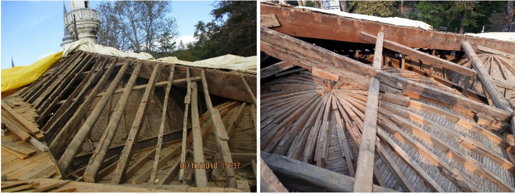
Şekil 2.232 Kaymak Mustafa Paşa Camisi'nin ahşap kubbesinin konstrüksiyonu, 2018 (Atölye 3 Mimarlık Arşivi)
