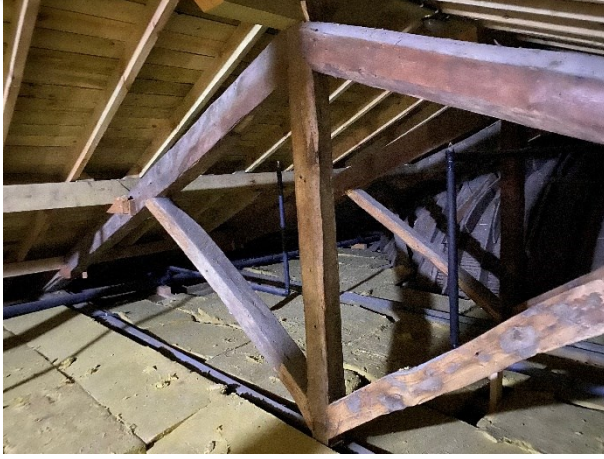
Şekil 2.341 Ertuğrul Tekke Camisi'nin ahşap kubbesinin kırma çatı altındaki görünüşü ve ahşap kubbesinin konstrüksiyonu, 2021 (Kasaboğlu, E.)
