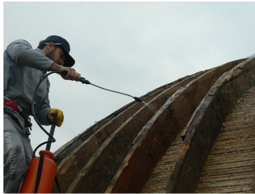
Şekil 2.330 Yıldız Hamidiye Camisi'nin ahşap kubbe elemanlarının empenye edilmesi (VGM I. Bölge Arşivi)
