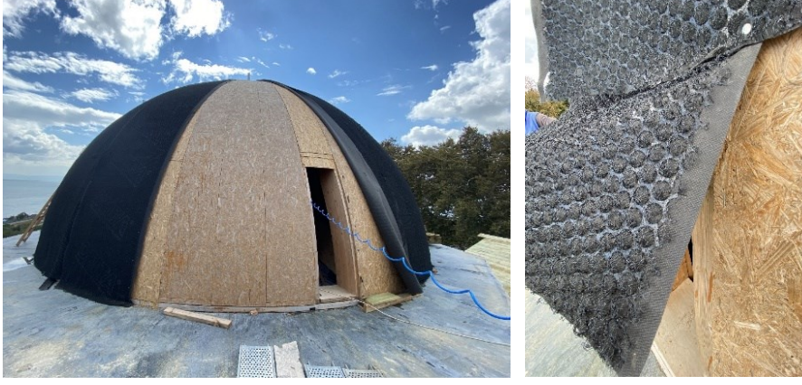
Şekil 2.44 Kubbelerin dış yüzeyine yalıtım malzemesi döşenmesi, 2021 (Kasaboğlu, E.)
