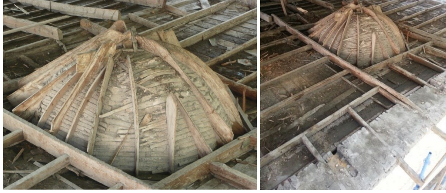
Şekil 2.304 Seyyid Nizam Cami- Tevhidhanesi'nin ahşap kubbe konstrüksiyonunun restorasyon öncesi görünüşü (Yılmaz Yapı Arşivi)
