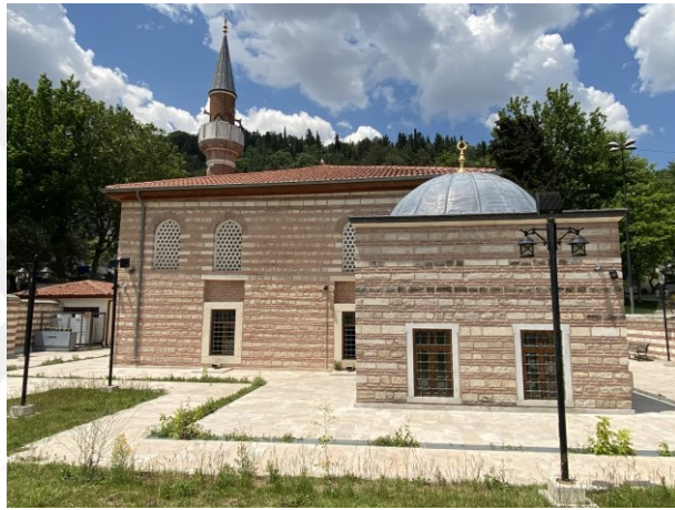
Şekil 2.71 Şahsultan Camisi'nin güney cephesi, 2021 (Kasaboğlu, E.)
