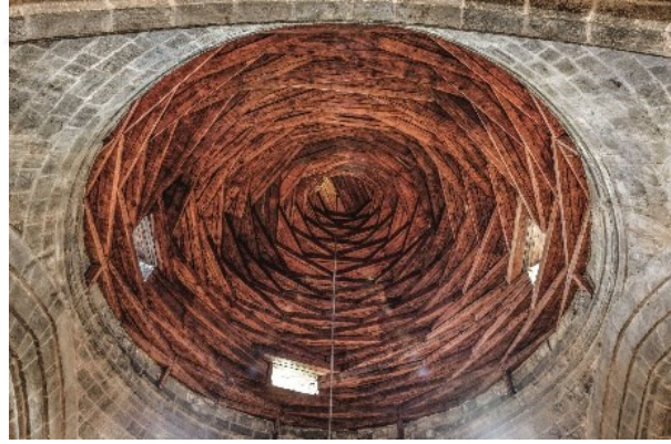
Şekil 1.8 Erzurum Ulu Camisi kırlangıç (tüteklikli örtü) kubbesi (Alver, 2020)
