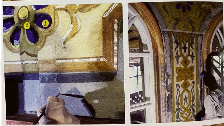
Şekil 2.326 Yıldız Hamidiye Camisi'nin 2013-2017 yılı restorasyonunda kubbe kasnağı pencere altı ve pencere kotunda yapılan raspa çalışmaları (Yücel vd., 2020)
