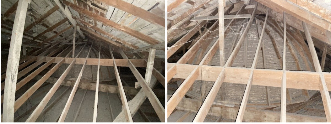
Şekil 2.362 Tütüncü Mehmet Efendi Camisi'nin ulaşılabilen 1. ahşap kubbesinin konstrüksiyonu, 2021 (Kasaboğlu, E.)
