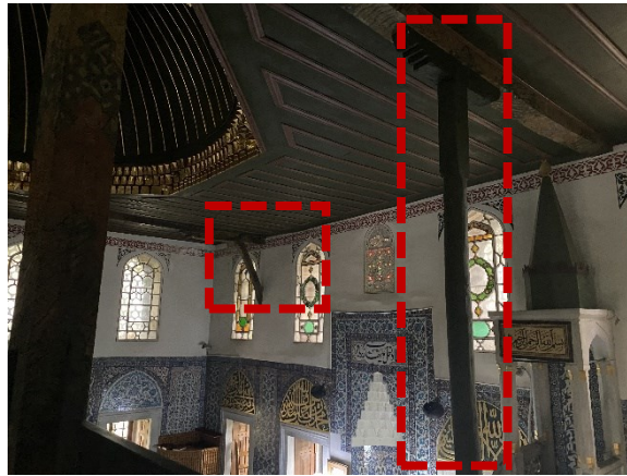
Şekil 2.90 Tavan döşemesini taşıyan ahşap dikme ve duvardan eğimli çıkan payanda, 2020 (Kasaboğlu, E.)
