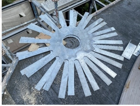
Şekil 2.42 Kubbeler için tasarlanmış ahtapot adı verilen metal parça, 2021 (Kasaboğlu, E.)
