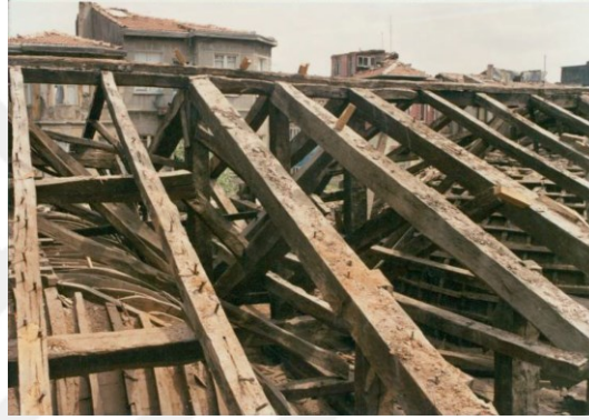
Şekil 2.16 Restorasyon öncesi iç mekâna bakan kubbe yüzeyi ahşap kaplamaları (Atatürk Kitaplığı Hüsrev Tayla arşivi), restorasyon sonrası kubbe yüzeyi ahşap kaplamaları, 2021 (Kasaboğlu, E.)
