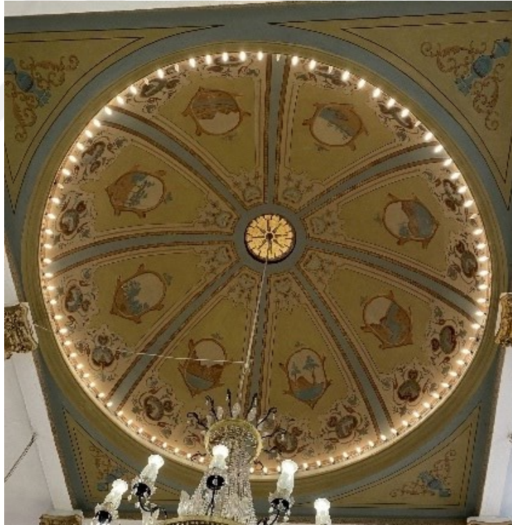
Şekil 2.189 Maalemed Shalom Sinagogu'nun ahşap kubbesinin iç mekândan görünüşü, 2021 (Kasaboğlu, E.)
