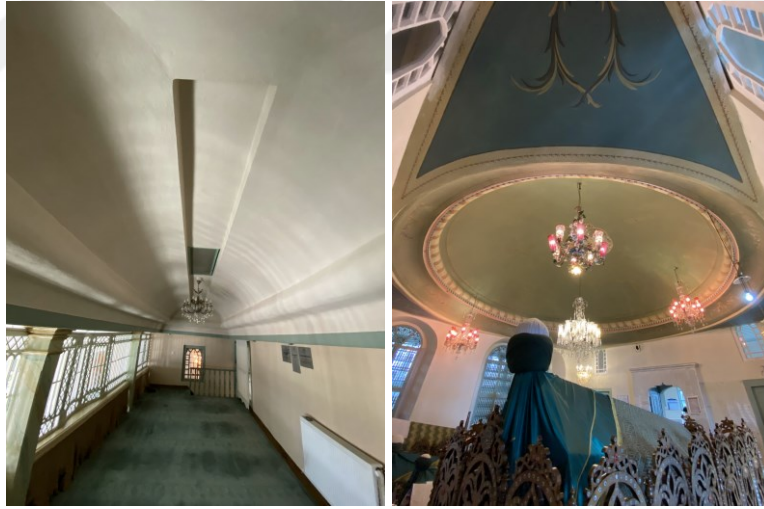
Şekil 2.60 Yahya Efendi Camisi'nin hünkâr mahfilini örten ahşap tonoz, Yahya Efendi Türbesi'nin ahşap kubbesi, 2021 (Kasaboğlu, E.)
