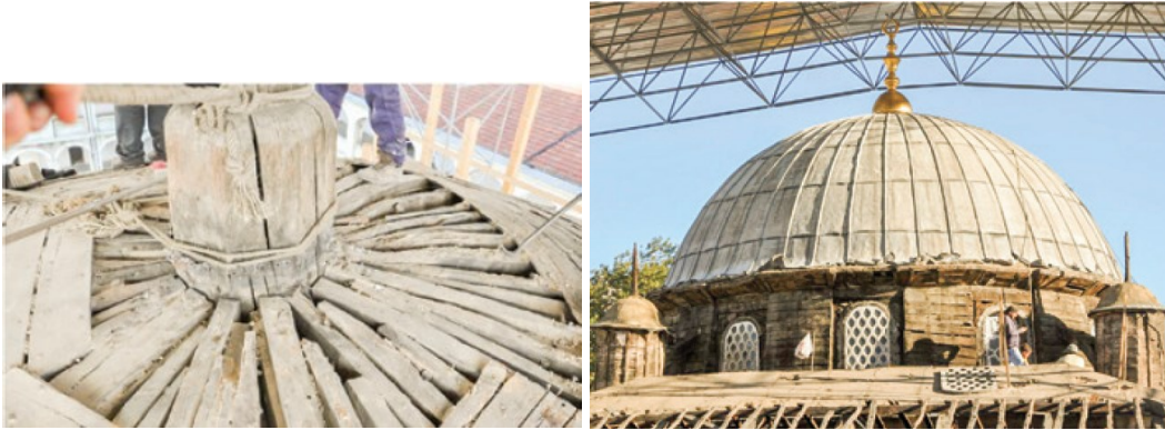
Şekil 2.244 Cezayirli Gazi Hasan Paşa Camisi'nin kubbesinin merkezinde yer alan ahşap dikme ve ahşap kasnağı (Kocatürk vd., 2013)
