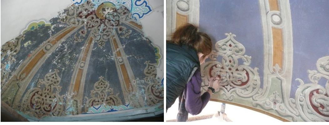
Şekil 2.307 Seyyid Nizam Cami- Tevhidhanesi'nin ahşap kubbesinin kalemişlerinin raspası ve canlandırılması (Yılmaz Yapı Arşivi)
