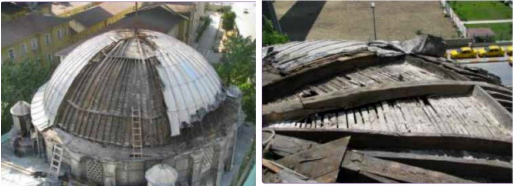
Şekil 2.261 Kumbarhane Camisi'nin ahşap kubbesinin konstrüksiyonu (Alioğlu, 2015)
