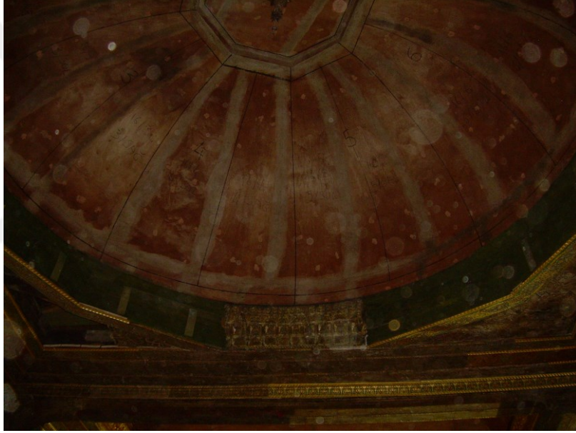
Şekil 2.131 Ahşap kubbenin restorasyon öncesindeki özgün ahşap kaplamaları, restorasyon sırasında kubbe yüzeyinin su kontrası ile kaplanması (Hatice Karakaya Mimarlık Bürosu arşivi)
