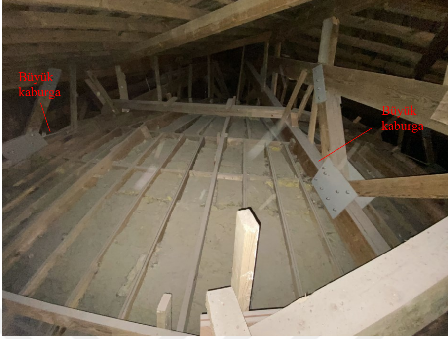
Şekil 2.104 Ahşap kubbe konstrüksiyonundaki iki büyük kaburganın arasındaki ahşap elemanlar, 2021 (Kasaboğlu, E.)
