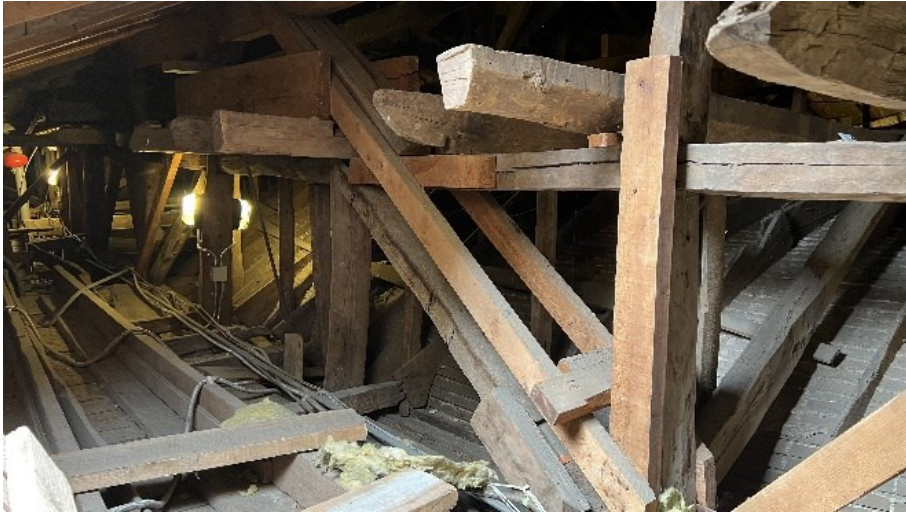
Şekil 3.33 Sadullah Paşa Yalısı'nın kubbesinin düşey kaburgalı ve bağdadi çıtalı yüzeyi, 2022 (Tek- Esin Vakfı, Doret Bardavit Arşivinden)
