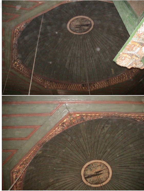
Şekil 2.92 2008 restorasyonu sırasında, uygulama öncesi kubbenin iç mekândan görünüşü (İBB arşivi)
