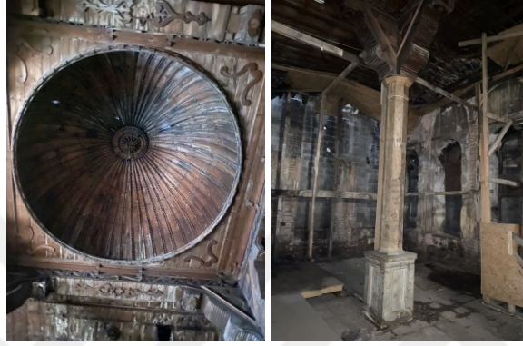
Şekil 2.25 Mayor Sinagogu'nun ahşap kubbesi, kaplamaları ve kubbeyi destekleyen dikme, 2021 (Kasaboğlu, E.)
