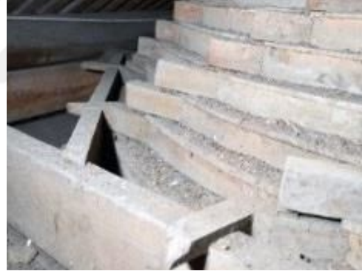
Şekil 1.2 Çin'in Ninghai bölgesinde 1920'lerde inşa edilen spiral kubbenin çatı altından görünüşü (Ye ve Fivet, 2018)
