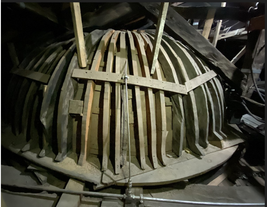
Şekil 3.18 Yeni Cami Hünkâr Kasrı'nın kubbesinin düşey kaburgalı ve ahşap kaplamalı yüzeyi, restorasyon sonrası, 2022 (Kasaboğlu, E.)
