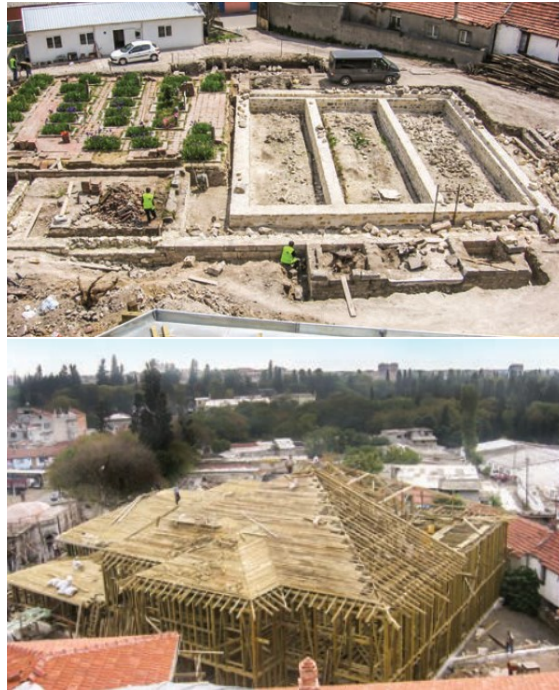
Şekil 2.101 2007 yılı restorasyonunda yapılan taş temel ve ahşap karkas sistem (Olgun, 2007)
