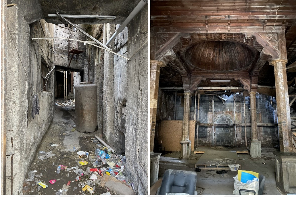
Şekil 4.43 Mayor Sinagogu’ndaki bozulmalar, 2021 (Kasaboğlu, E.)
