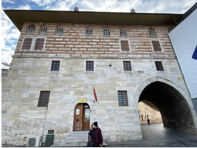
Şekil 2.125 Hünkâr kasrının kuzeybatı cephesi restorasyondan öncesi, 2008 (VGM I. Bölge arşivi) ve restorasyon sonrası görünüşü, 2021 (Kasaboğlu, E.)
