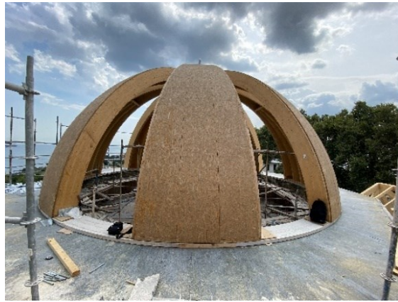
Şekil 2.40 Fatih Köşkü ahşap kubbelerinin yapım aşamaları, 2021 (Kasaboğlu, E.)
