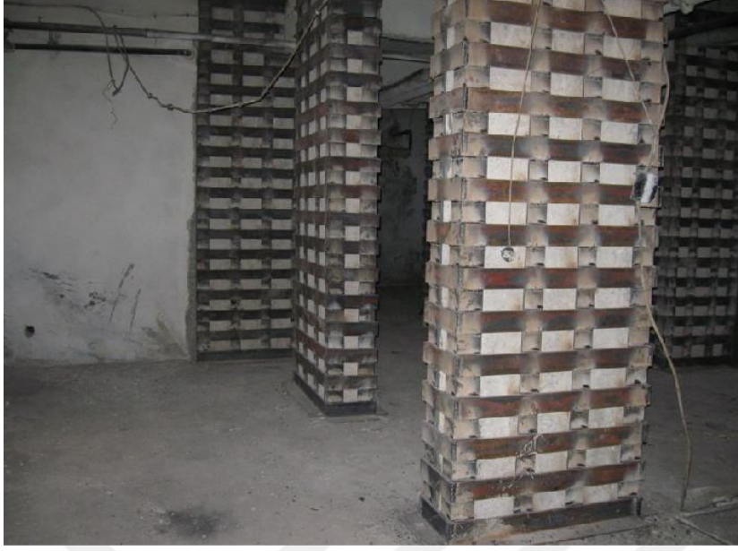
Şekil 3.5. Kolonların çelik ile sarılması (Şik, 2014)
