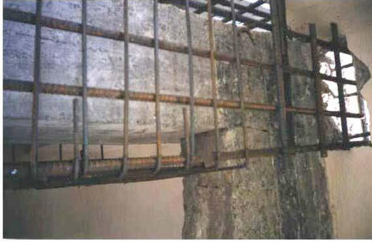
Şekil 3.9. Kirişlerin betonarme ile sarılması (Öncü, 2011)
