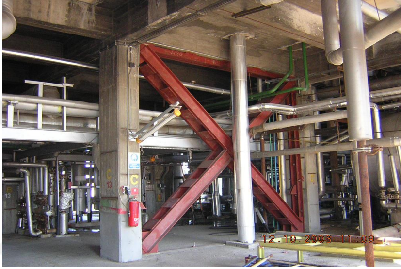
Şekil 3.18. Taşıyıcı sistemin çelik çaprazlarla güçlendirilmesi (Yıldırım, 2008)
