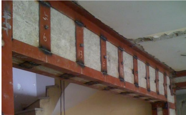
Şekil 3.8. Kirişlerin çelik ile sarılması (Şik, 2014)
