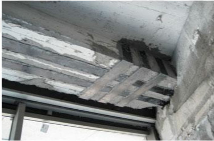
Şekil 3.11. Lifli polimerler ile kirişlerin eğilme kapasitelerinin artırılması (Şik, 2014)
