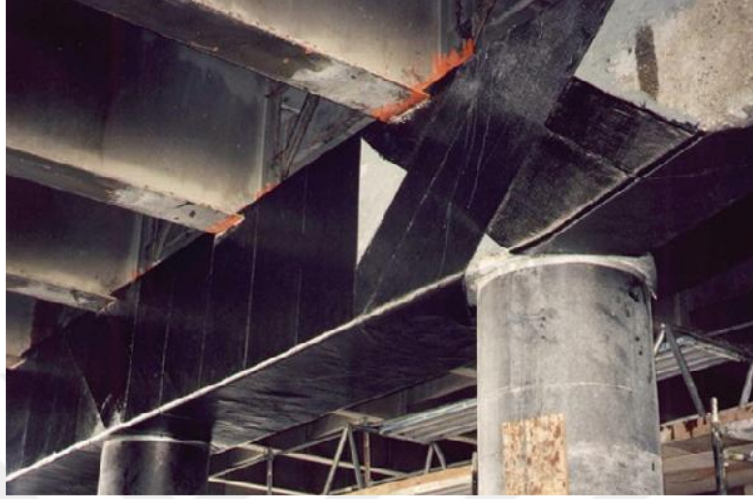
Şekil 3.10. Lifli polimerler ile kirişlerin kesme dayanımının artırılması (Şik, 2014)
