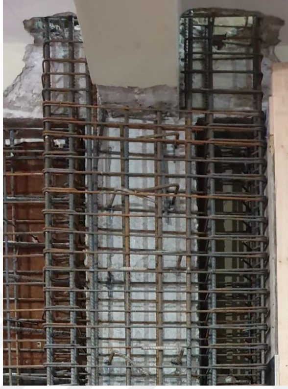
Şekil 3.4. Kolonların betonarme ile sarılması (Karatepe, 2021)
