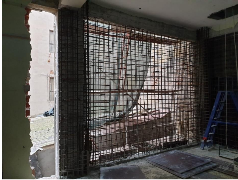
Şekil 3.14. Sisteme yeni betonarme perde eklenmesi (Karatepe, 2021)
