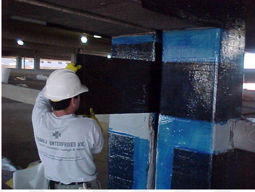
Şekil 3.6. Kolonların etrafının lifli polimerler (LP) ile sarılması (Yıldırım, 2008)
