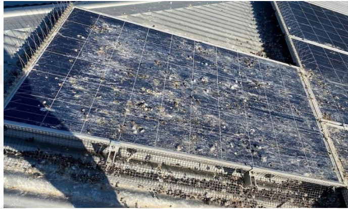
Şekil 2.9 Kuş pisliği olan güneş paneli [37]
