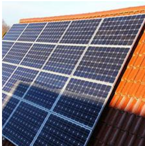
Şekil 2.8 Gölgeleme güneş paneli [37]
