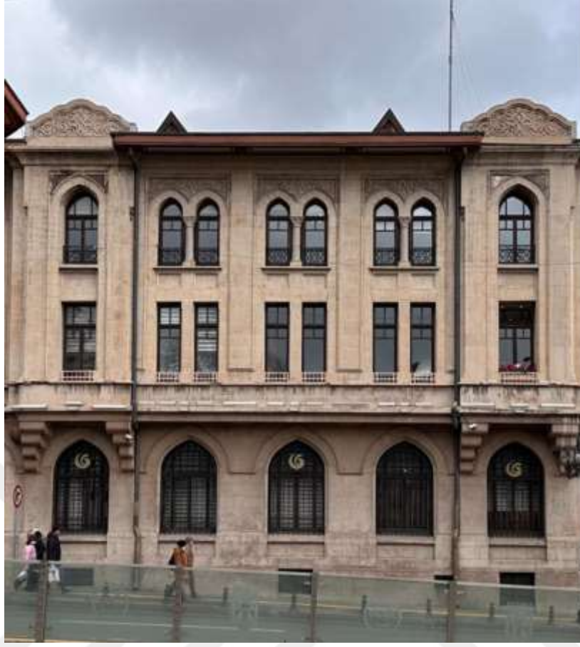
Resim 18. Yunus Emre Enstitüsü Bulvar Cephesi.
