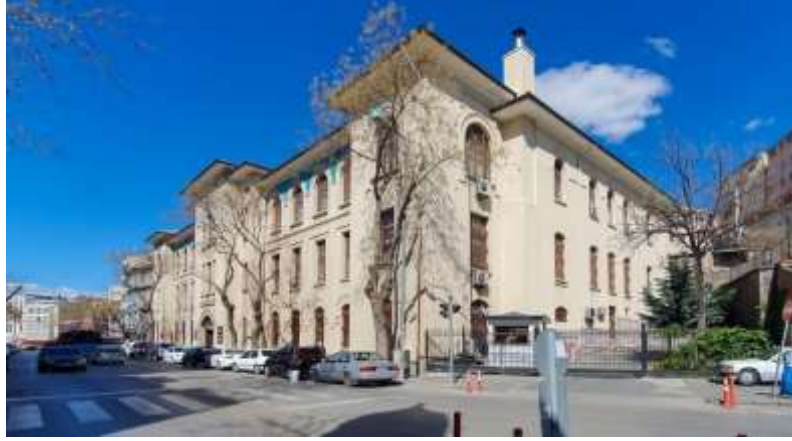
Resim 4. Eski Ankara Adliye Binası.
