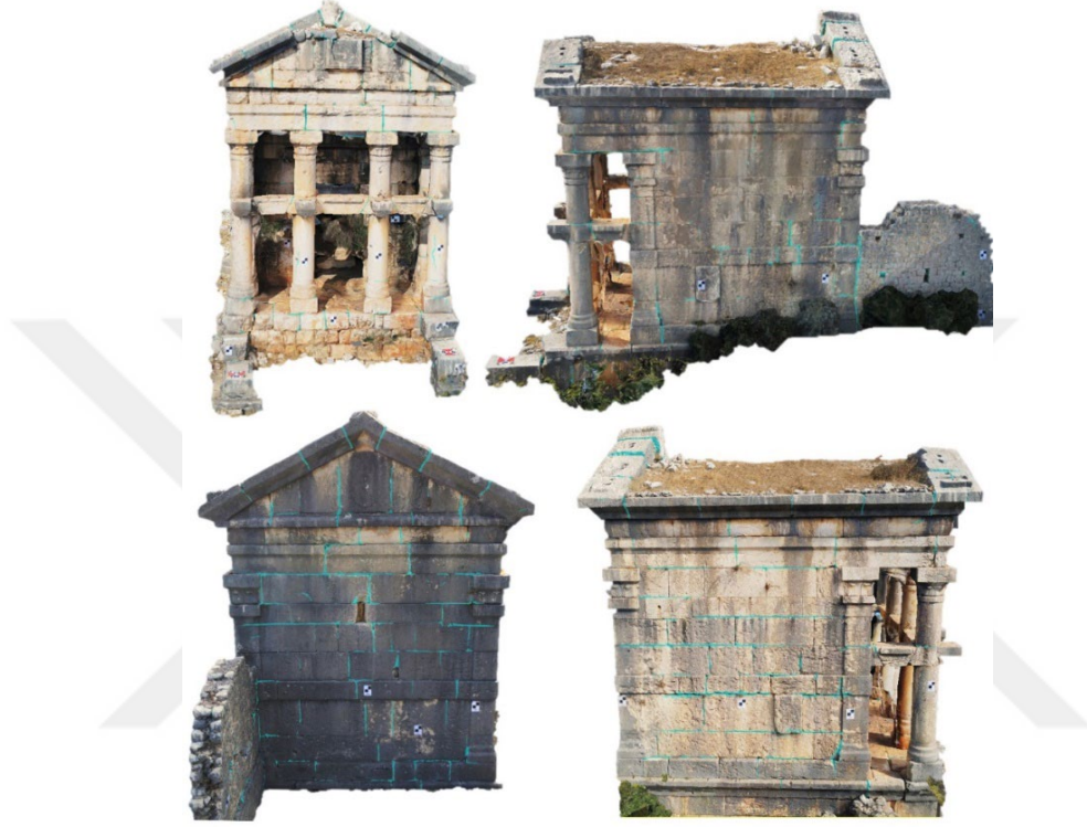
Şekil 4.31 Kale için HADİ modelinin farklı cephelerdeki çatlaklar.
