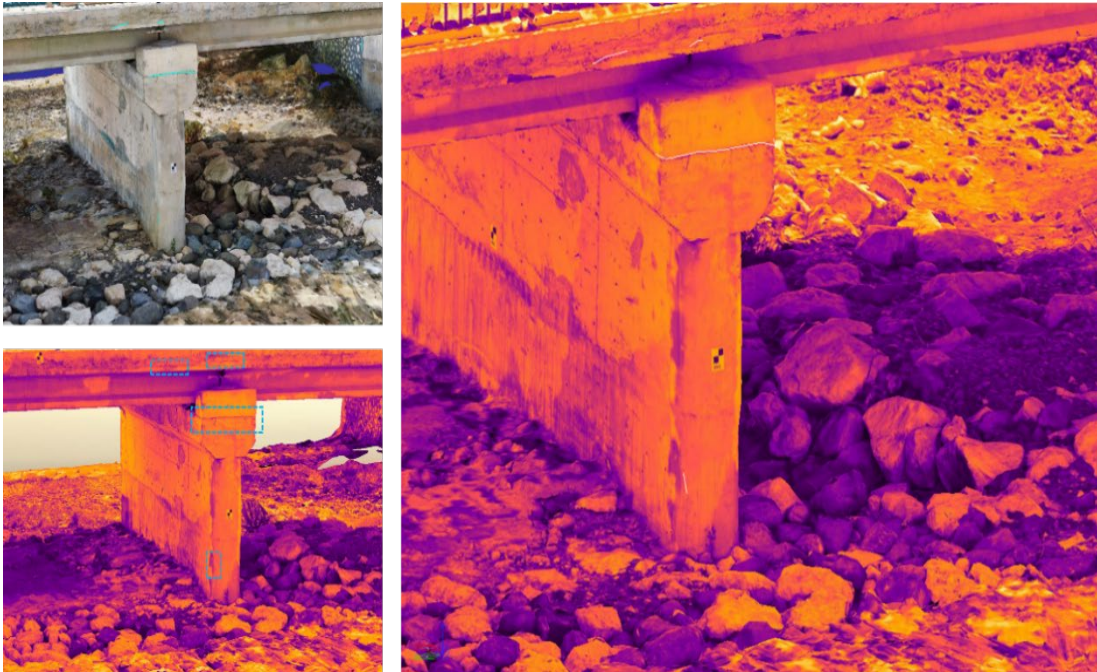
Şekil 4.25 Köprü yapısının kuzey tarafına ait termal dokulu D1 model.
