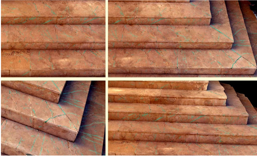
Şekil 4.7 Merdiven için otomatik tespit edilen çatlakların (mavi çizgiler) gösterimi.
